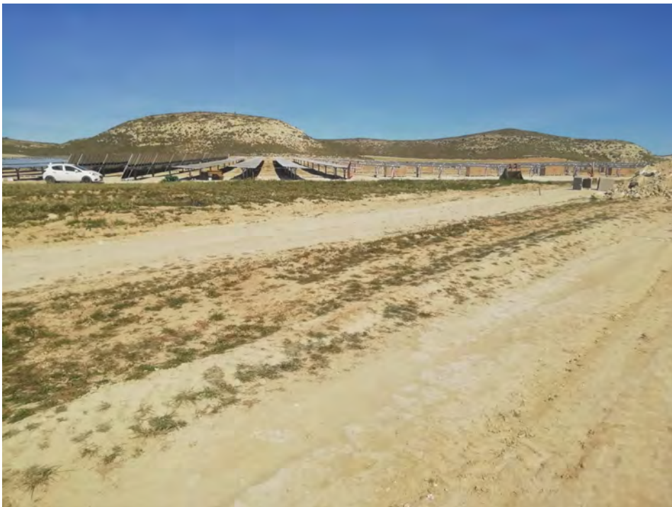
Imagen 14: Zona de paso compactada encima de acopio de tierra vegetal.
