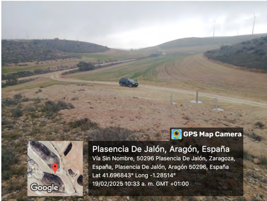
Fig. 7: Zona de HIC afectada por excavación de los apoyos de la LAAT.
