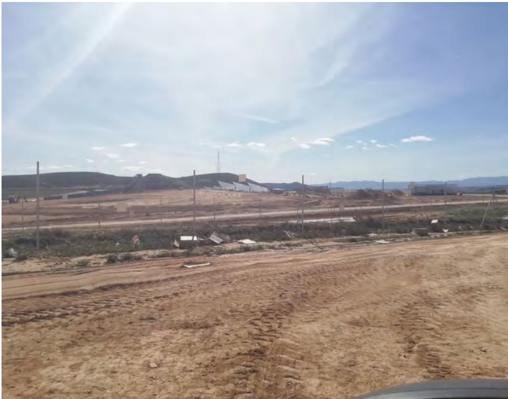
Fig. 2: Residuos en vallado.
