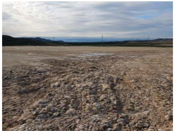
Figura 2. Cárcavas en el terreno a causa de erosión.
