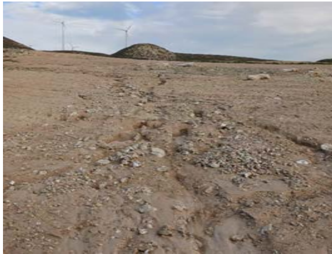
Figura 1. Cárcavas en el terreno a causa de erosión.
