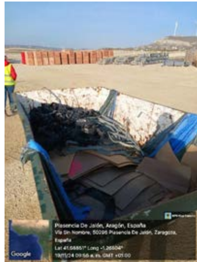
Figura 2. Contenedor de hormigón con mezcla de residuos
