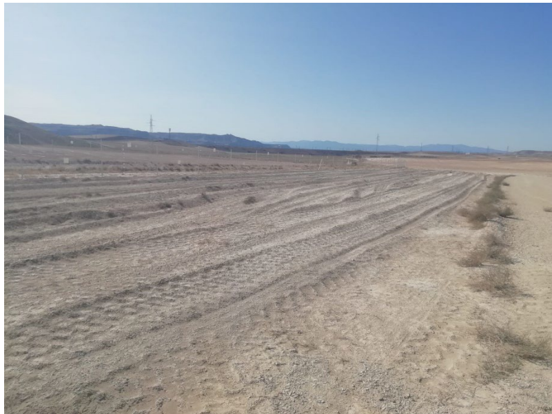
Figura 2: Acopio de tierra vegetal.
