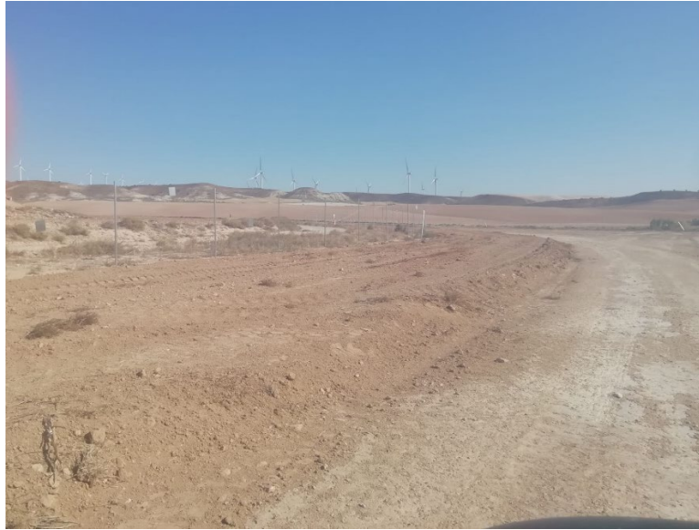
Figura 1: Acopio de tierra vegetal.
