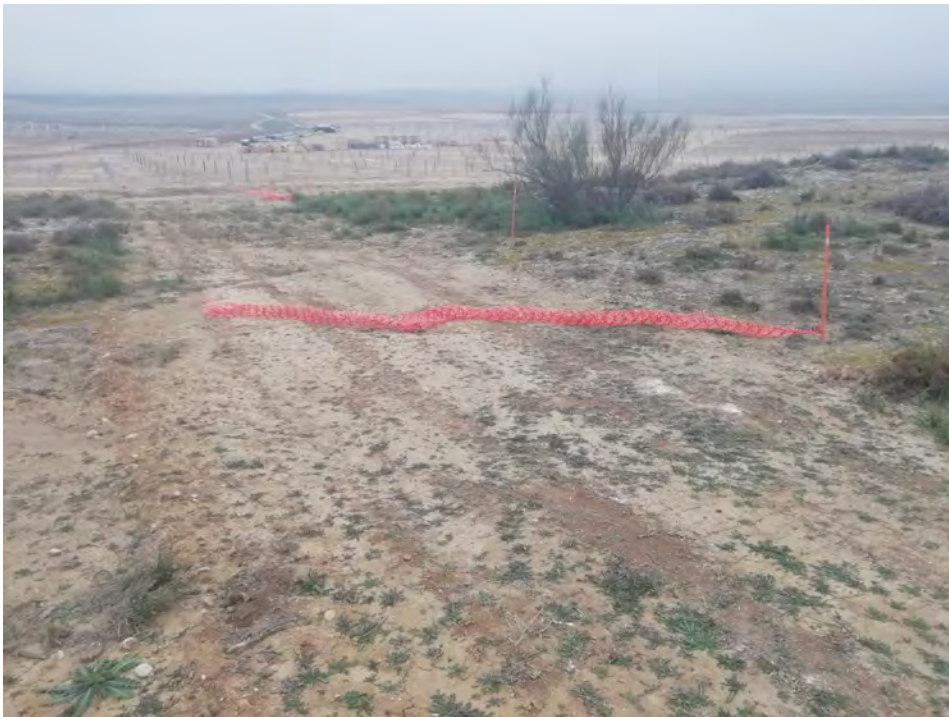
Imagen 6: Balizado mal colocado y rodadas en zona de vegetación.
