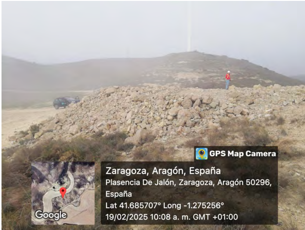
Fig. 3: Zona de HIC afectada por excavación de los apoyos de la LAAT.
