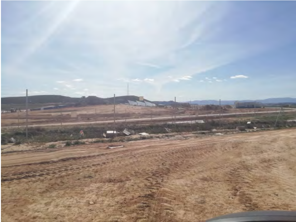
Imagen 1: Residuos en vallado perimetral.
