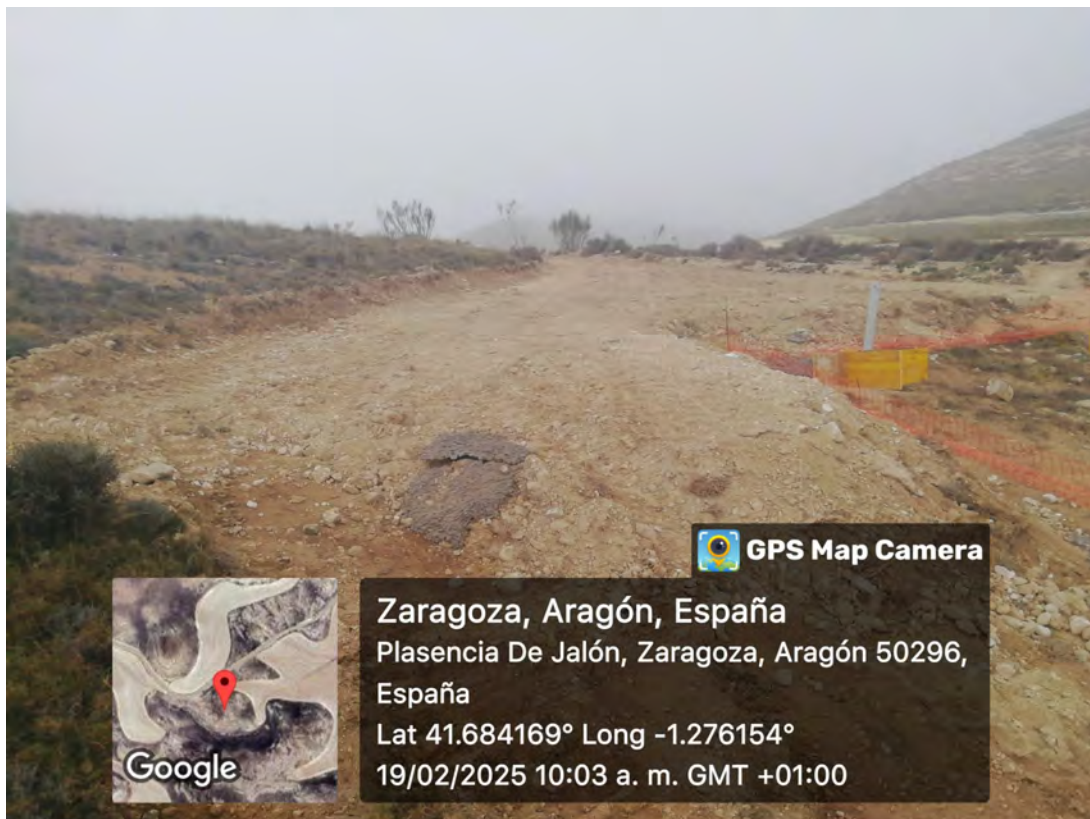
Fig. 2: Zona de HIC afectada por excavación de los apoyos de la LAAT.
