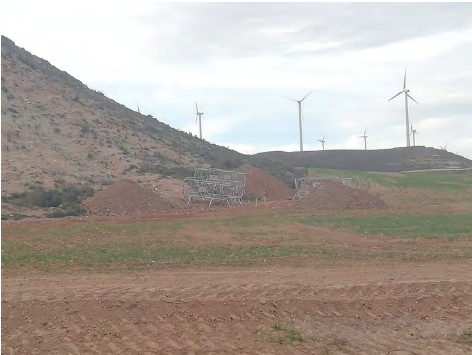
Imagen 12: Comienzo de trabajos en apoyo de la LAAT .
