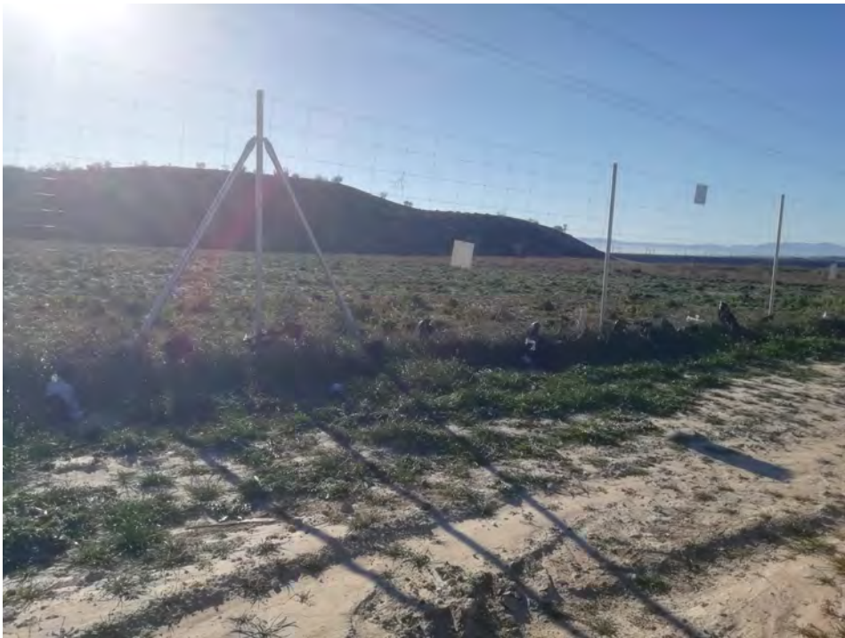
Imagen 4: Residuos en vallado perimetral.
