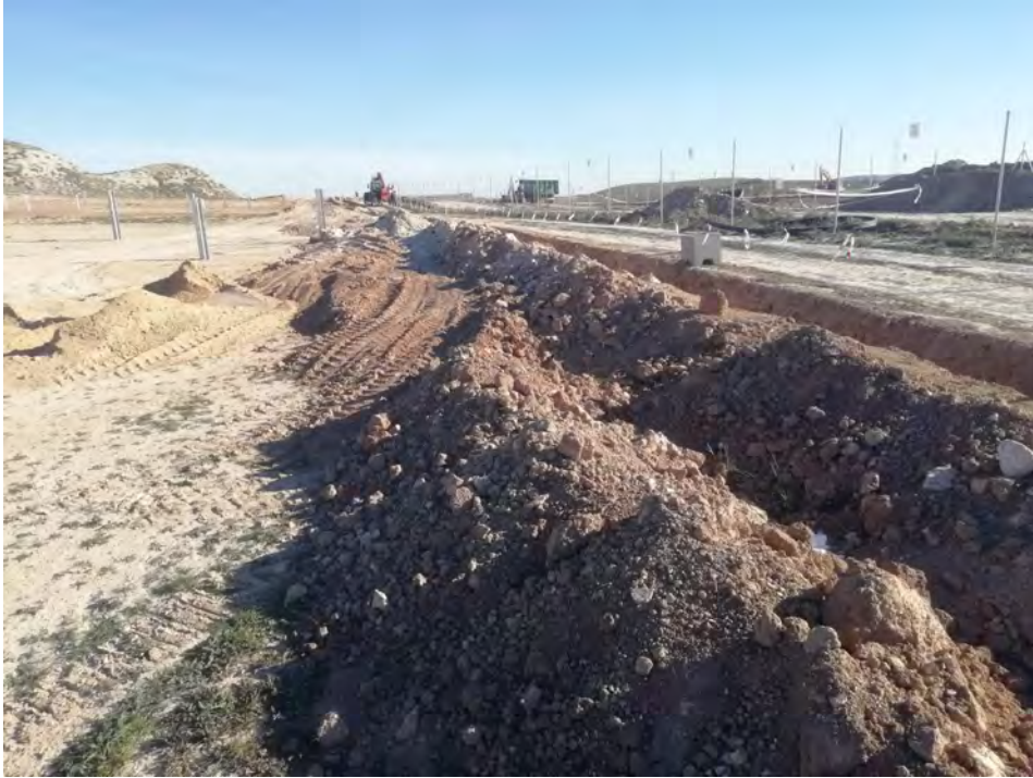
Imagen 9: Zanja con separación de tierras.
