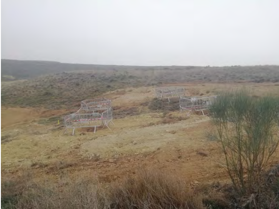
Imagen 11: Comienzo de trabajos en apoyo de la LAAT.
