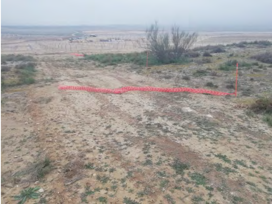
Imagen 7: Balizado mal colocado y rodadas en zona de vegetación.
