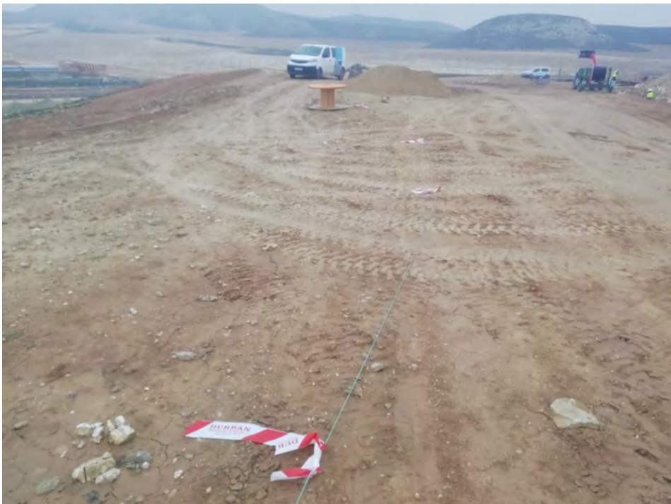
Imagen 8: Balizado mal colocado y rodadas en zona de vegetación.
