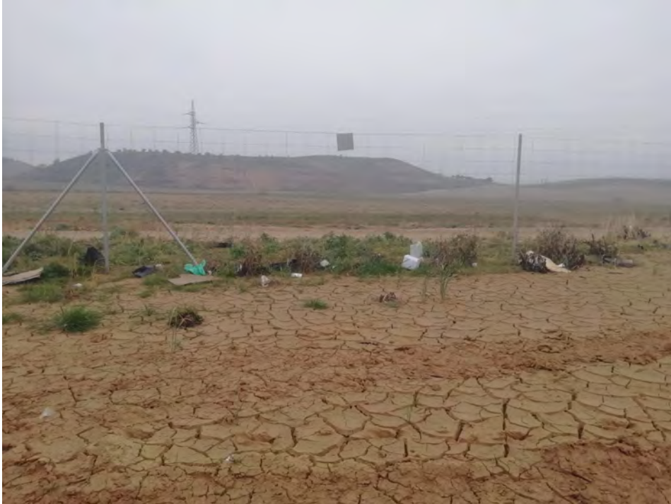
Imagen 3: Residuos en vallado perimetral.
