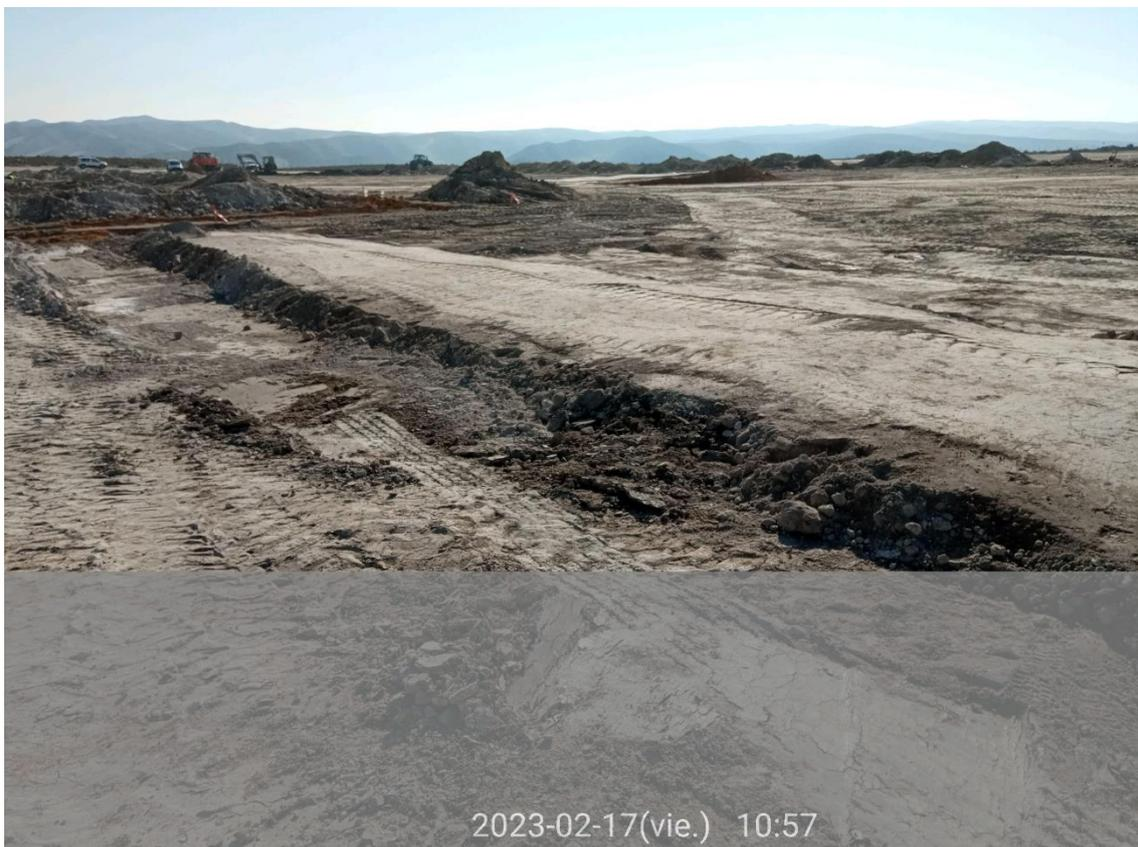
*Ilustración 9. Zanja cubierta con la capa superficial de tierra previamente retirada.*
