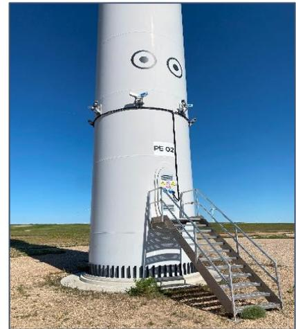
*Dispositivo 3DObserver instalado en el aerogenerador PE-02*
