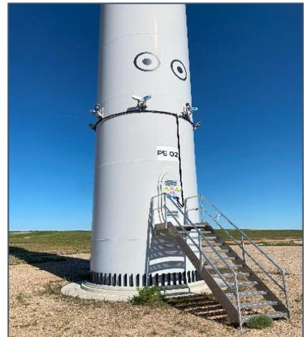
*Dispositivo 3DObserver instalado en el aerogenerador PE-02*
