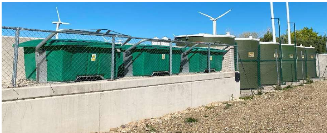
Contenedores para almacenamiento y autohidrólisis de cadáveres de porcino, ubicados en el núcleo ganadero
