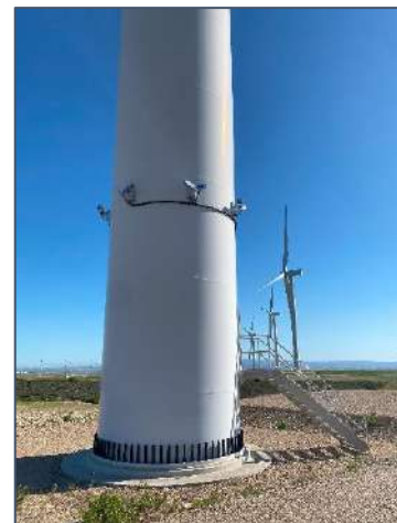
en el aerogenerador T-01
