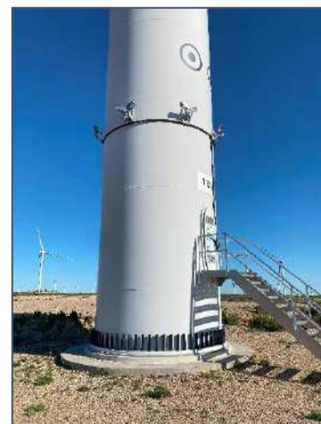
Dispositivo 3DObserver instalado en el aerogenerador T-13
