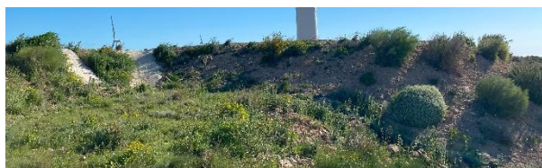
Estado general de los taludes restaurados (T-14)
