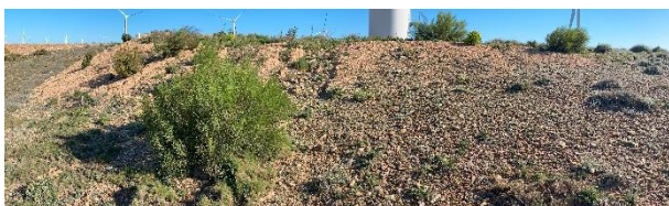
Estado general de los taludes restaurados (T-13)
