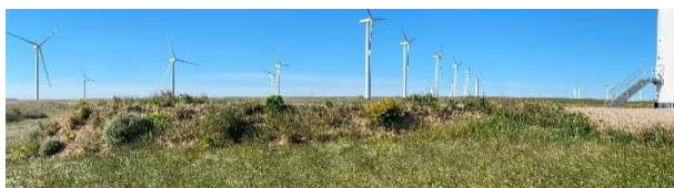
Estado general de los taludes restaurados (T-04)
