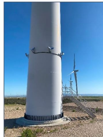
Dispositivo 3DObserver instalado en el aerogenerador T-01
