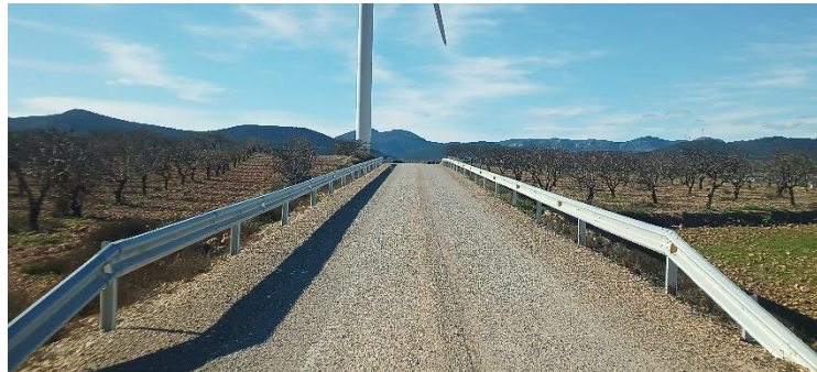
Figura 21: Fotografía vial de entrada al parque eólico Valdejalón II.
