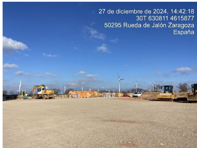
Figura 22: Plataforma del aerogenerador VAL II – 01 albergando material y vehículos pesados para la construcción de la planta fotovoltaica.
