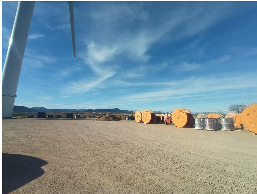
Figura 15: Plataforma del aerogenerador VAL II – 01 albergando material para la planta fotovoltaica.
