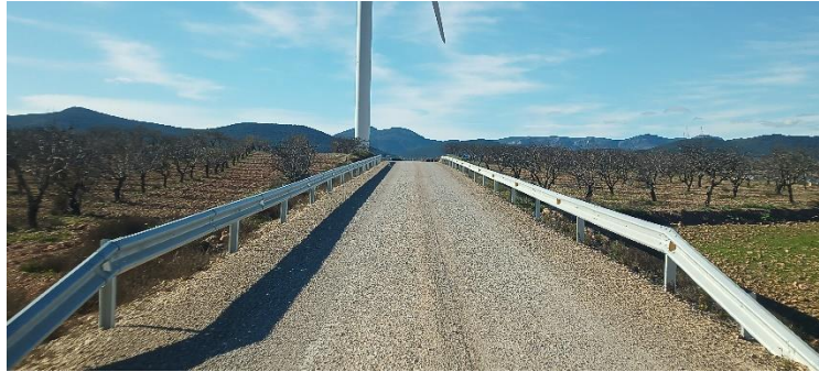
Figura 14: Fotografía vial de entrada al parque eólico Valdejalón II.
