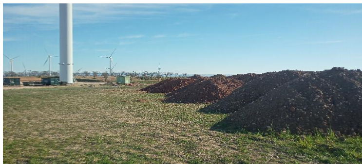
Figura 16: Movimiento de tierras dentro del diámetro del vuelo de las aspas de VAL II-01.
