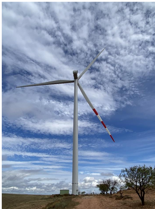
Figura 10: Foto del aerogenerador VAL II - 01 con la medida preventiva de pintado de pala.
