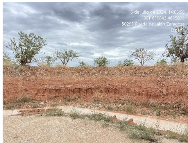
Figura 14: Taluz al Sureste del aerogenerador.
