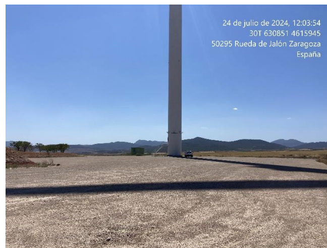
Figura 13: Plataforma del aerogenerador VAL II – 01.
