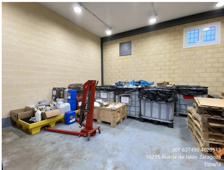
Figura 16: Interior del almacén de residuos peligrosos del PE Valdejalón II.
