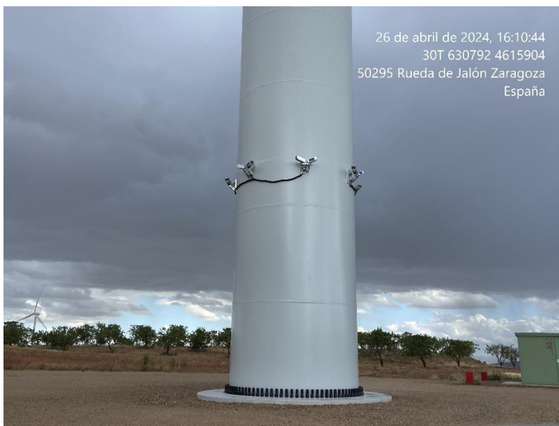
Figura 8: Sistema “3D Observer”, en el tubo del aerogenerador VAL II – 01.
