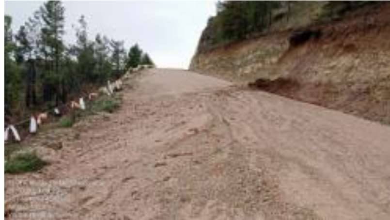
Fotografía 26: Erosión vial entre SEI-02-SEI-01
