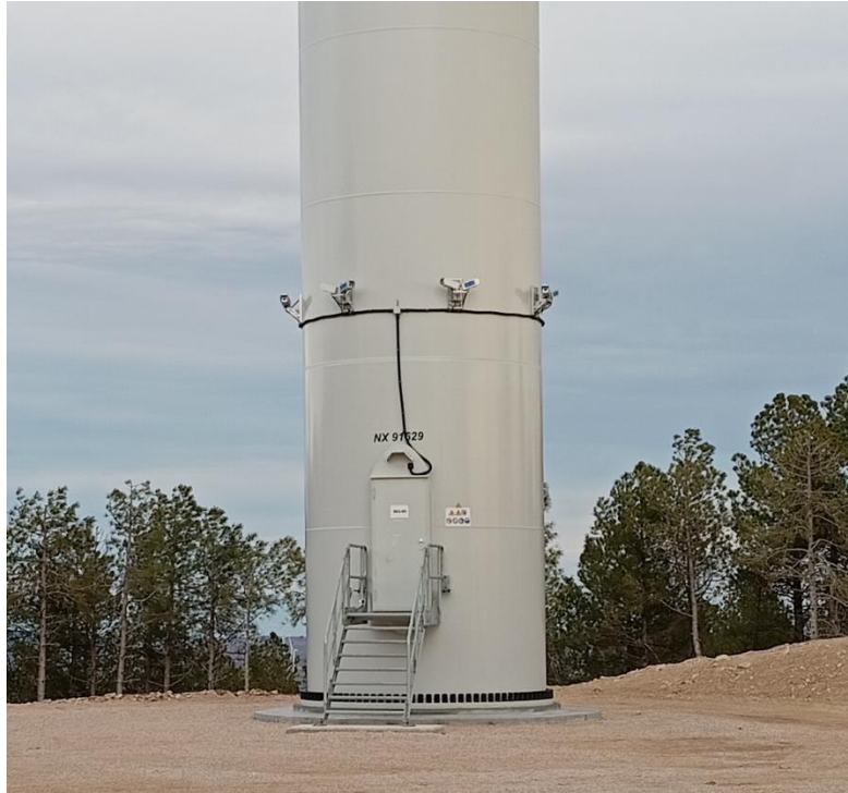
Fotografías 15 a 16: Señalización de las torres de los aerogeneradores
