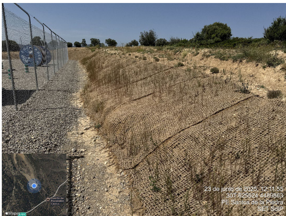
Fotografía 8. Malla de fibra de coco colocada en un pequeño talud de la SET revegetada
