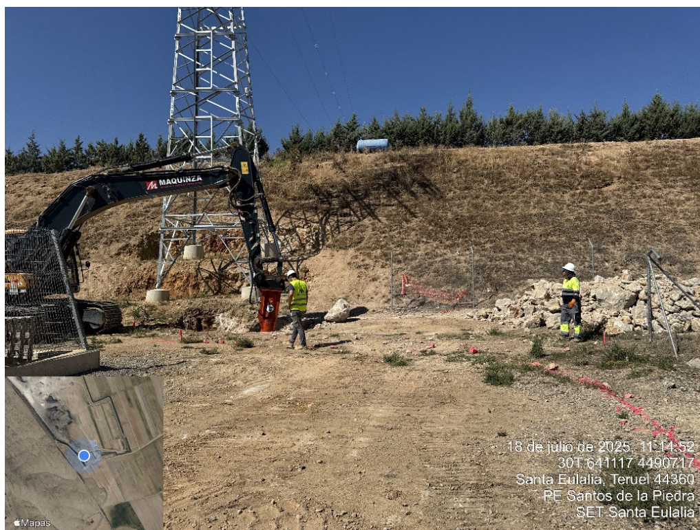
Fotografía 3. Apertura de zanjas
