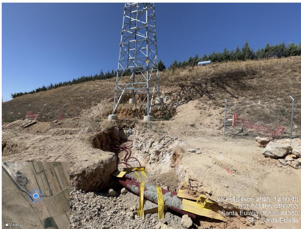
Fotografía 2. Cimentación del tubo corrugado para el paso de cable
