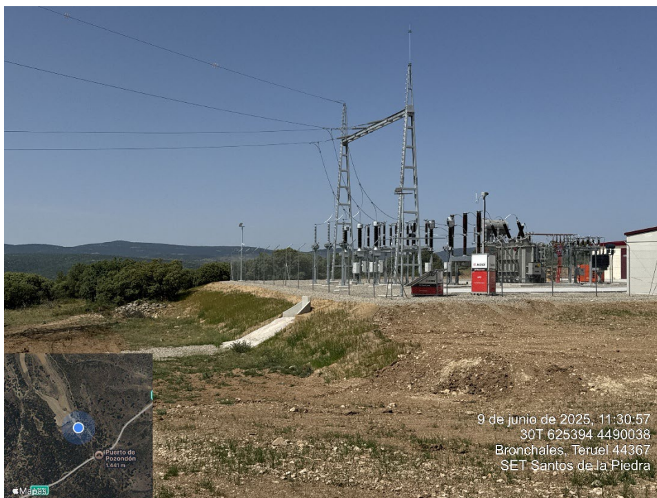
Fotografía 7. Revegetación en la fibra de coco colocada en un pequeño talud de la SET
