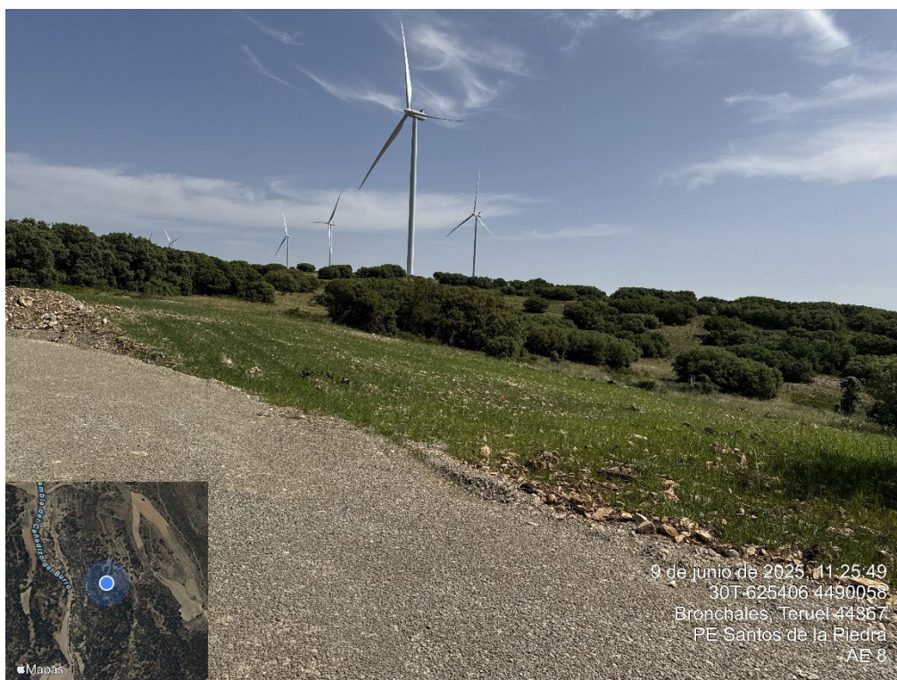
Fotografía 5. Revegetación sobre las zonas con extendido de tierra vegetal
