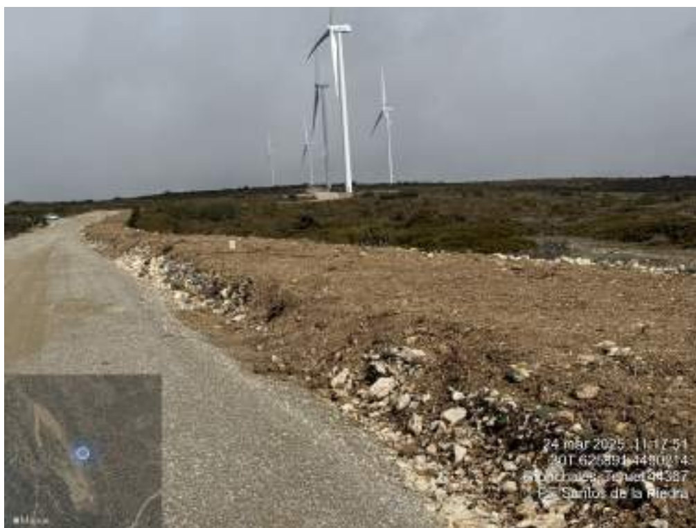
Fotografía 20. Tierra vegetal sobre la zanja de evacuación
