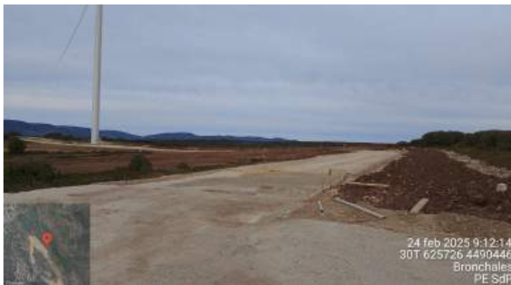
Fotografía 6. Encofrado para la cimentación del vial
