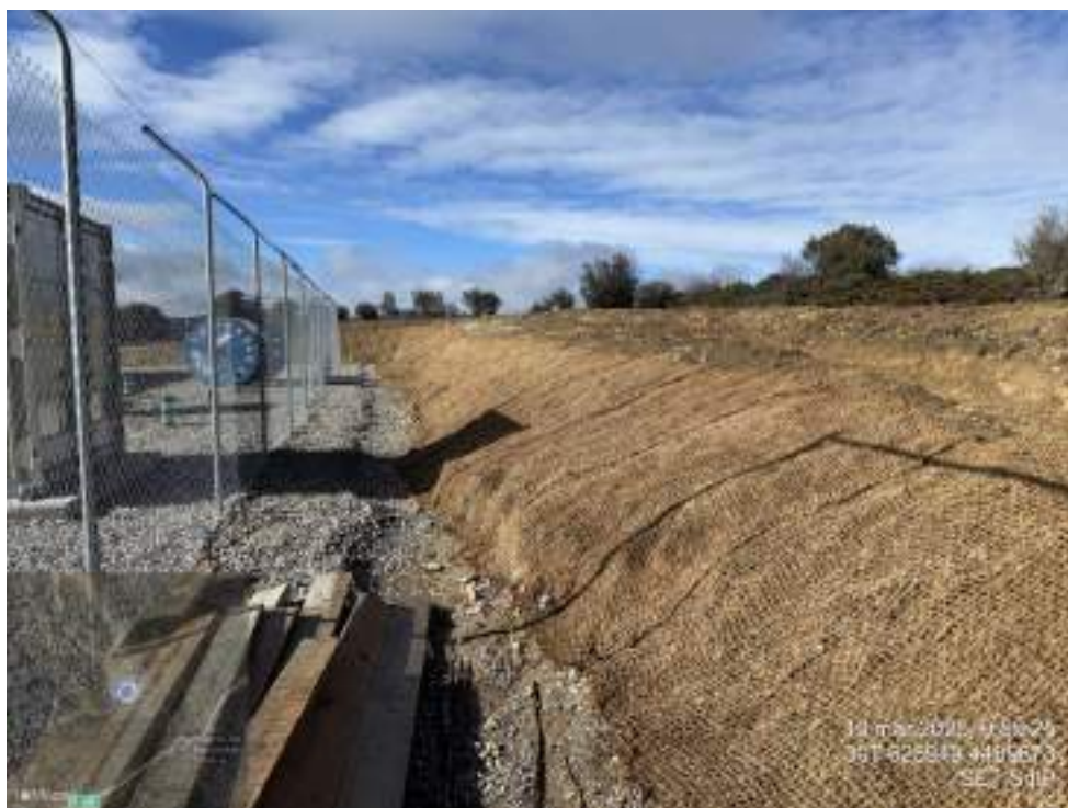
Fotografía 25. Malla de fibra de coco colocada en un pequeño talud de la SET pendiente de hidrosiembra
