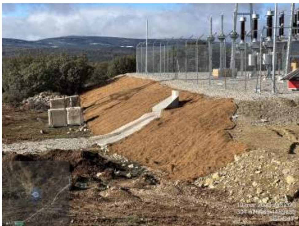
Fotografía 24. Malla de fibra de coco colocada en un pequeño talud de la SET
