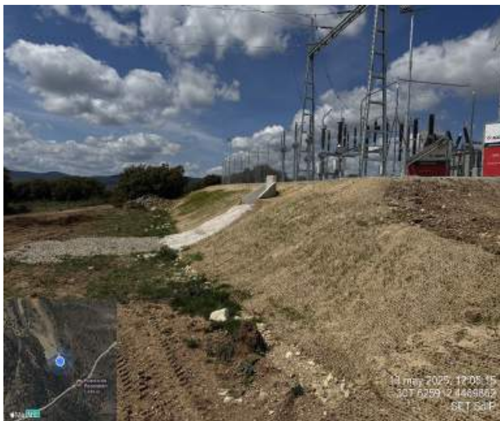
Fotografía 29. Estado de la revegetación natural en la zona de la SET
