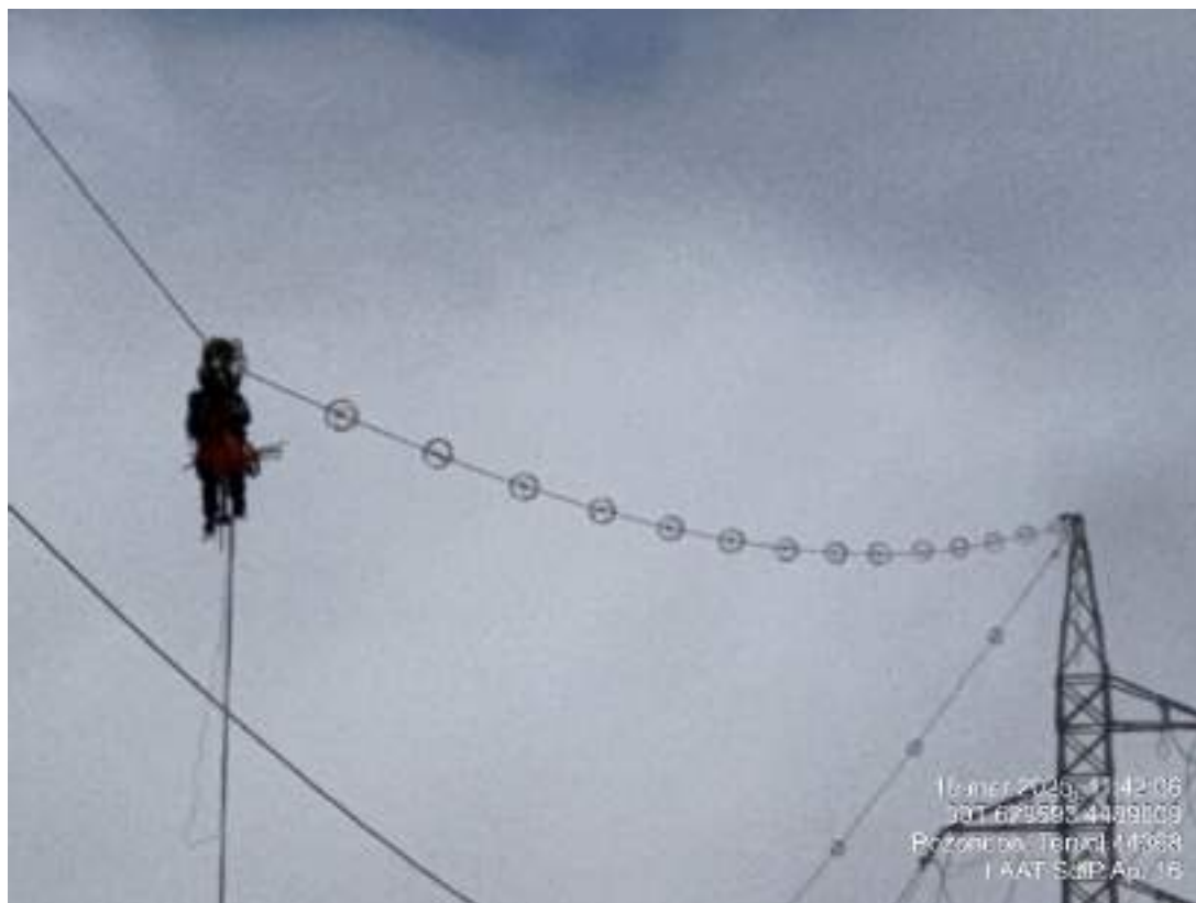
Fotografía 12. Colocación de los salvapájaros
