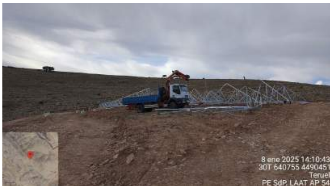
Fotografía 2. Montaje de la torre del Ap. 54
