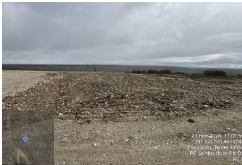
Fotografía 35. Restitución de la plataforma del AE6
