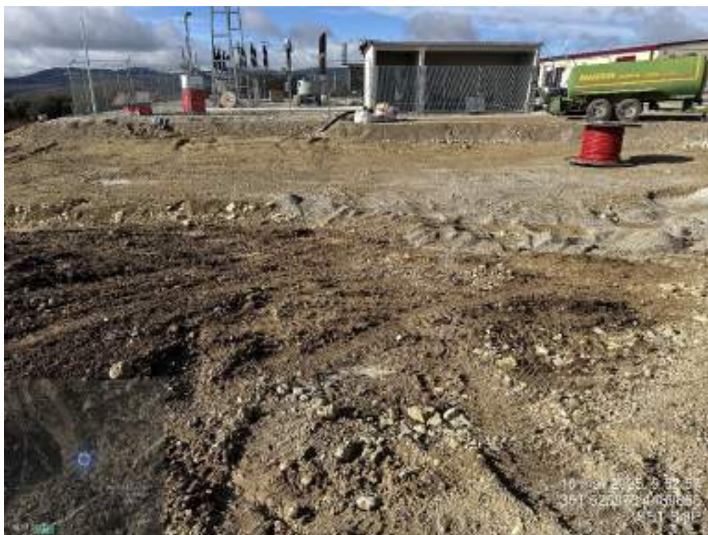
Fotografía 17. Restauración de la zona de limpieza de cubas
