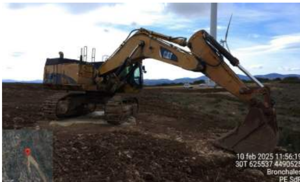
Fotografía 18. Maquinaria situada sobre material impermeable
