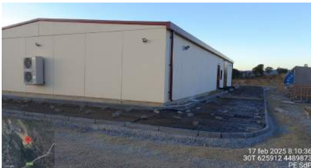
Fotografía 4. Preparado para la cimentación de la acera
