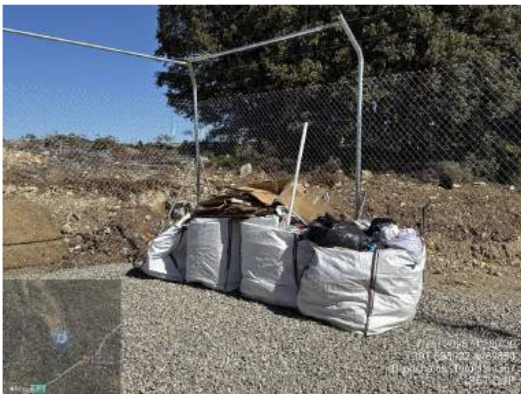
Fotografía 13. Sacas para el acopio de los RNP
