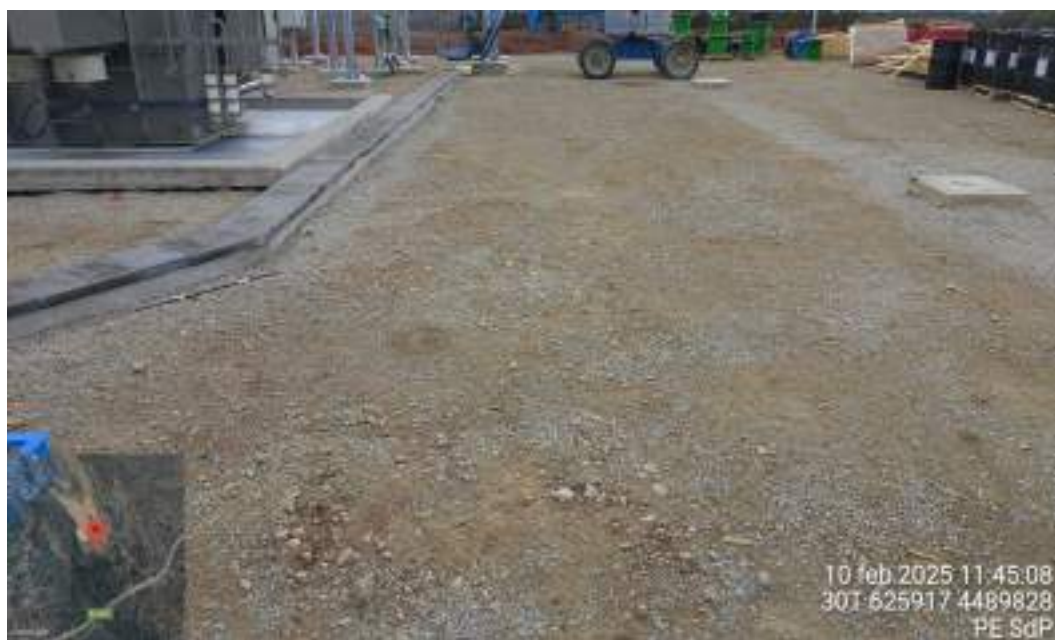
Fotografía 22. Vertido retirado y terreno limpio en la SET (2)
