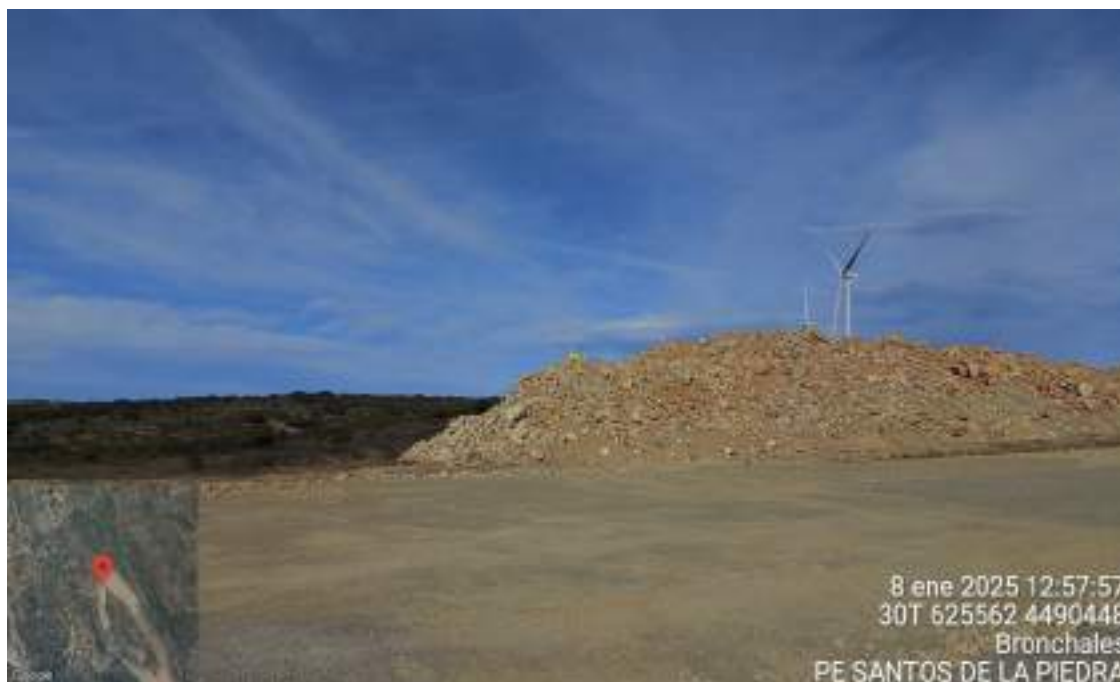
Fotografía 3. Material detrítico para rellenos
