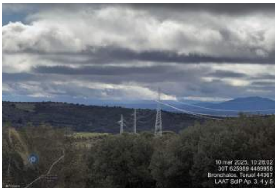
Fotografía 8. Tendido del cable de alta tensión
