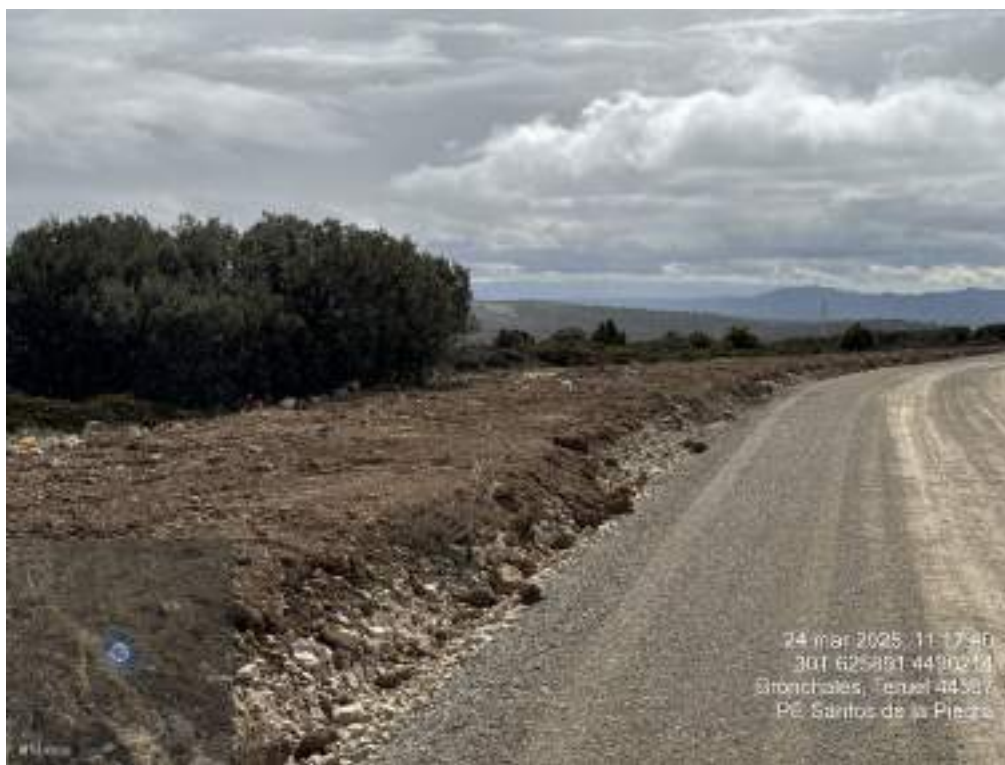
Fotografía 19. Tierra vegetal sobre la zona zanja de evacuación
