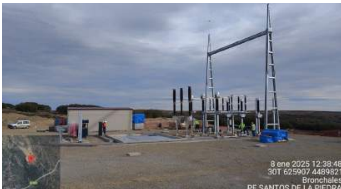
Fotografía 1. Montaje de la estructura de la SET
