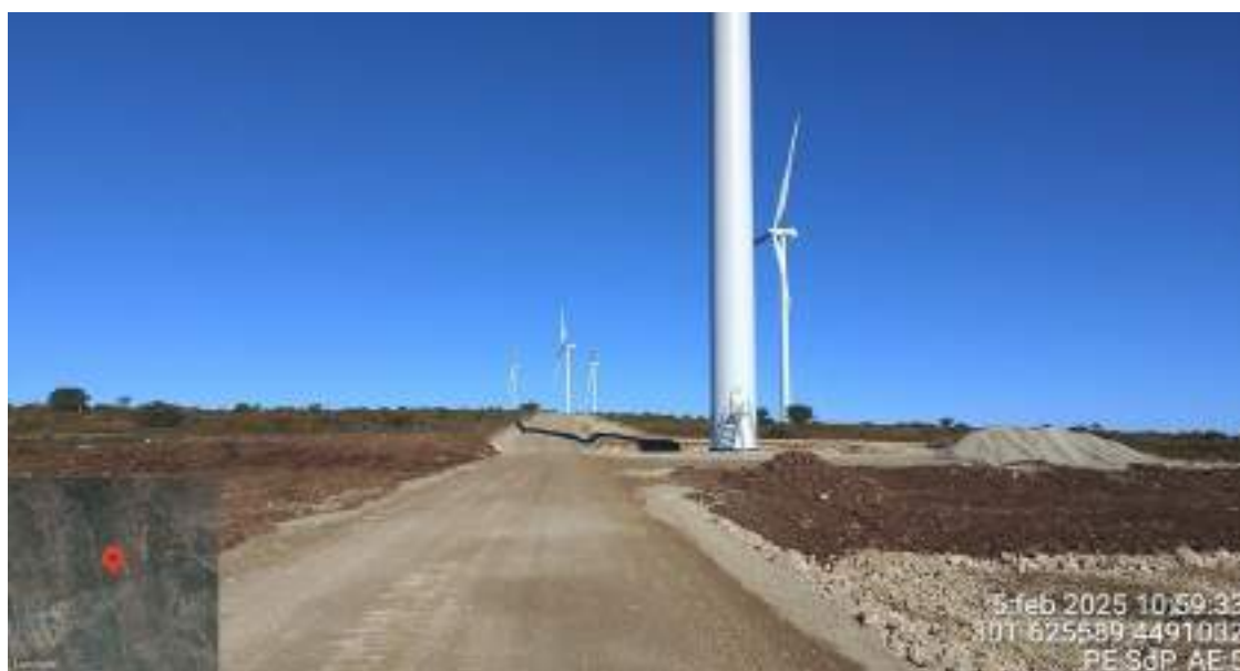
Fotografía 2. Extendido de la tierra vegetal tras la restitución del AE5
