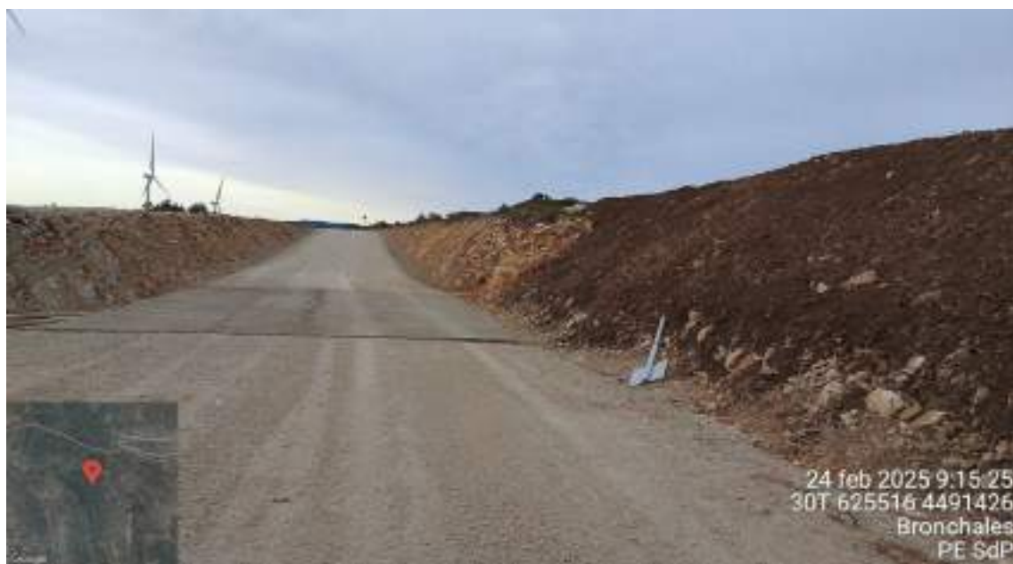
Fotografía 6. Extendido de la tierra vegetal AE 3
