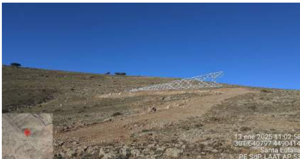
Fotografía 4. Torre del apoyo 53 listo para ser izado
