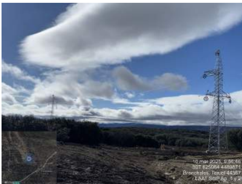
Fotografía 9. Vista del apoyo 42 desde el apoyo 41 con el cable tendido
