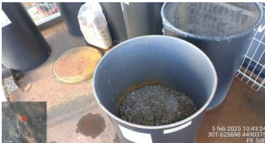
Fotografía 23. Segregación de la tierra contaminada
