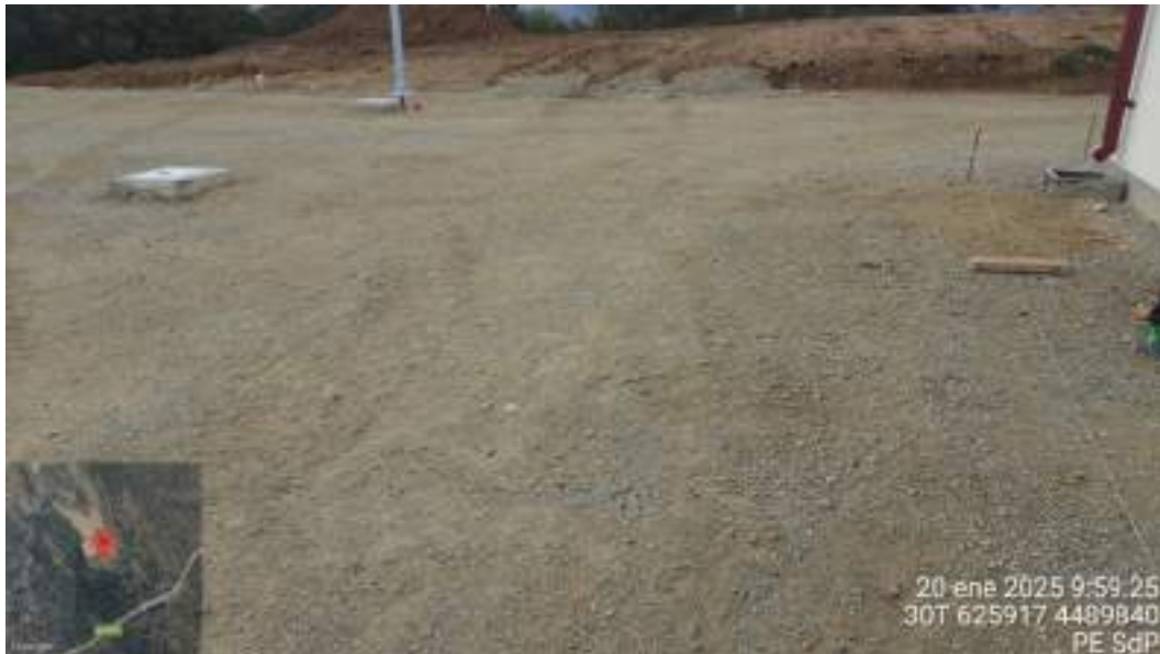
Fotografía 20. Vertido retirado y terreno limpio en la SET (1)
