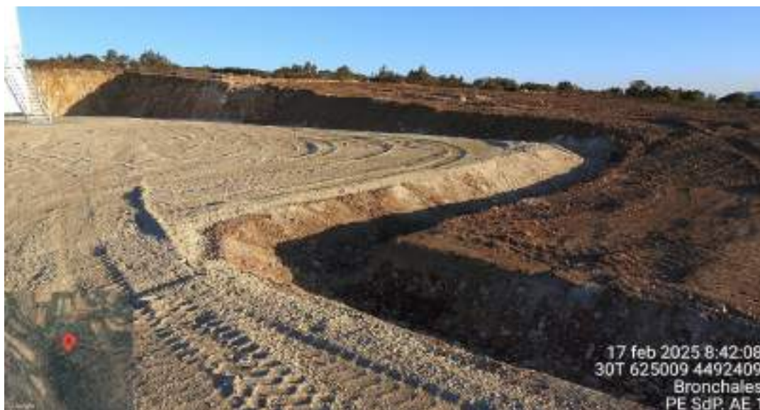
Fotografía 5. Apertura de la cuneta en el AE1
