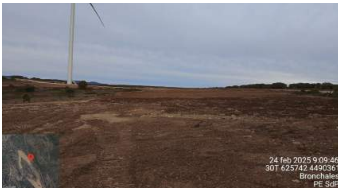
Fotografía 5. Restauración de la zona de casetas
