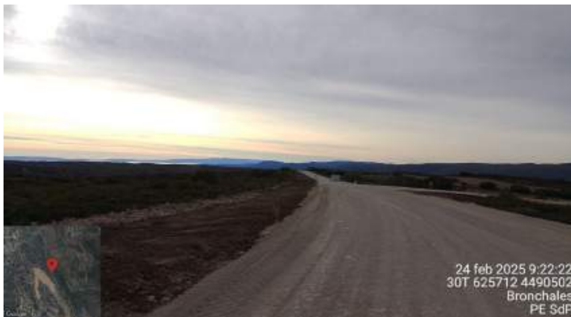
Fotografía 7. Zahorra extendida sobre los viales y tierra vegetal sobre la evacuación
