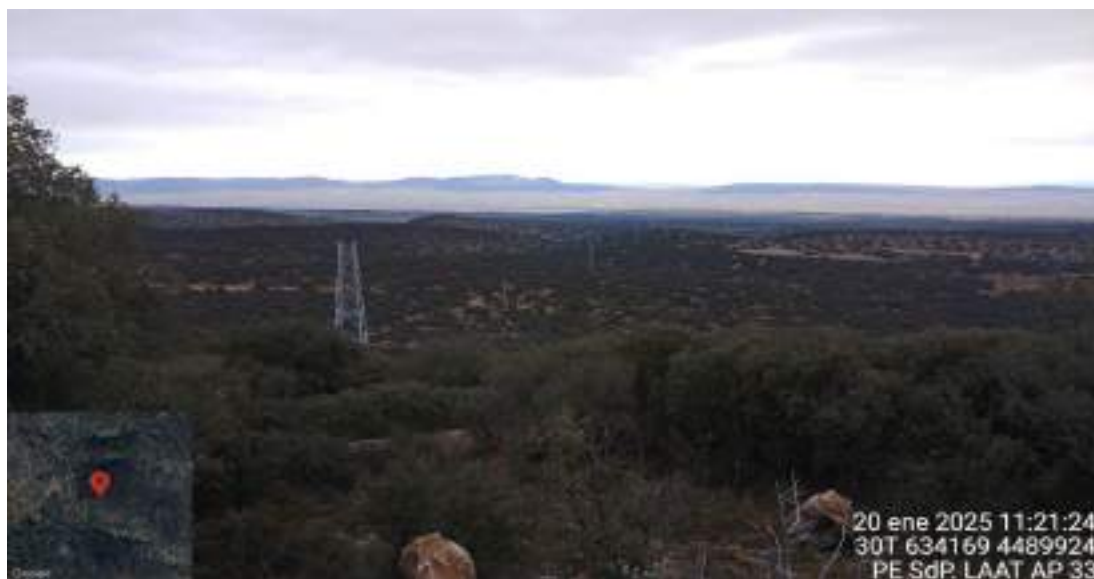
Fotografía 11. Torres de la LAAT izadas
