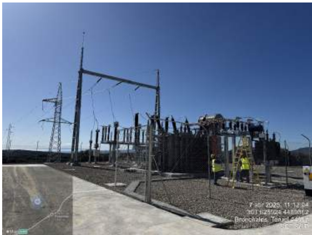
Fotografía 7. Instalación del cableado en la SET
