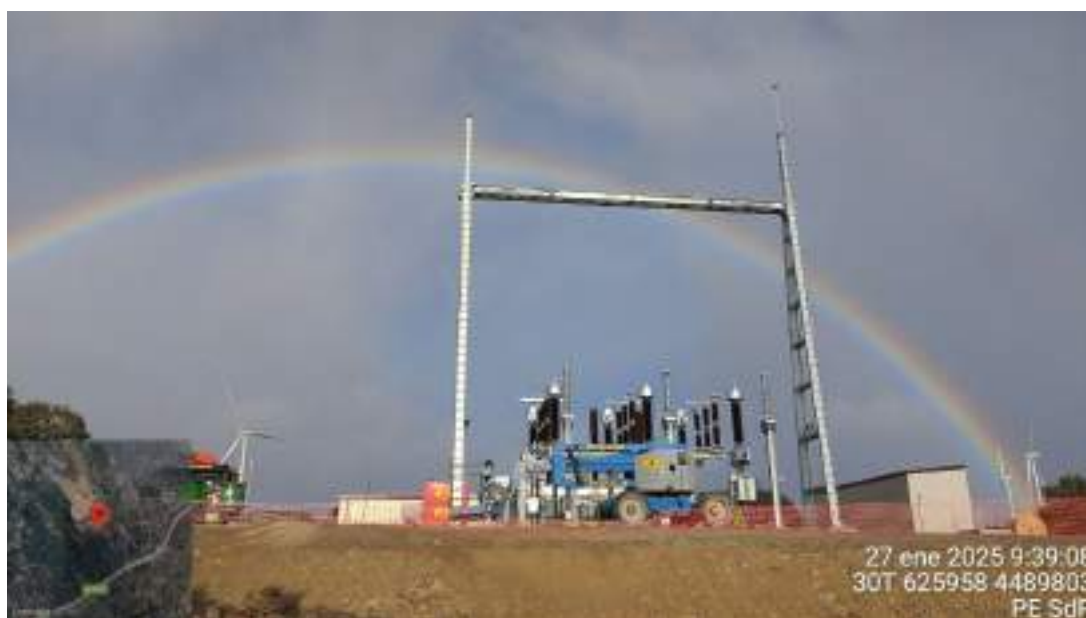
Fotografía 10. Montaje de los elementos de la SET
