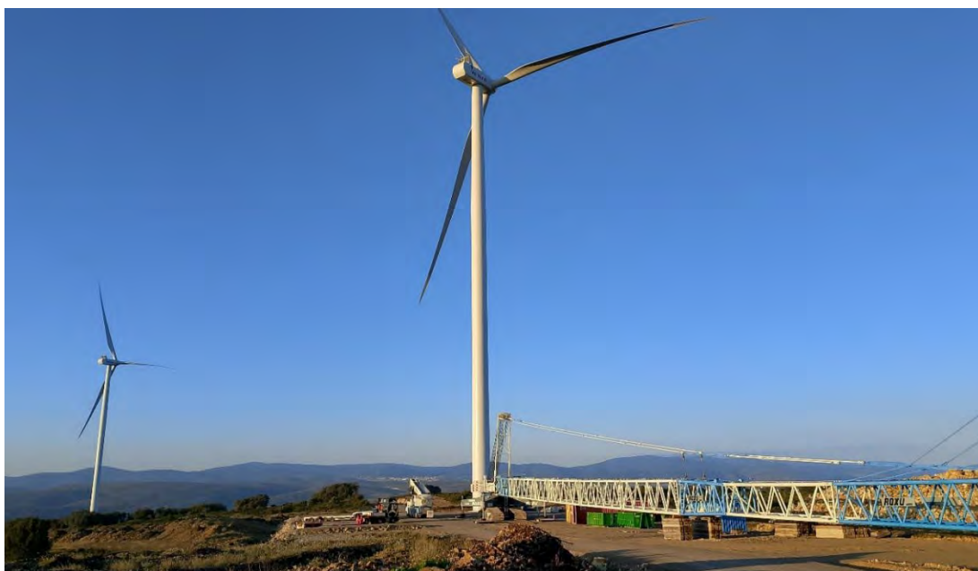
Fotografía 12. Aerogeneradores 7 y 8 izados con la grúa todavía in situ (06/11/2024)
