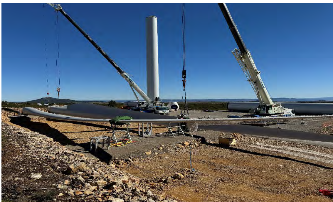
Fotografía 9. Acopio de las aspas de los aerogeneradores (04/10/2024)
