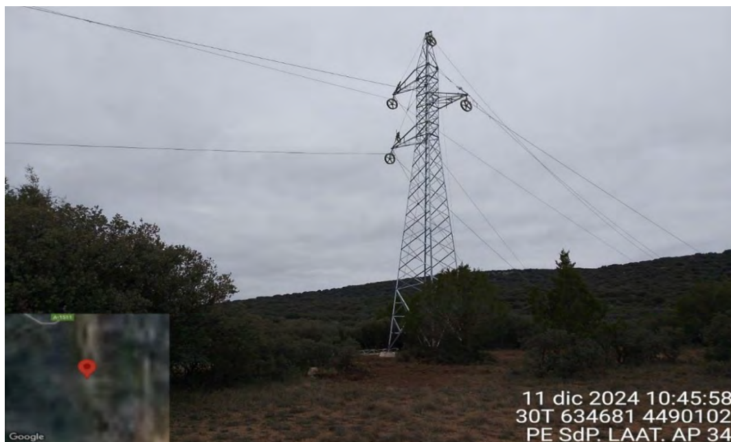
Fotografía 9. Vista del apoyo 34 mientras se tendía el cableado
