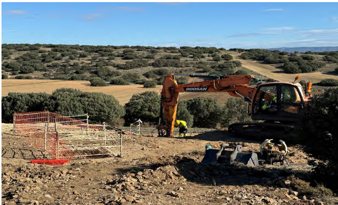
Fotografía 5. Excavación del apoyo 46 de la LAAT (09/10/2024)
