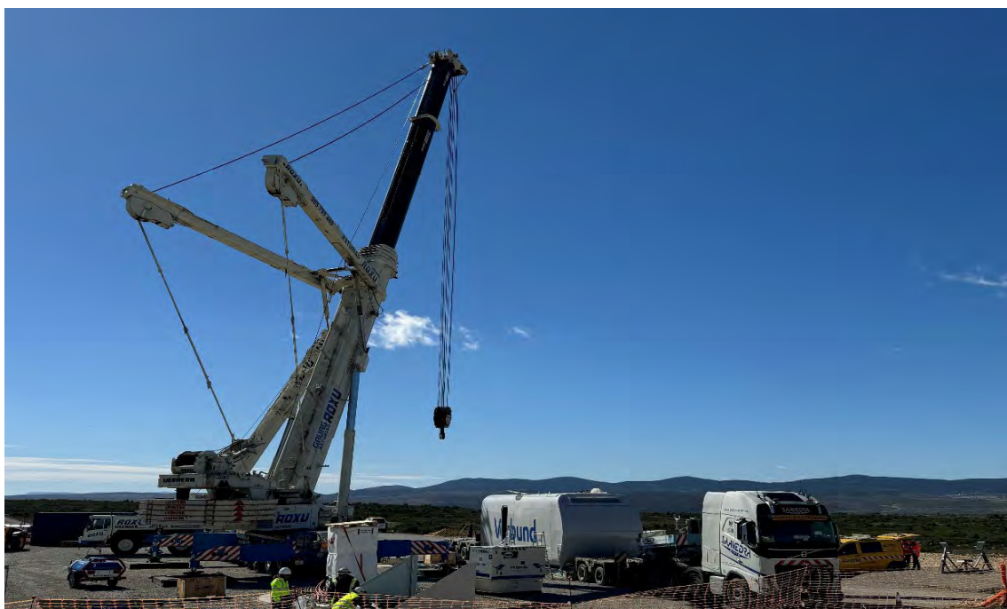
Fotografía 10. Acopio de la turbina de uno de los aerogeneradores (27/09/2024)
