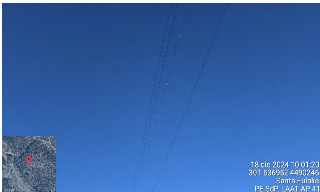
Fotografía 31. Salvapájaros colocados en el cableado entre el apoyo 40 y el 41 de la LAAT
