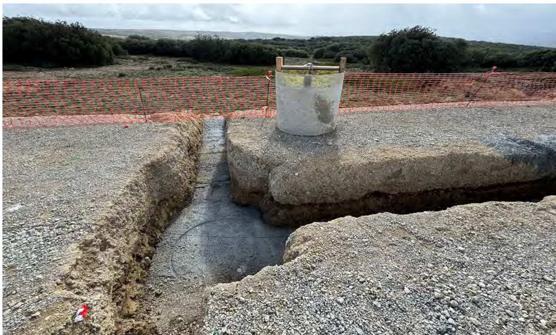
Fotografía 3. Cimentación de la zona de desagüe de la SET (23/10/2024)
