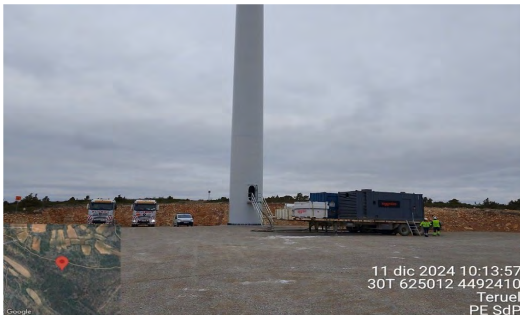
Fotografía 8. Personal realizando comprobaciones en el aerogenerador 1
