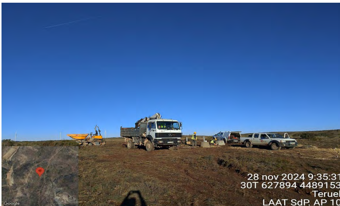
Fotografía 6. Personal trabajando en el encofrado del apoyo 10 de la LAAT
