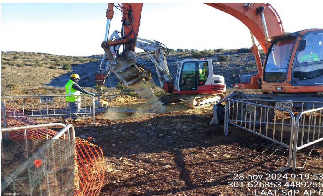
Fotografía 5. Excavación del apoyo 6 de la LAAT
