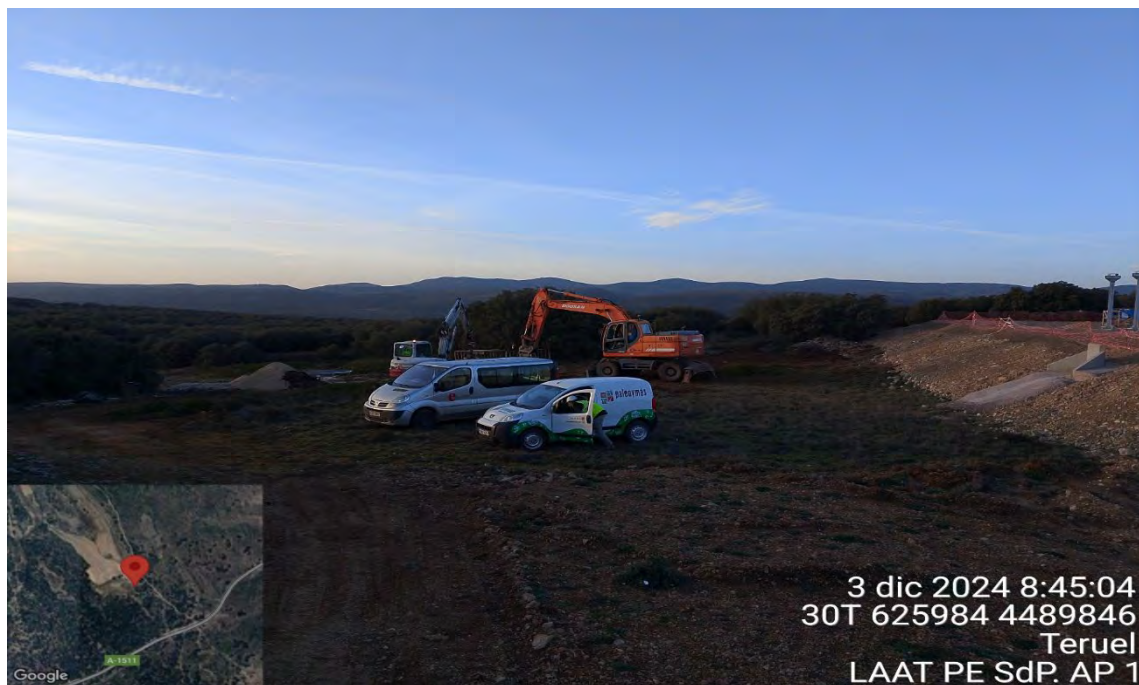
Fotografía 20. Encargados de la supervisión paleontológica previo al comienzo de los trabajos de excavación en el apoyo 1 de la LAAT
