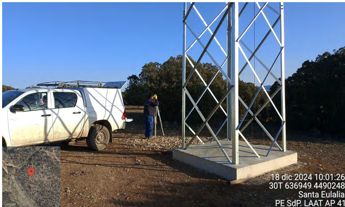
Fotografía 19. Topógrafo en el apoyo 41 de la LAAT
