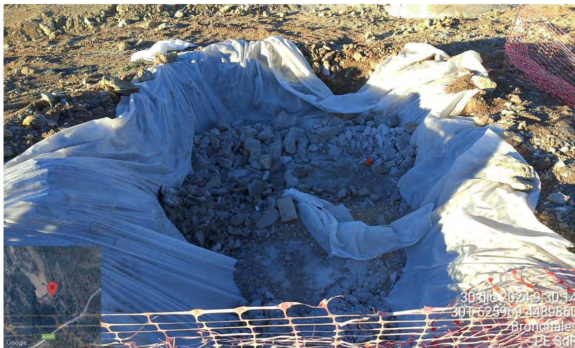
Fotografía 18. Lavadero de cubas de hormigón junto a la SET
