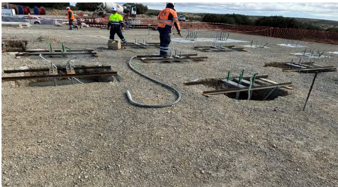
Fotografía 1. Cimentación de diferentes elementos de la SET (09/10/2024)
