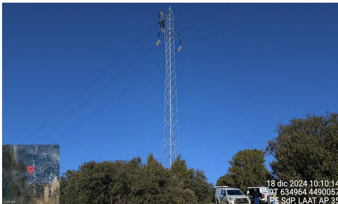
Fotografía 18. Empleados trabajando en el apoyo 35 de la LAAT
