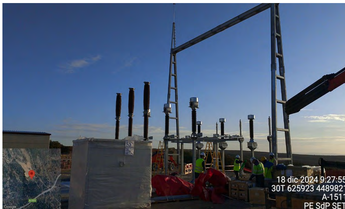
Fotografía 8. Empleados trabajando en la SET
