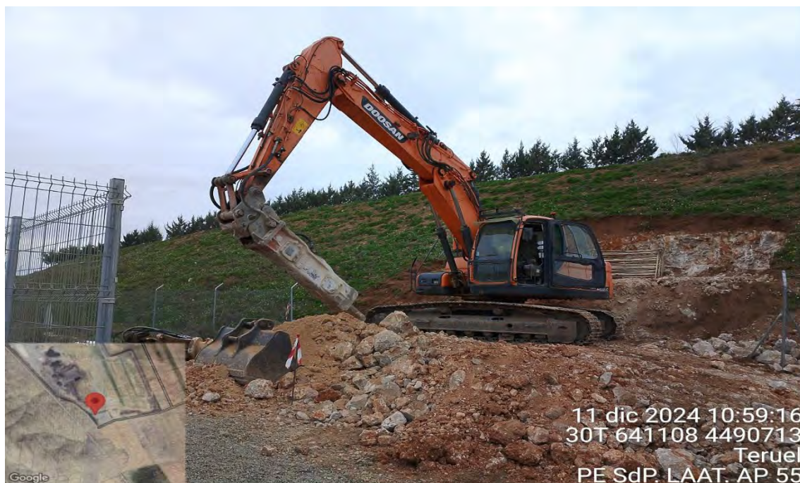
Fotografía 2. Acondicionamiento del apoyo 55 de la LAAT
