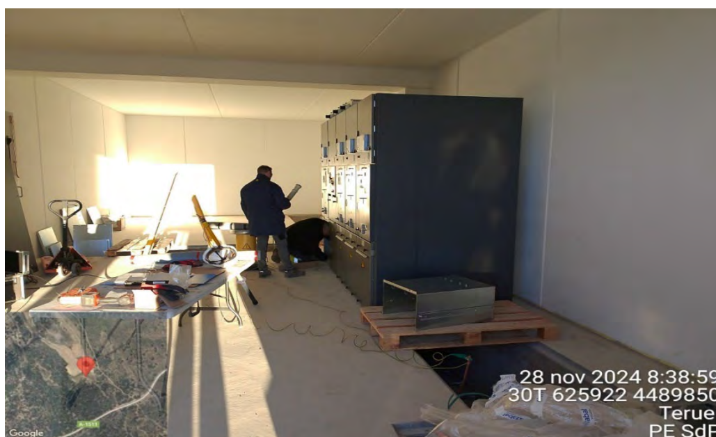
Fotografía 7. Comprobación de las celdas de la SET
