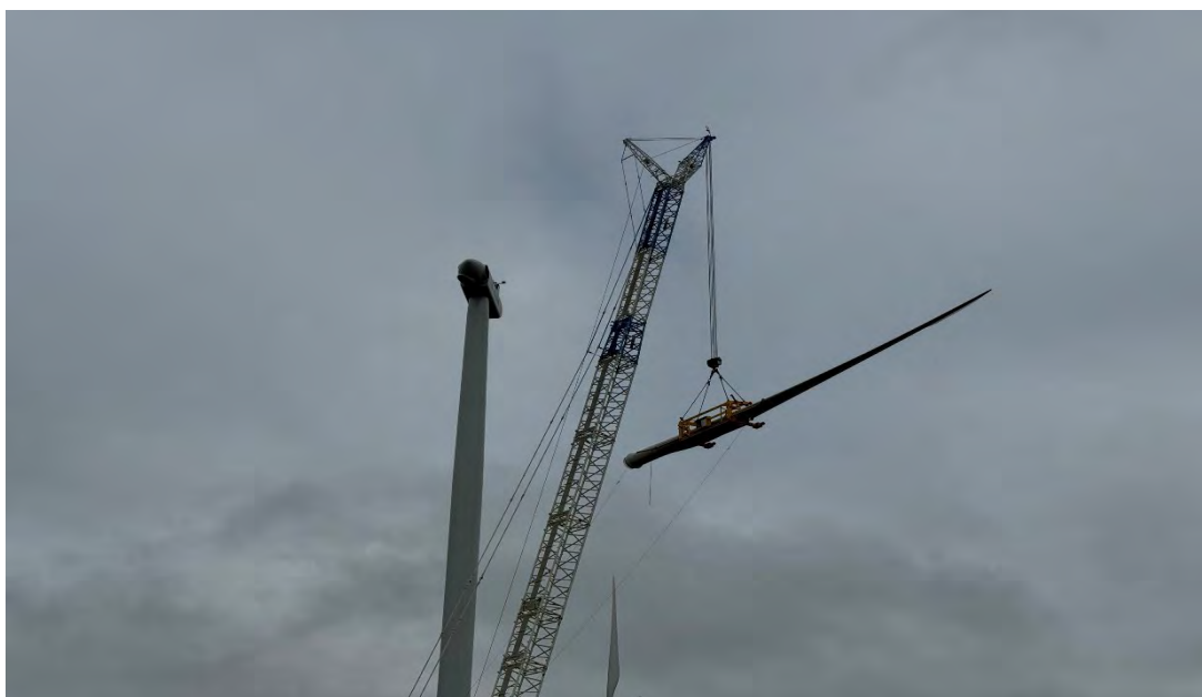
Fotografía 11. Izado de las aspas del aerogenerador 5 (23/10/2024)
