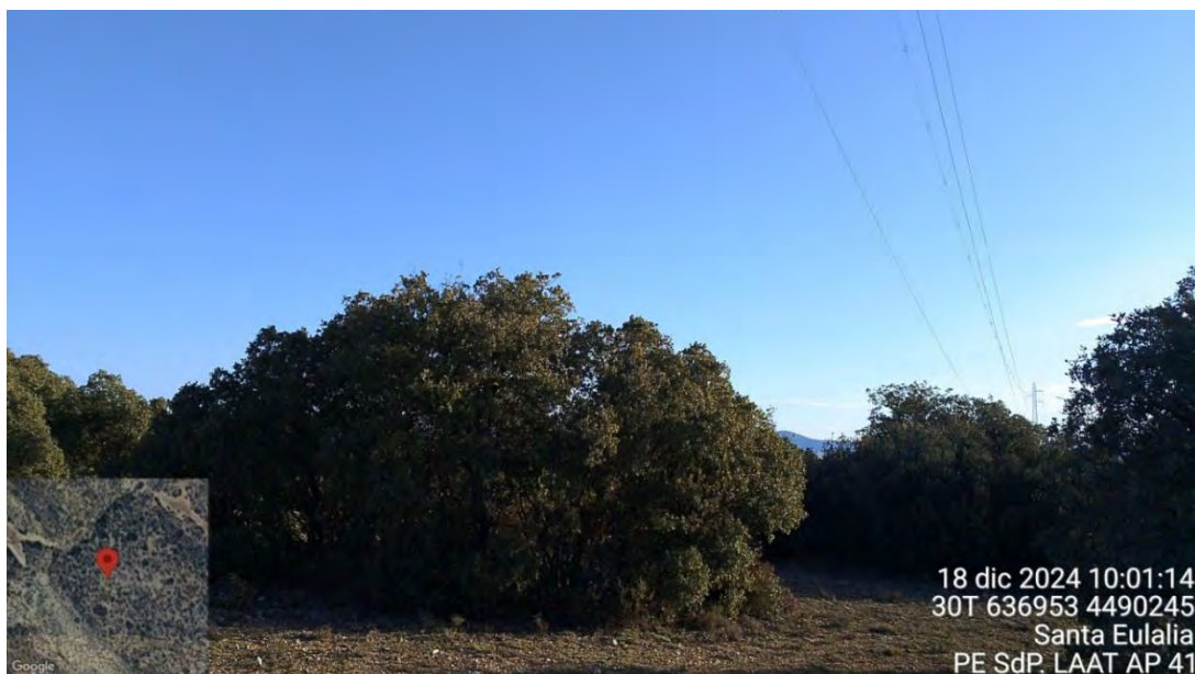
Fotografía 10. Vista del apoyo 42 desde el 41 con el cableado tendido
