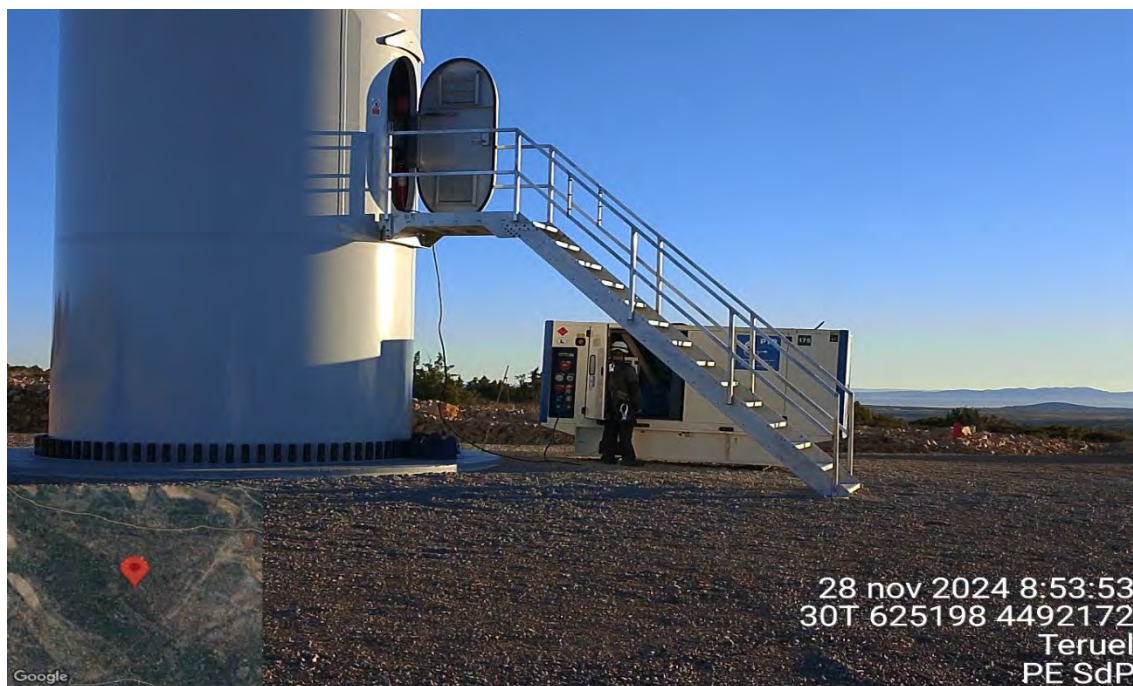
Fotografía 7. Empleado trabajando en el interior de los aerogeneradores
