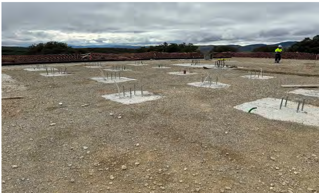
Fotografía 4. Cimentación de los elementos que componen la SET (23/10/2024)
