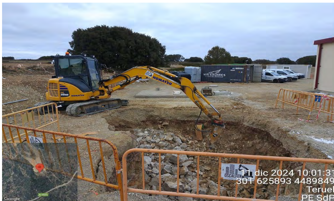
Fotografía 3. Excavación de la cavidad donde se sitúa la fosa séptica vinculada a la SET
