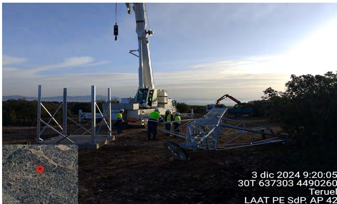
Fotografía 17. Personal justo antes de izar la torre 42 de la LAAT
