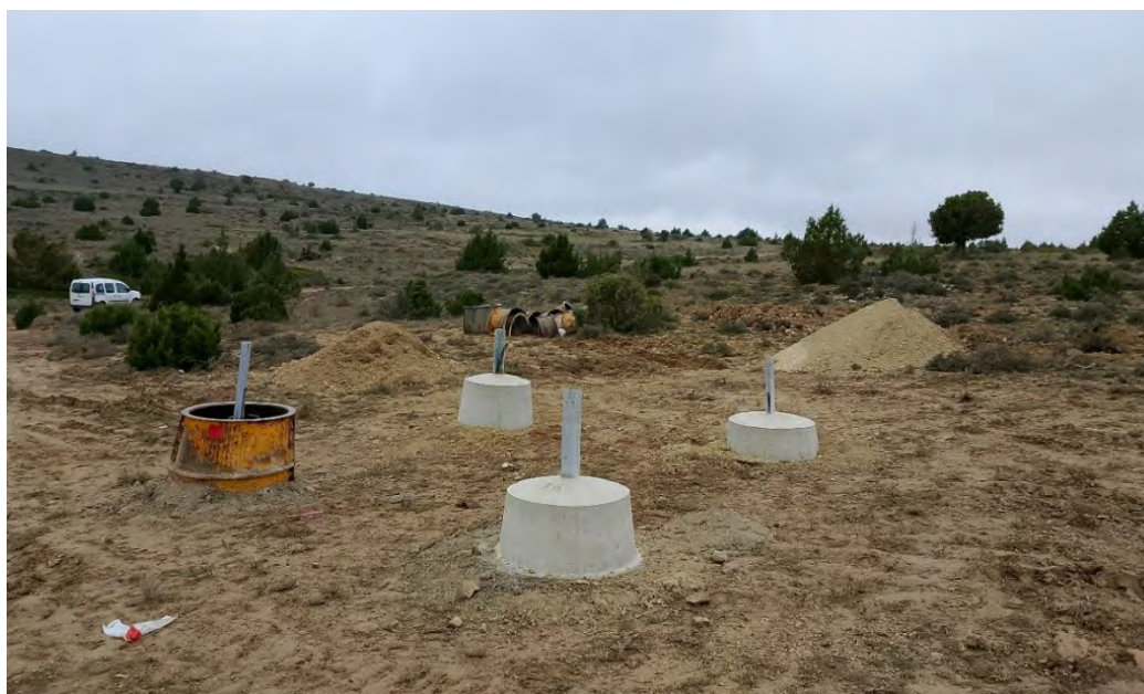
Fotografía 6. Apoyo 16 de la LAAT hormigonado (15/11/2024)
