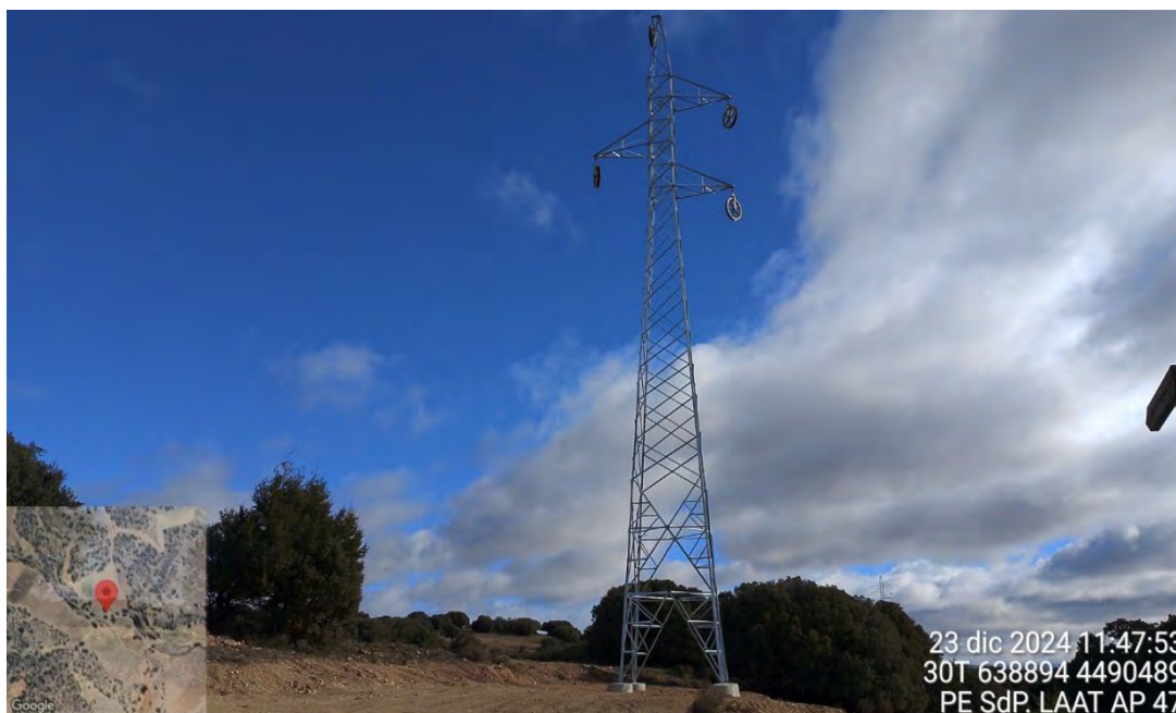
Fotografía 14. Torre izada del apoyo 47 de la LAAT
