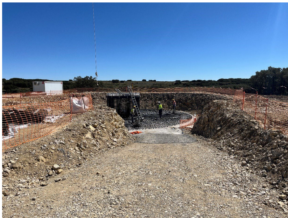
Fotografía 6. Figura 5 Montaje de la estructura de la base del aerogenerador (AE 8)
