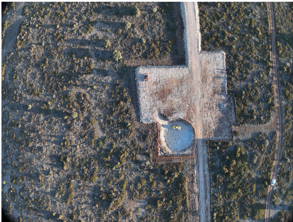
Fotografía 20. Vista aérea del PE Santos de la Piedra (extendido de zahorra)
