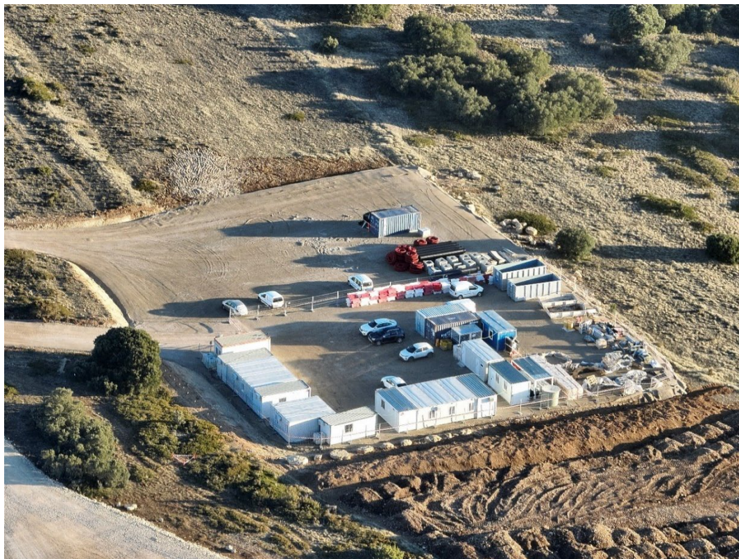
Fotografía 14. Vista aérea de la zona de casetas y acopios
