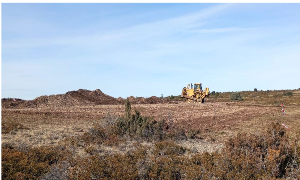
Fotografía 1. Movimientos de tierra
