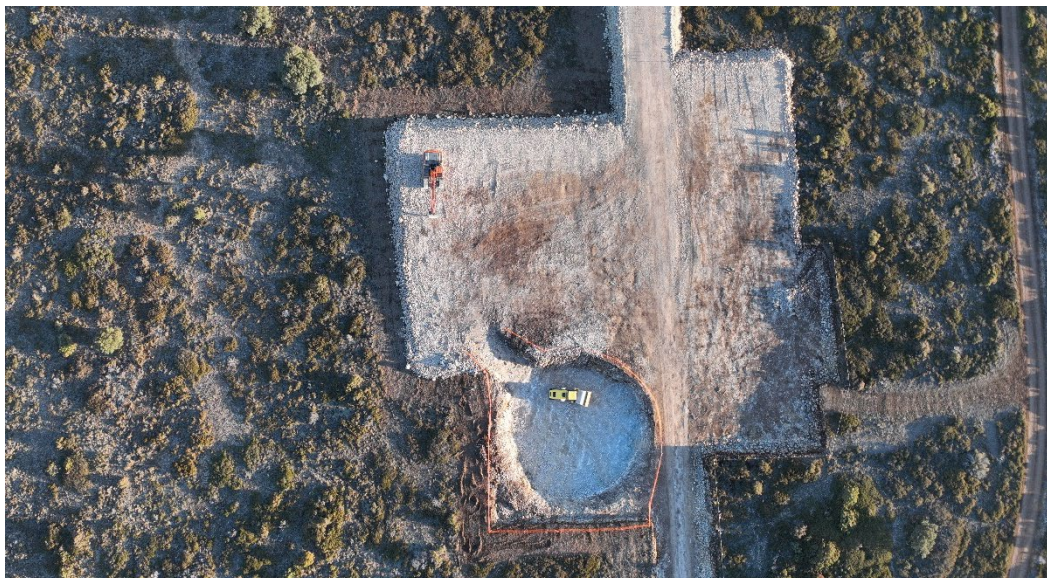
Fotografía 3. Extendido de zahorra
