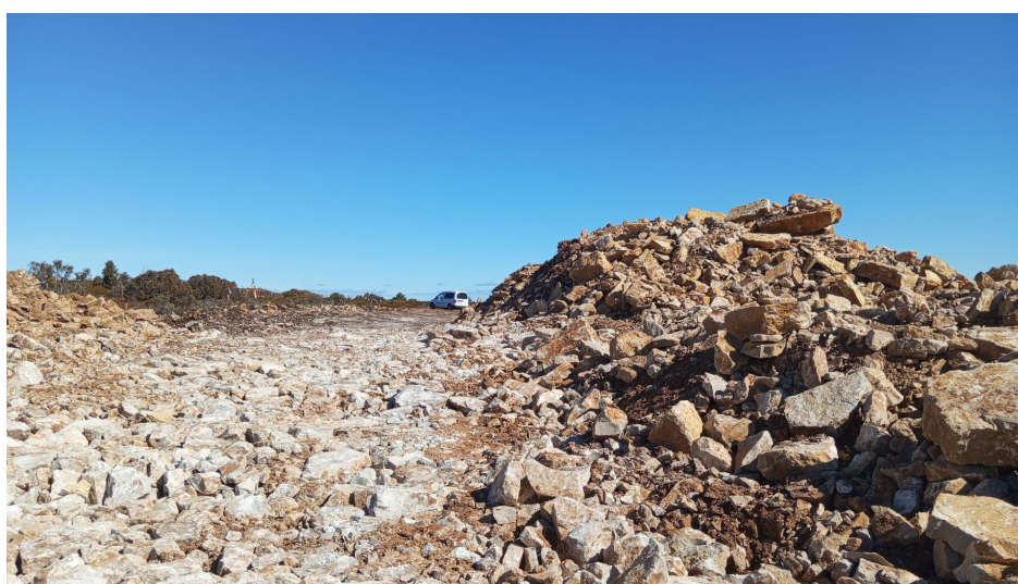
Fotografía 12. Acopio de material rocoso procedente de la excavación
