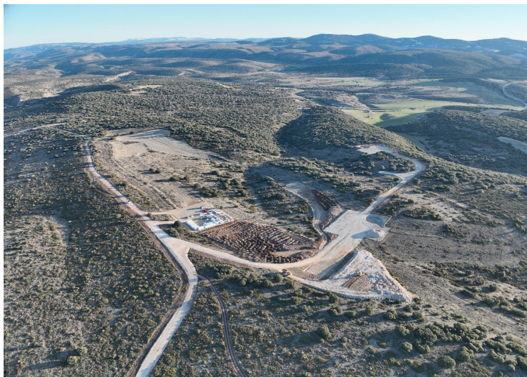
Fotografía 19. Vista aérea del PE "Santos de la Piedra" (plataforma y zona de casetas)
