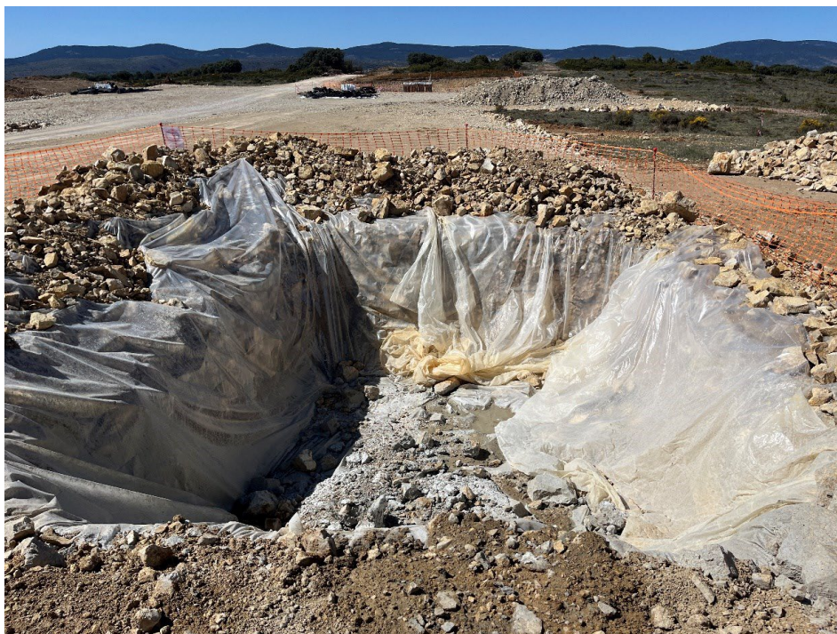
Fotografía 9. Balsa para el lavado de cubas de hormigón
