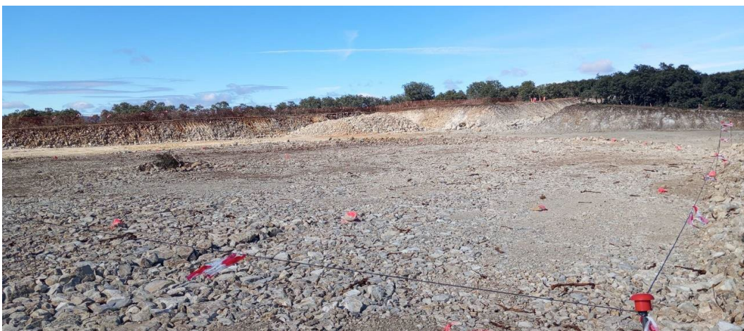
Fotografía 9. Extensión de zahorra excavación aerogenerador
