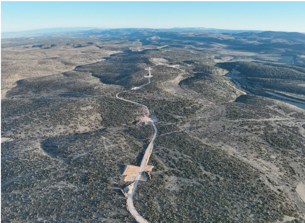
Fotografía 18. Vista general del proyecto
