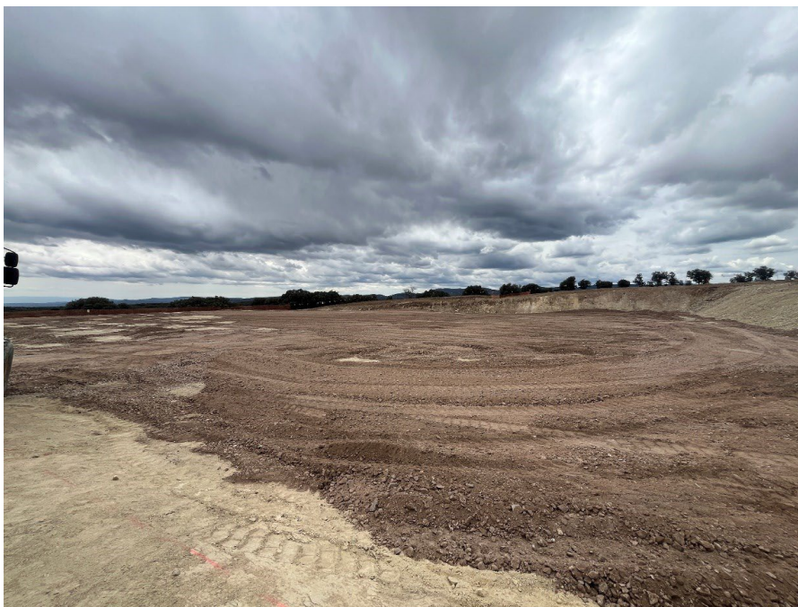
Fotografía 4. Extendido de zahorra
