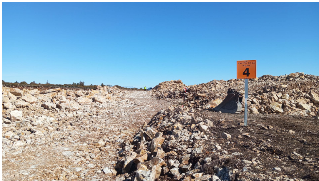
Fotografía 5. Acopio de material rocoso
