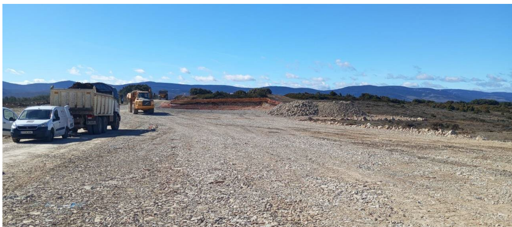
Fotografía 9. Extensión de zahorra excavación aerogenerador
