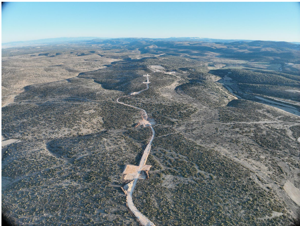
Fotografía 18. Vista general del PE "Santos de la Piedra"
