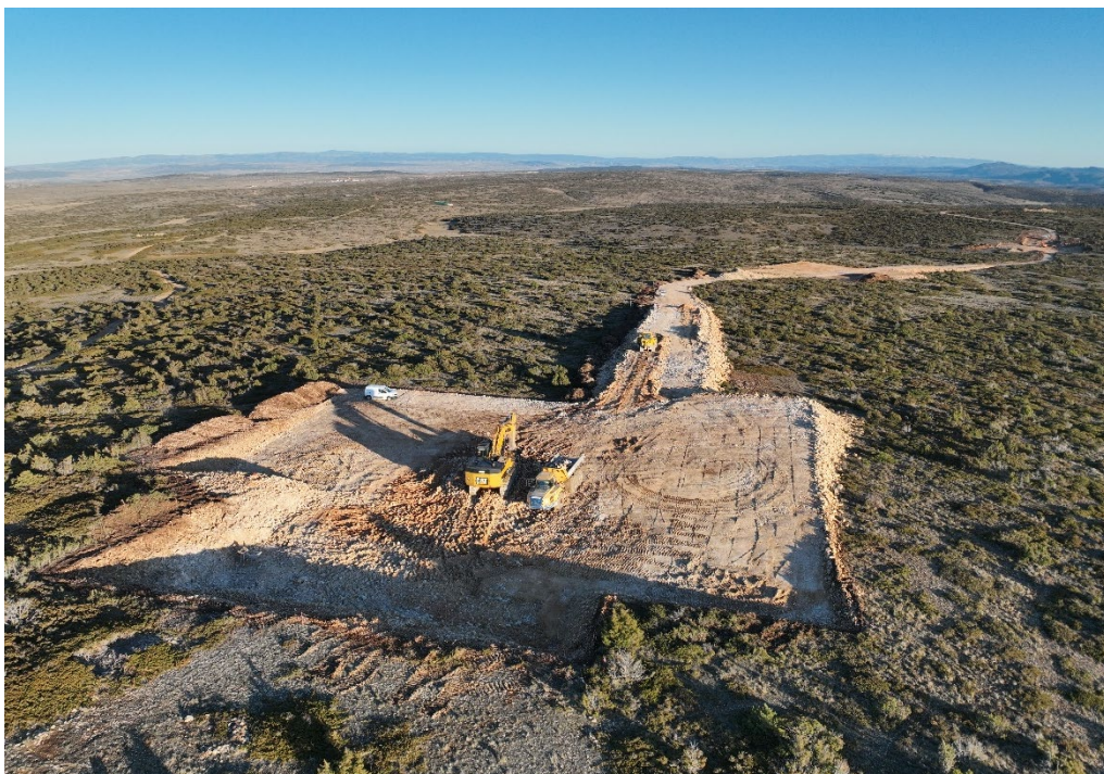
Fotografía 21. Vista aérea del PE Santos de la Piedra (plataforma aerogenerador)
