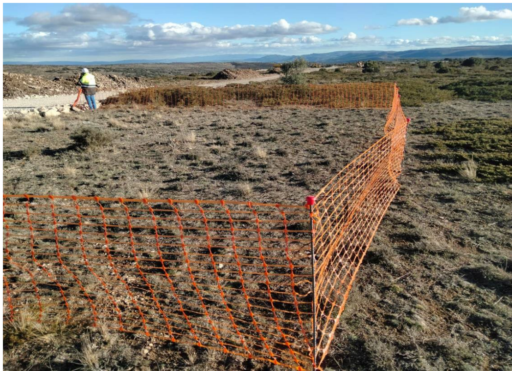
Fotografía 10. Balizado de las zonas destinadas al acopio de material
