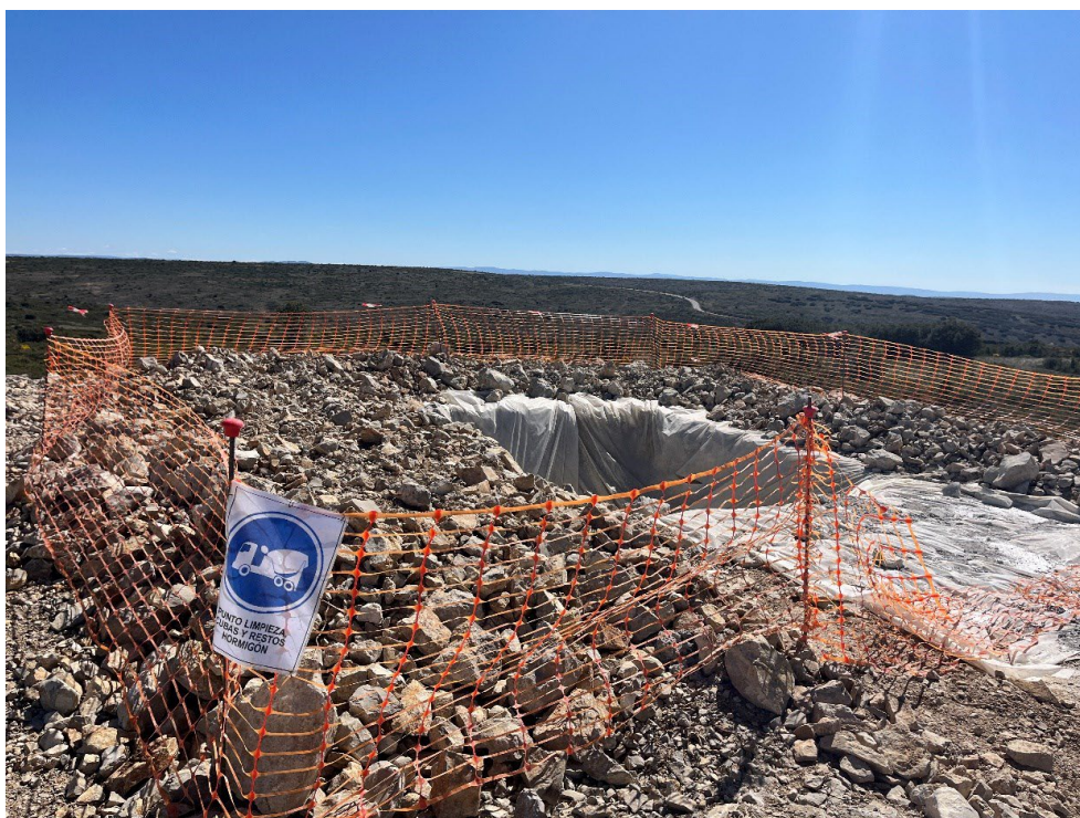
Fotografía 13. Balsas para el lavado de cubas de hormigón
