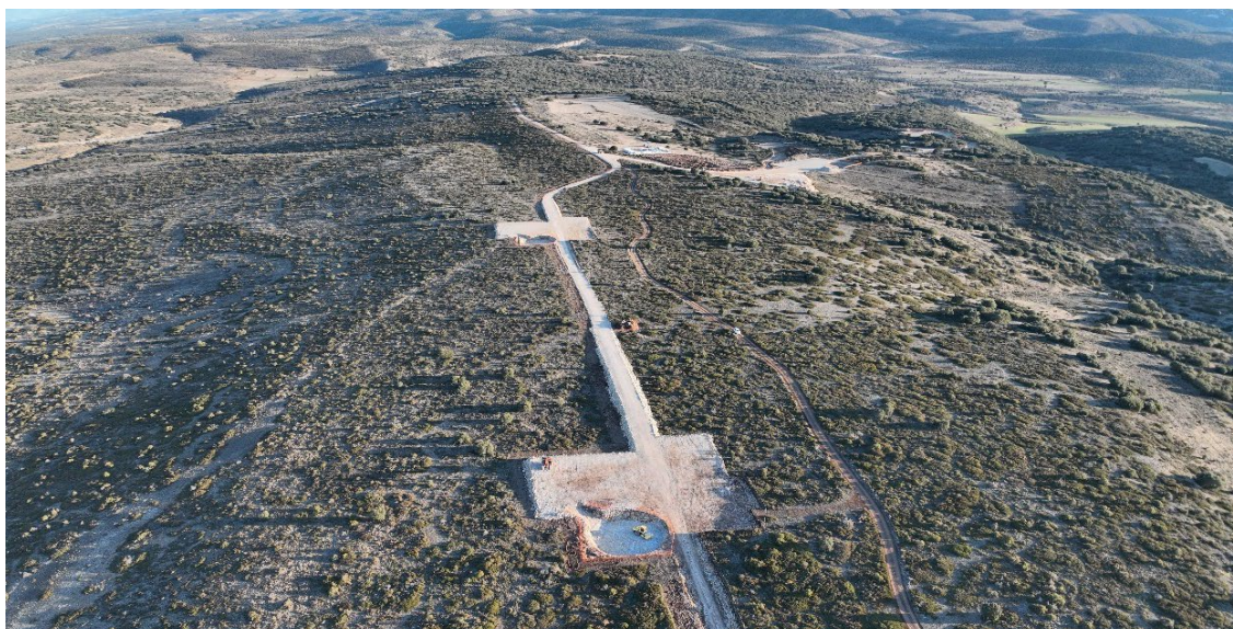
Fotografía 13. Vista aérea de la obra
