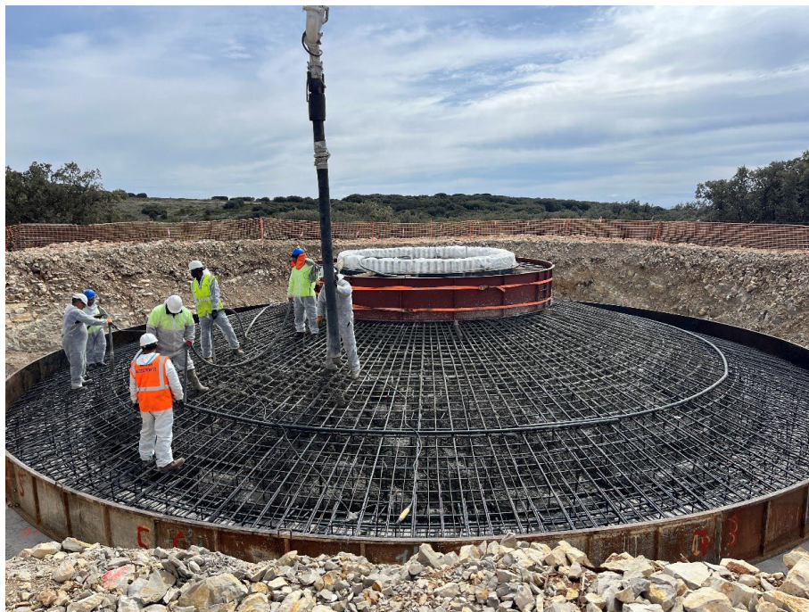
Fotografía 6. Figura 5 Montaje de la estructura de la base del aerogenerador (AE 8)
