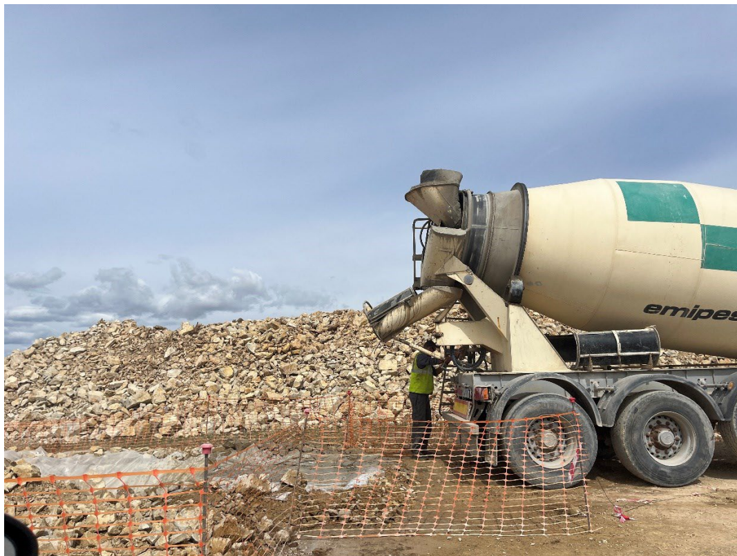
Fotografía 14. Limpieza de cuba de hormigón
