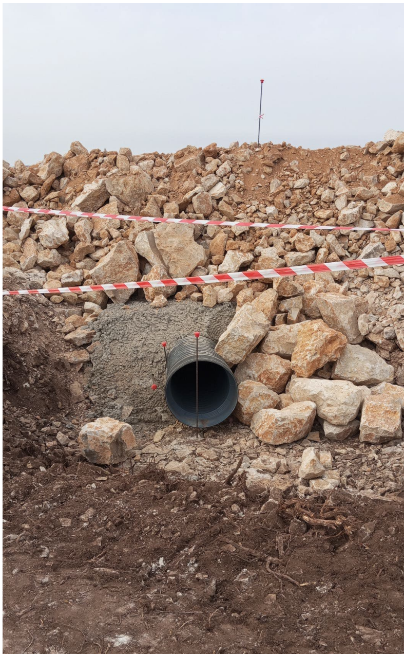
Fotografía 11. Instalación de tubería de drenaje (camino del AE1 al AE2)
