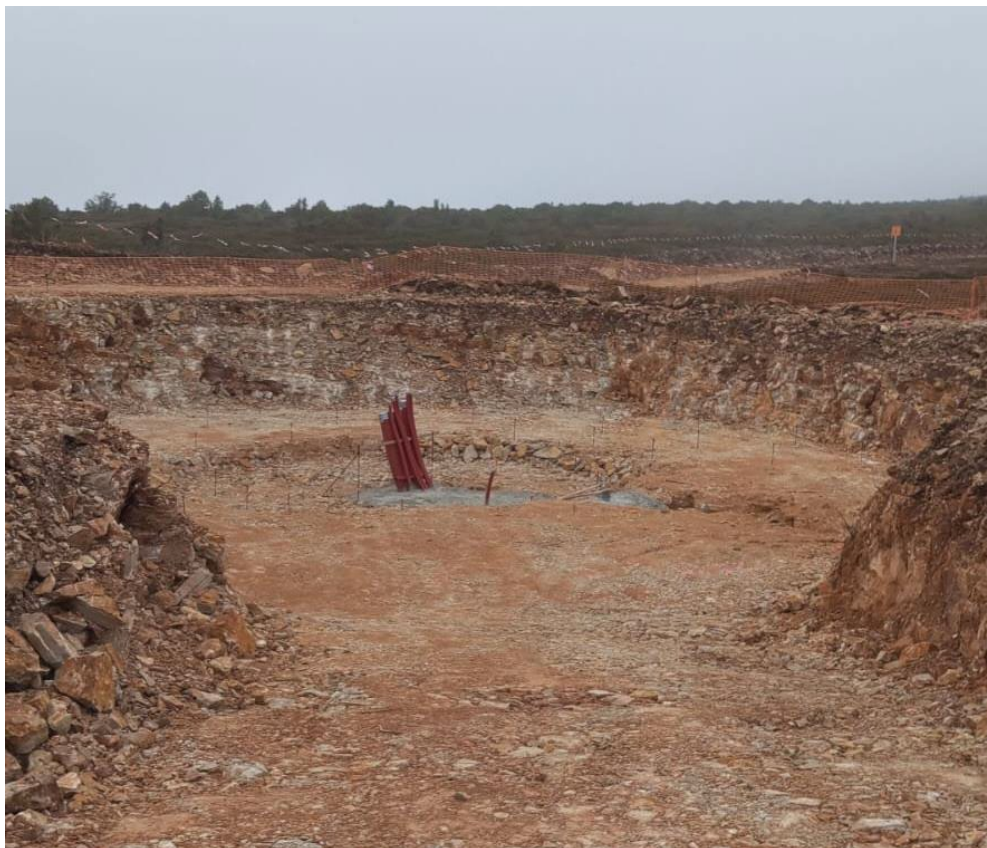
Fotografía 12. Instalación de tubería para el cableado
