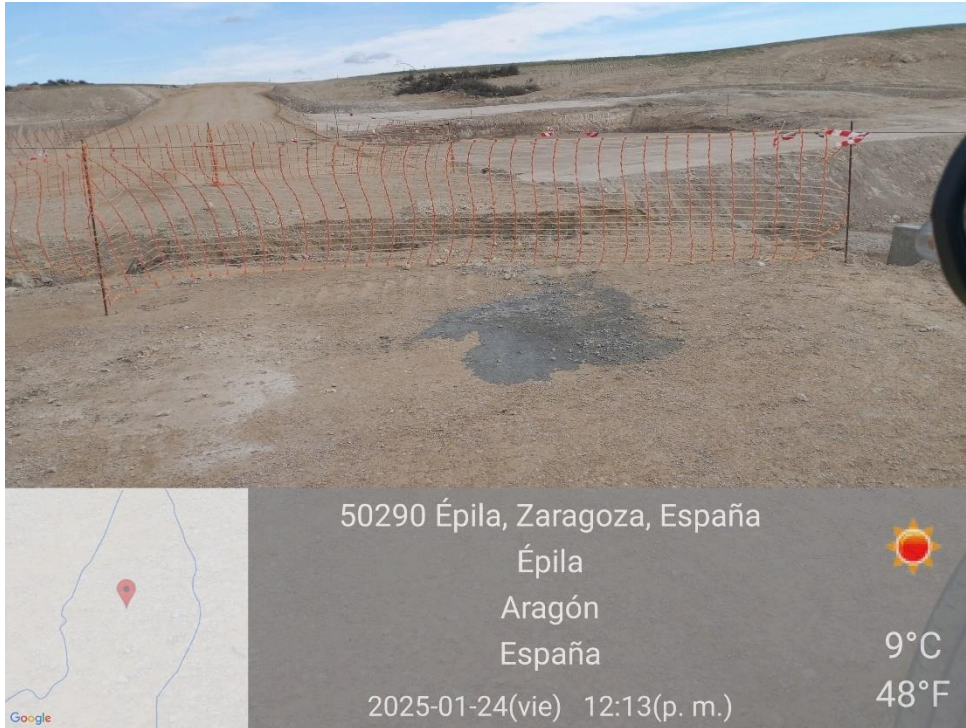
Ilustración 17. Vertido de hormigón en la plataforma 07.
