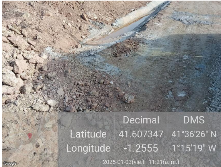
Ilustración 5. Vertido de hormigón en la pista.
