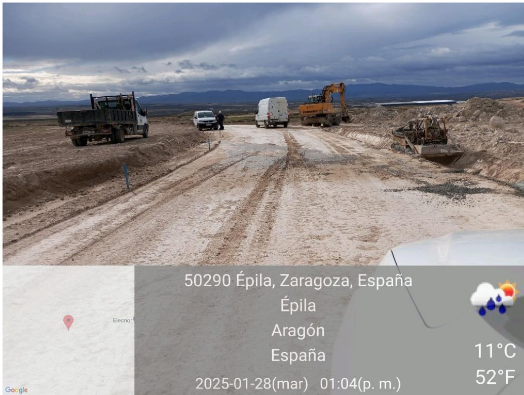
Ilustración 18. Limpieza de hormigón en el medio de la pista.
