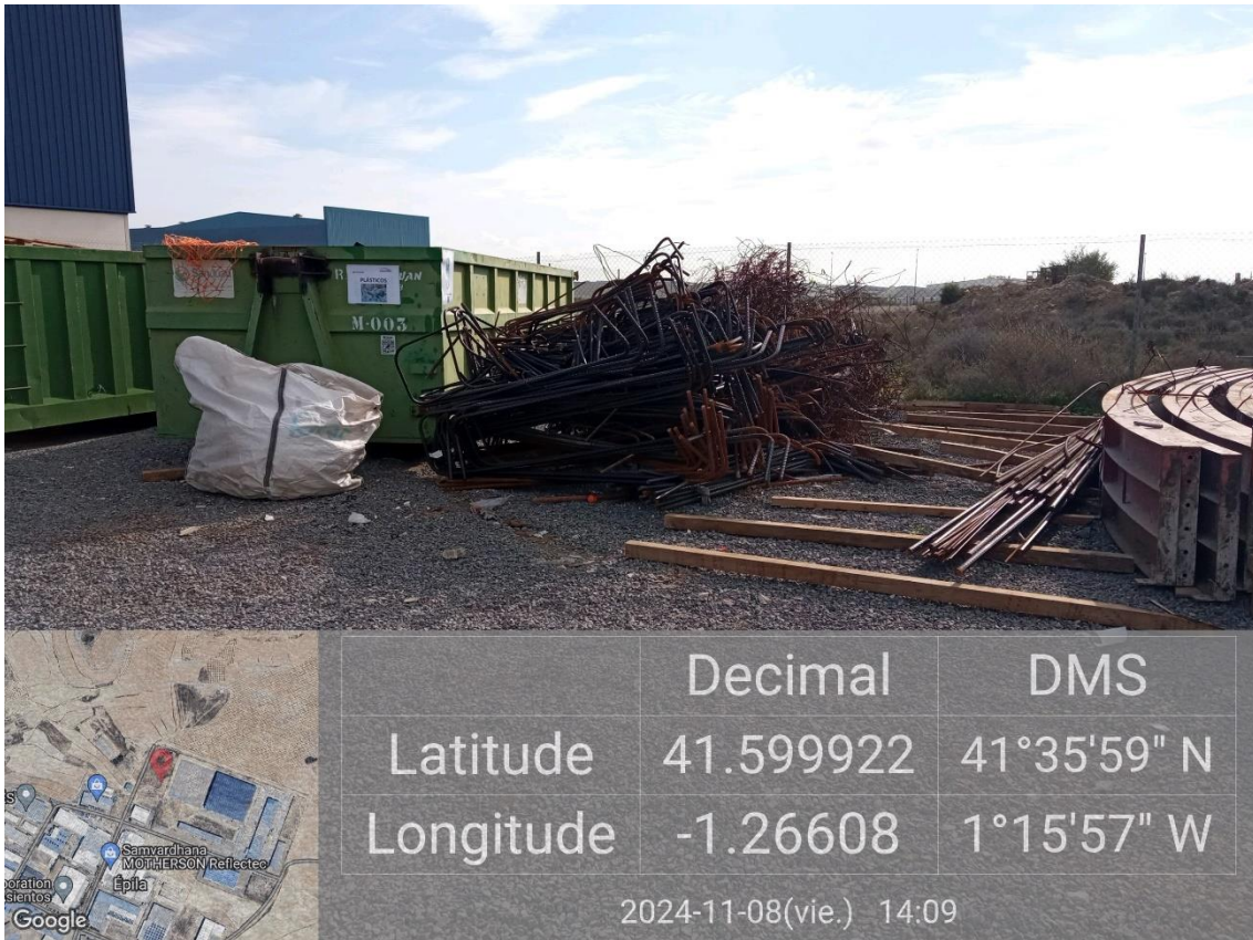
Ilustración 3. Acopio de ferralla en el punto limpio con necesidad de delimitación y señalización.
