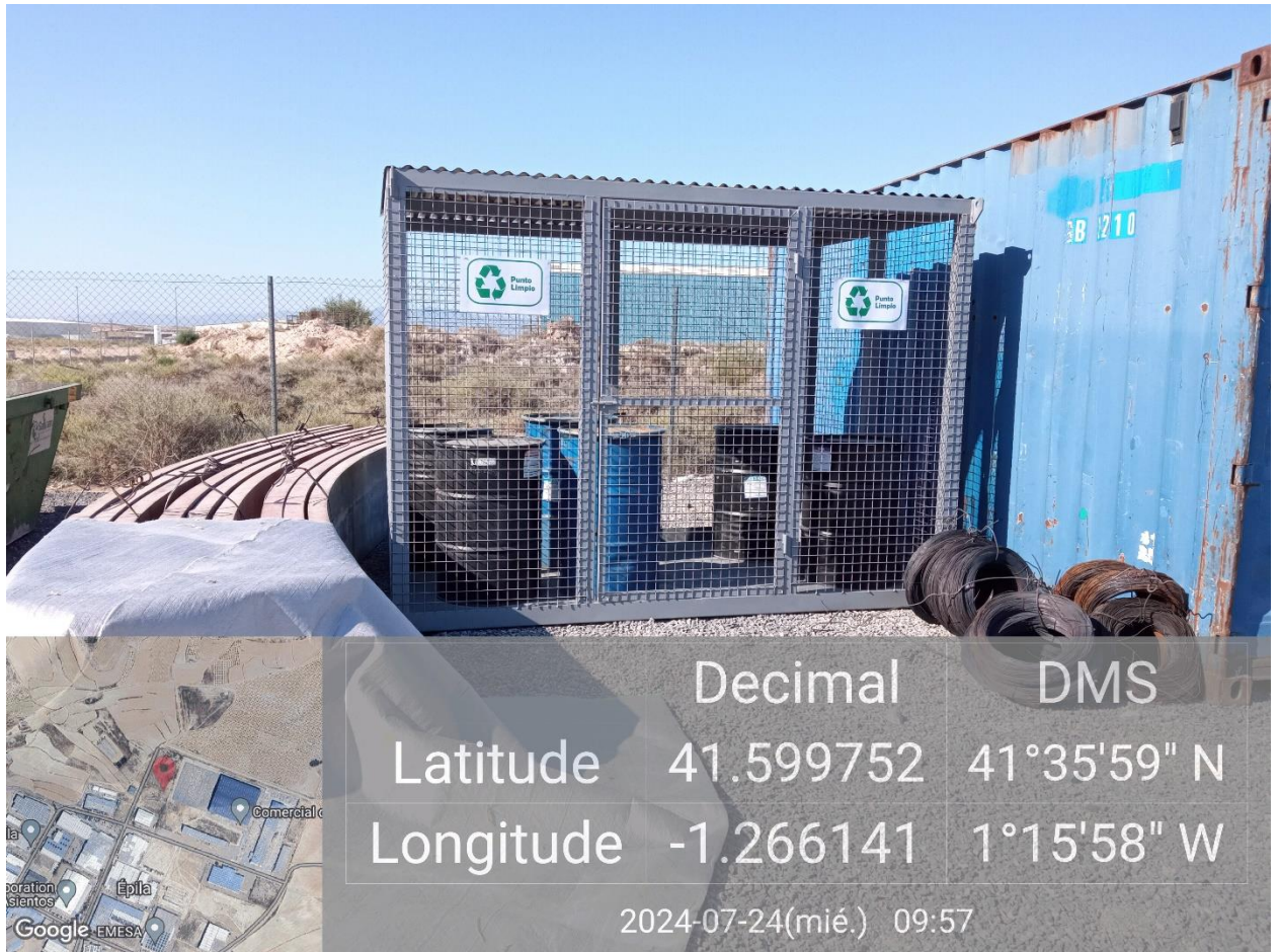
Ilustración 8. Punto limpio de residuos peligrosos correctamente acondicionado y señalado en la visita 11.
