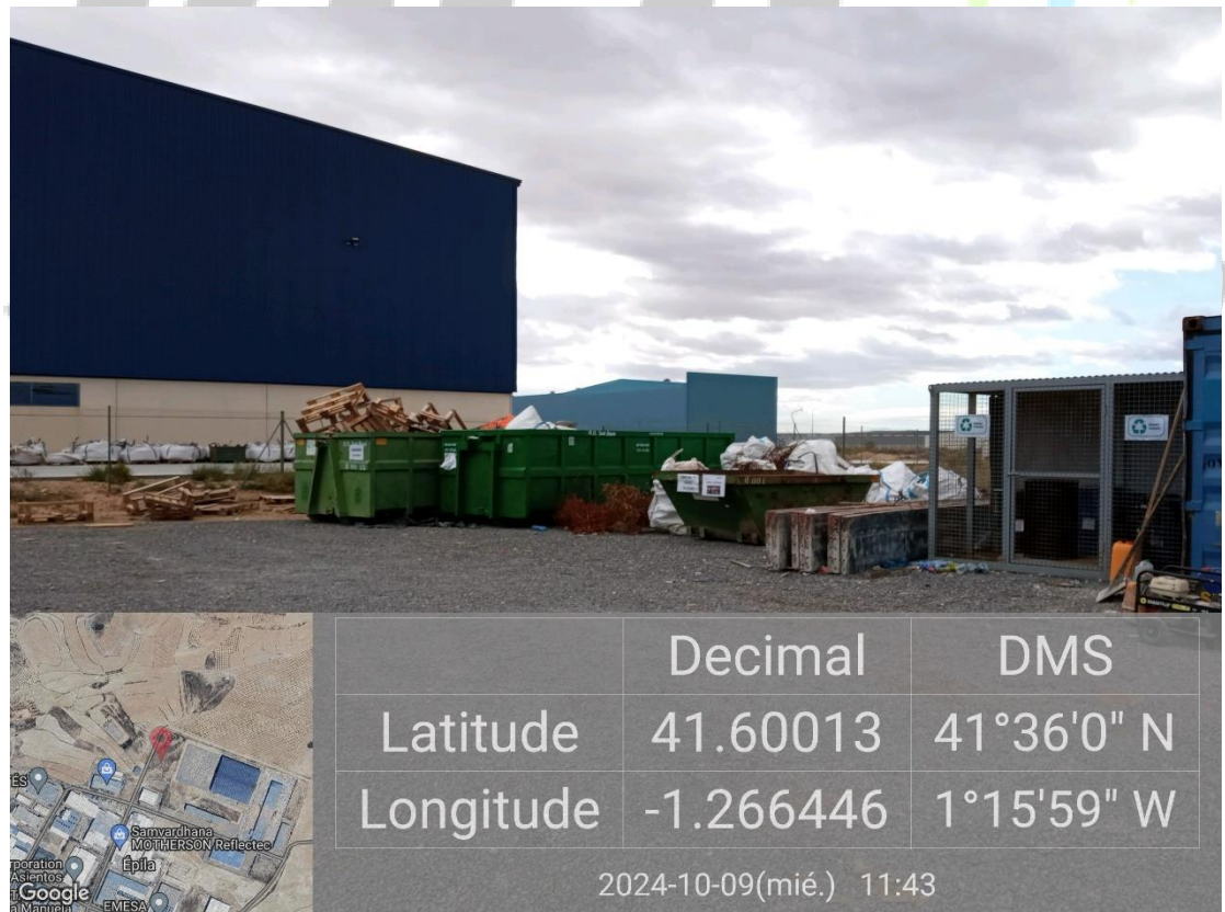
Ilustración 5. Punto limpio señalado con fotos específicas.
