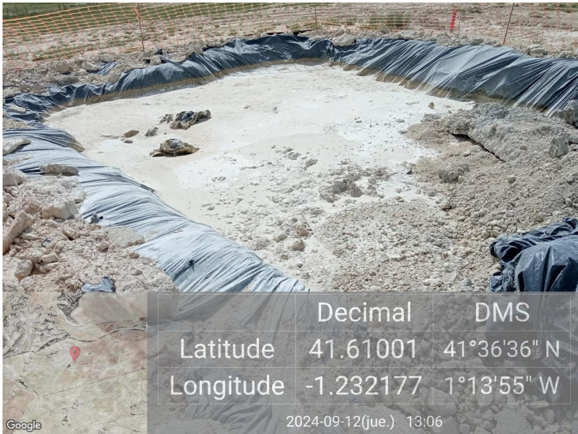
Ilustración 5. Balsa para la limpieza de cubas de hormigón de la plataforma 06 en buen estado de conservación.
