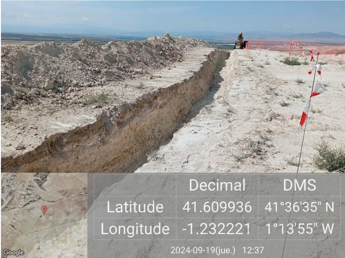
Ilustración 7. Apertura de zanja para la línea soterrada de media tensión.
