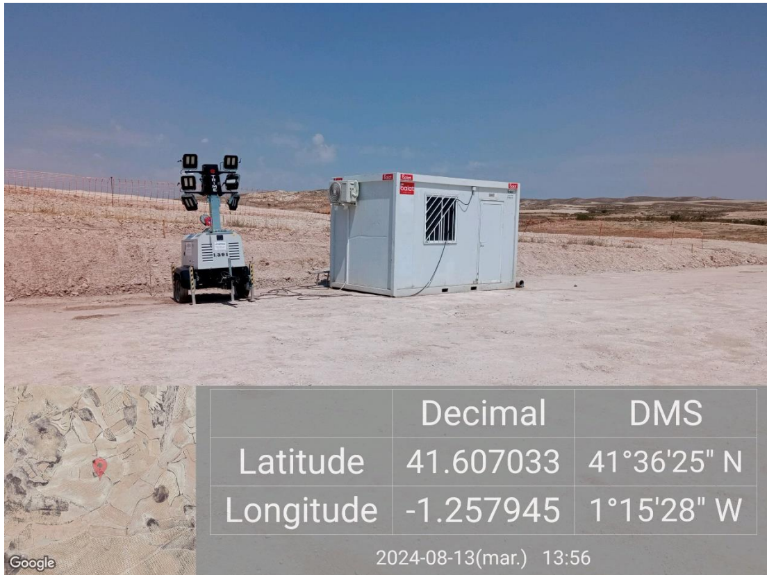
Ilustración 6. Caseta de obra temporal ubicada en plataforma 01 de color no fluorescente.
