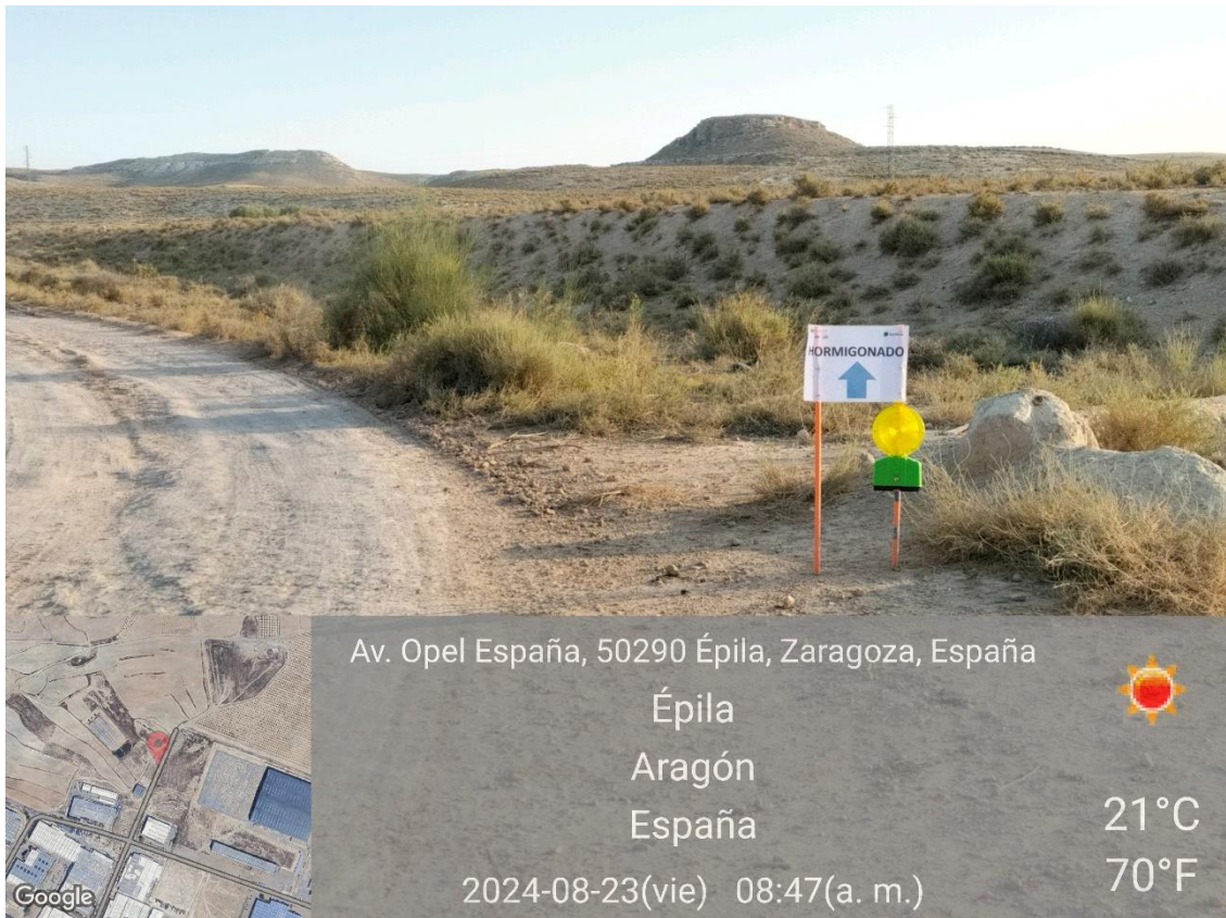
Ilustración 9. Señalización de obras.
