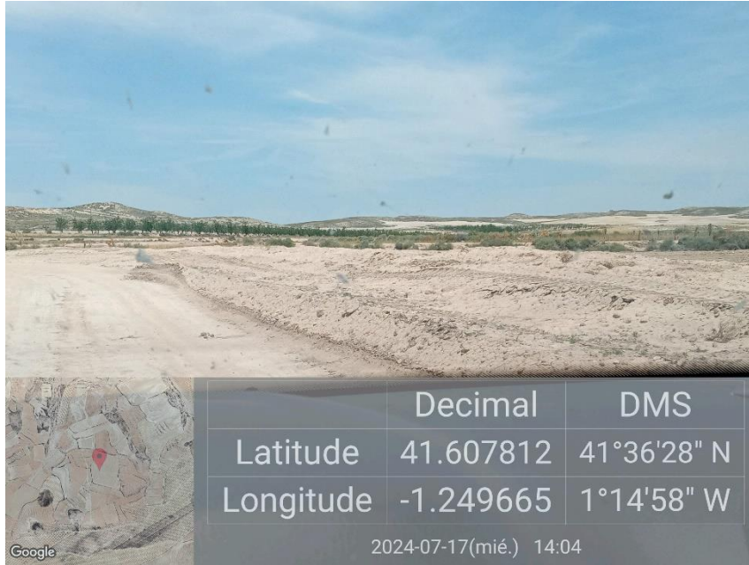
Ilustración 7. Ampliación de vial y retirada correcta de tierra vegetal.
