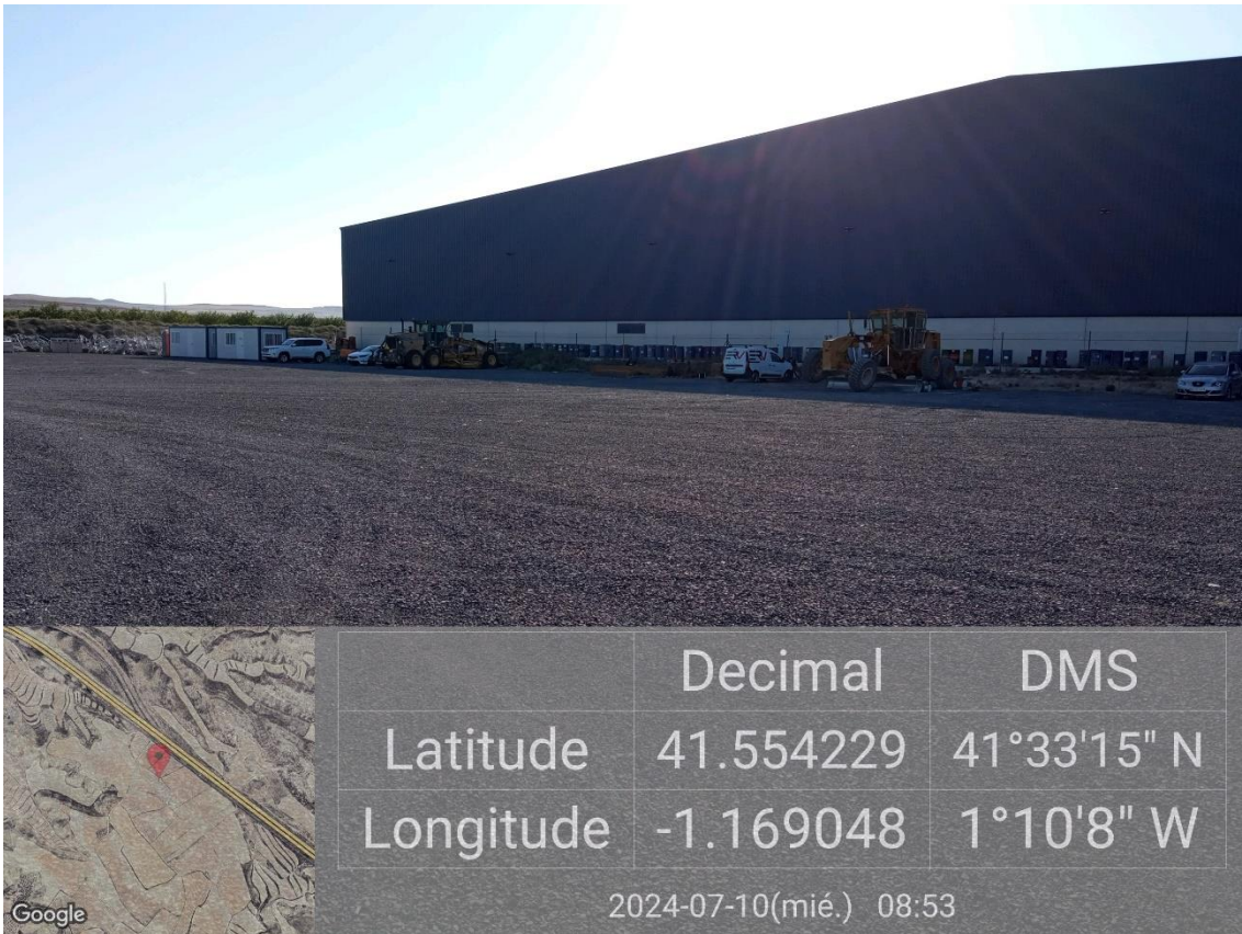
Ilustración 4. Parque de maquinaria en Campsite.
