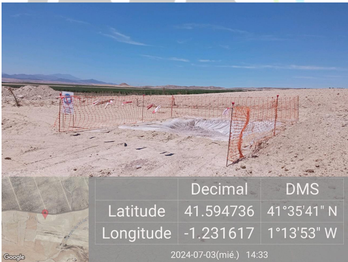
Ilustración 3. Zona de limpieza de cubas de hormigón.
