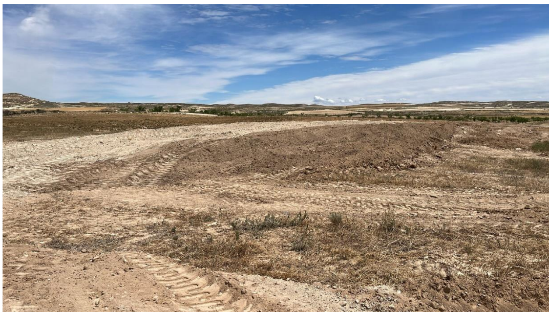
Ilustración 6. Acopio de tierra vegetal separado de la tierra inerte en el aerogenerador 01
