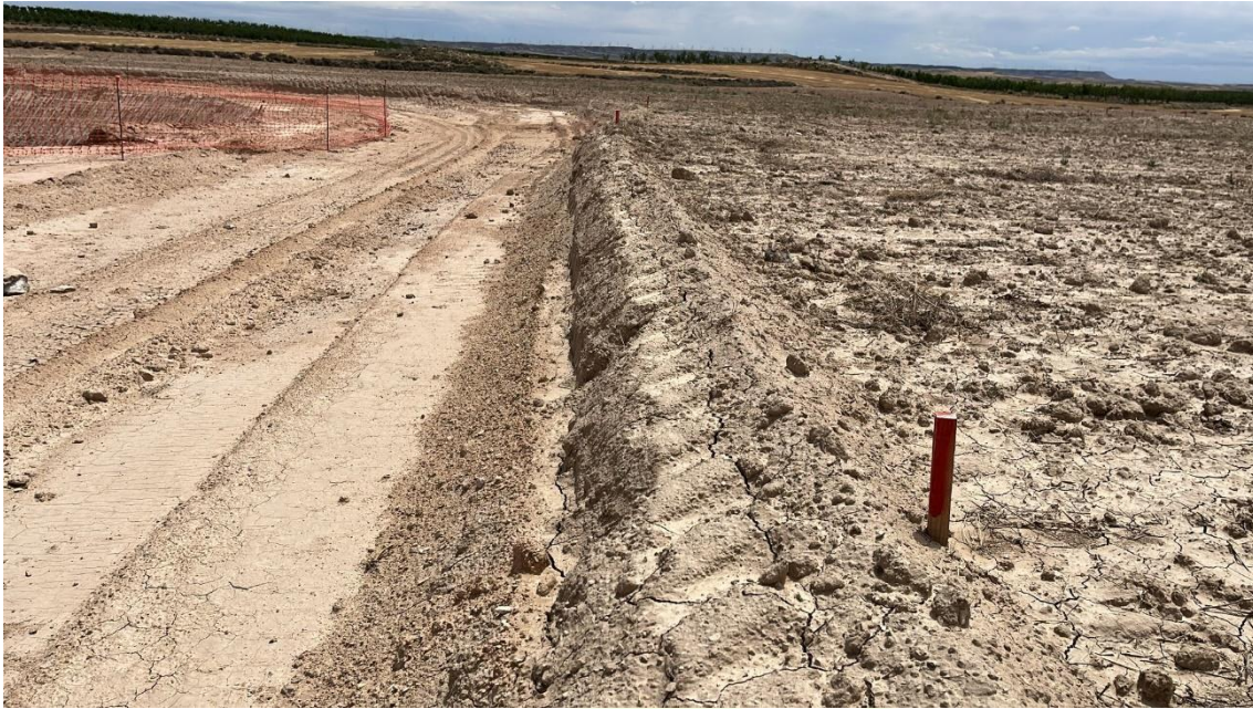
Ilustración 7. Límite de actuación de los trabajos en el aerogenerador 03.
