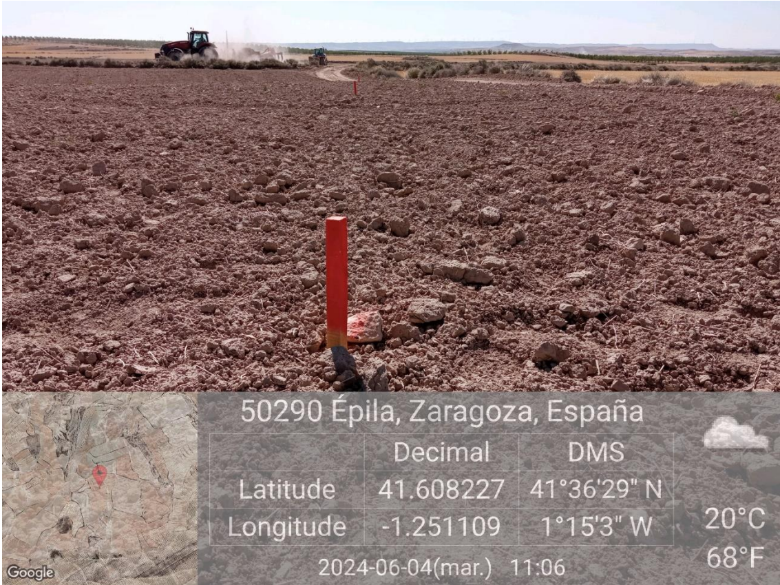
Ilustración 2. Balizado del aerogenerador 03.
