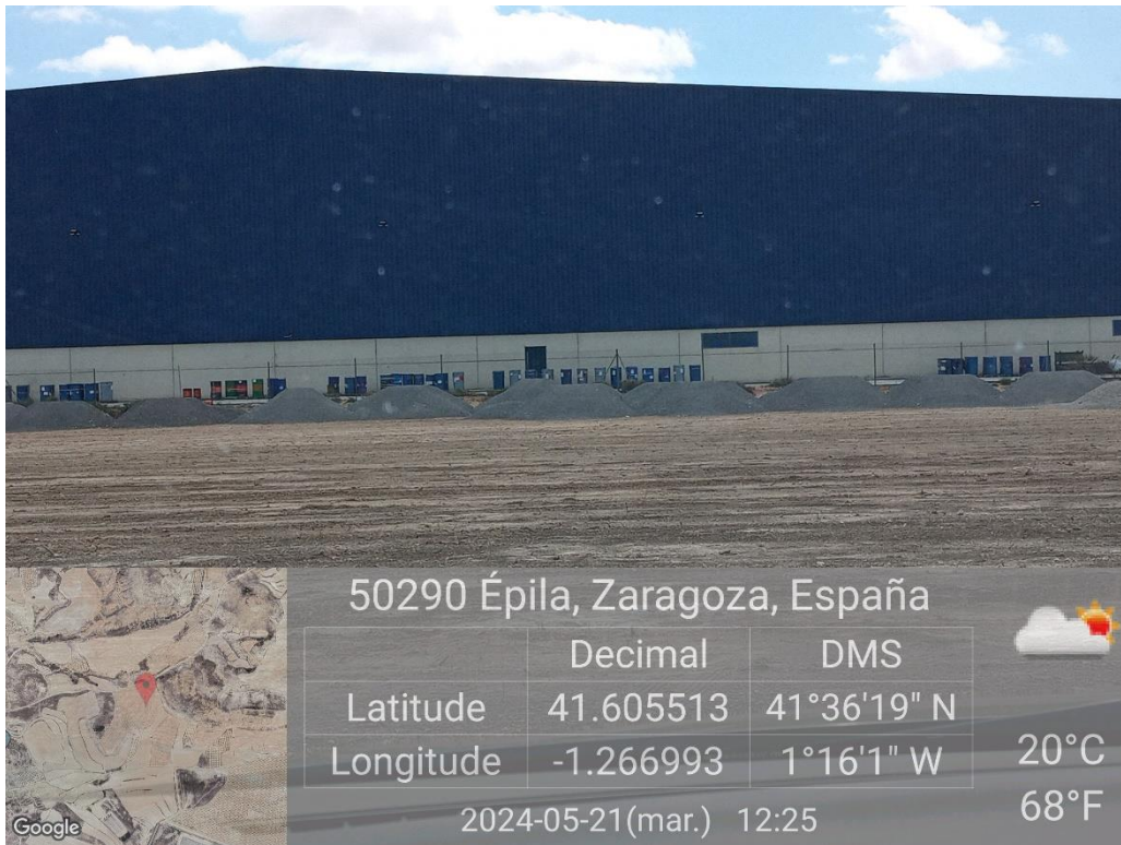
Ilustración 4. Acopio de zahorra en Campsite.
