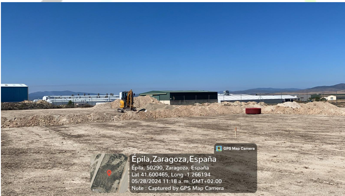
Ilustración 7. Movimientos de tierra en Campsite.
