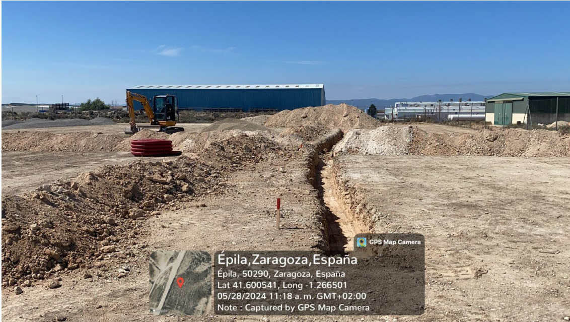
Ilustración 6. Apertura de zanja para canaletas en Campsite.
