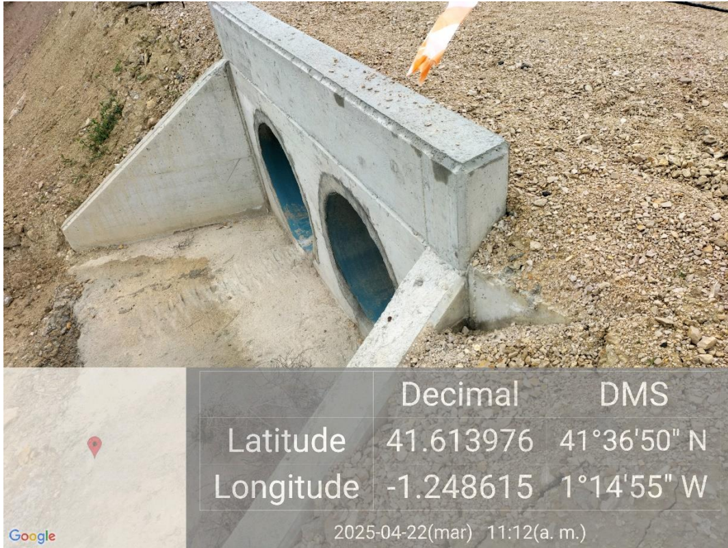
Ilustración 15. Construcción sistema de drenaje para asegurar la capacidad de desagüe y evitar acumulaciones de agua.
