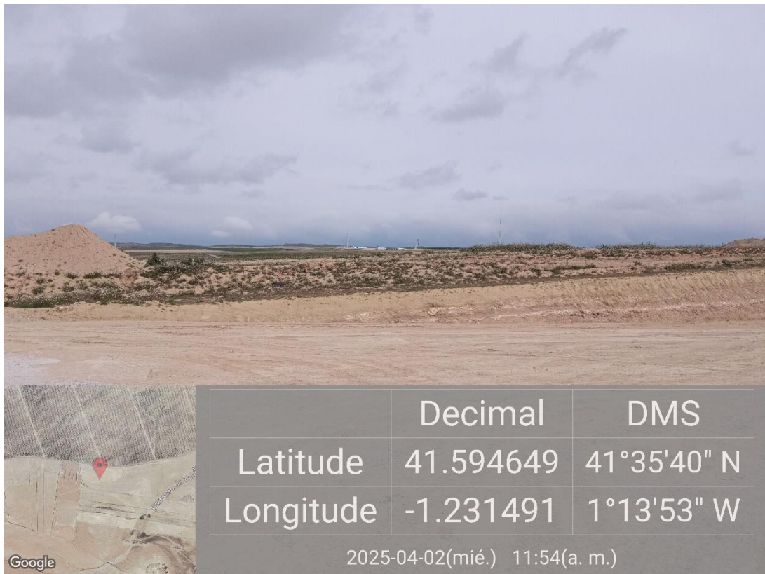
Ilustración 2. Tierra vegetal gestionada correctamente en la plataforma 08.
