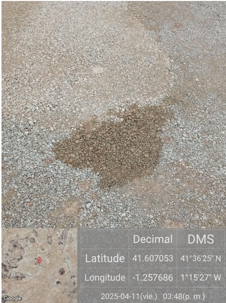
Ilustración 9. Mancha de vertido en plataforma 01.
