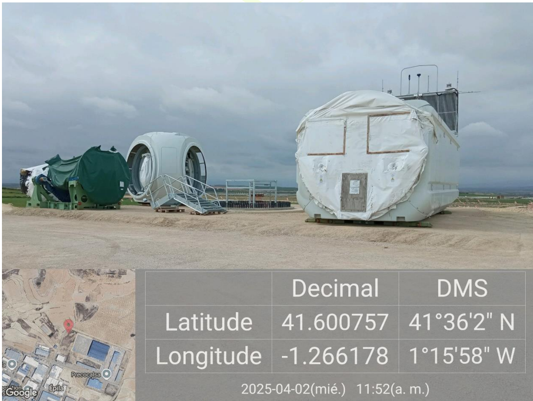
Ilustración 3. Componentes aerogenerador acopiados en plataforma sin afectar al drenaje ni a la vegetación natural.
