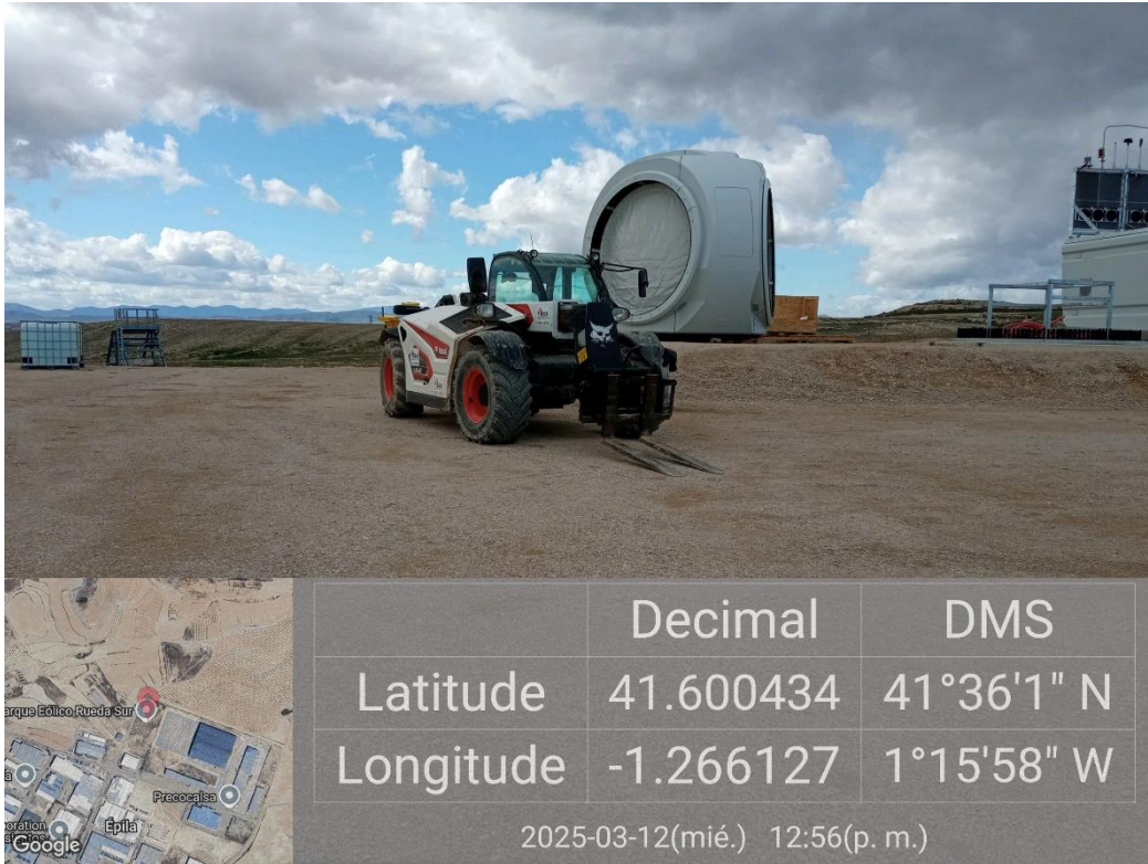
Ilustración 7. Maquinaria copiada en plataforma sin afectar a la vegetación natural
