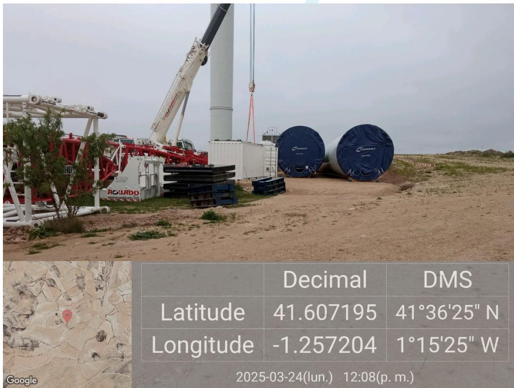
Ilustración 16. Acopio de materiales sobre tierra vegetal.
