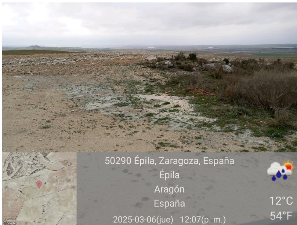
Ilustración 3. Vertido de hormigón derivado de la limpieza fuera de la balsa de hormigón
