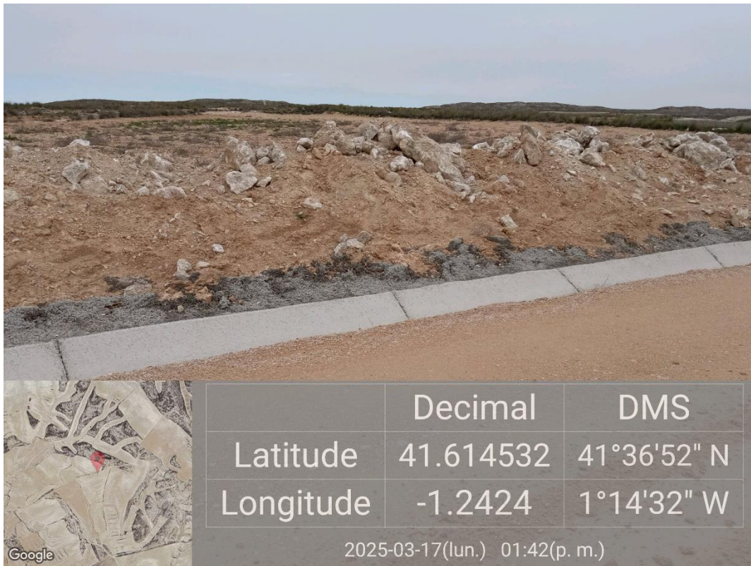
Ilustración 12. Vertido de hormigón a lo largo del recorrido de las cunetas
