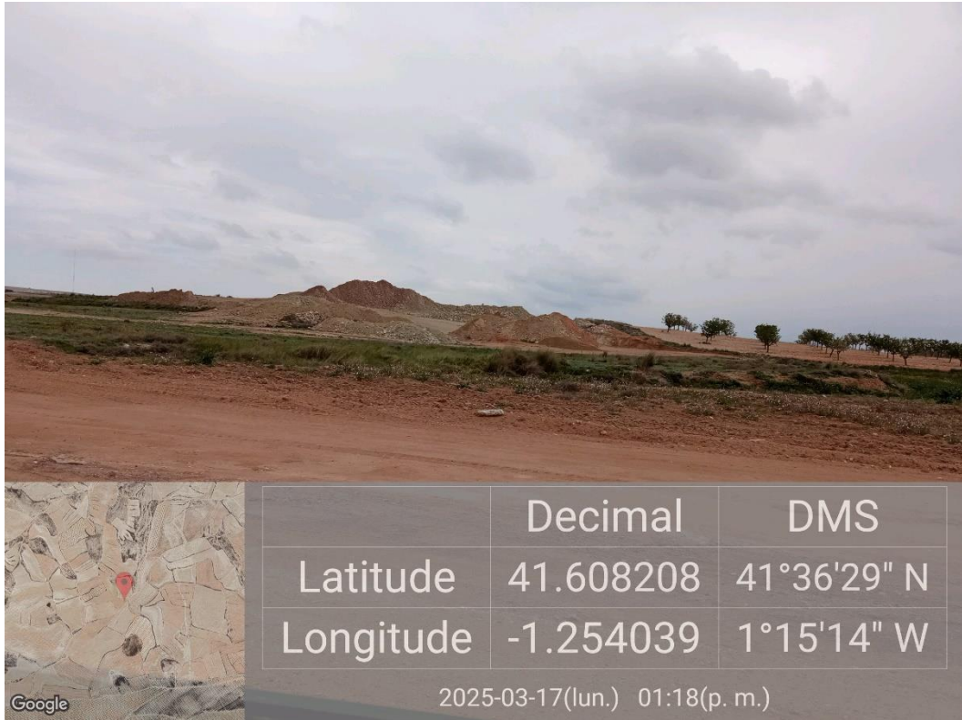
Ilustración 10. Zona de acopio y retirada de tierras.
