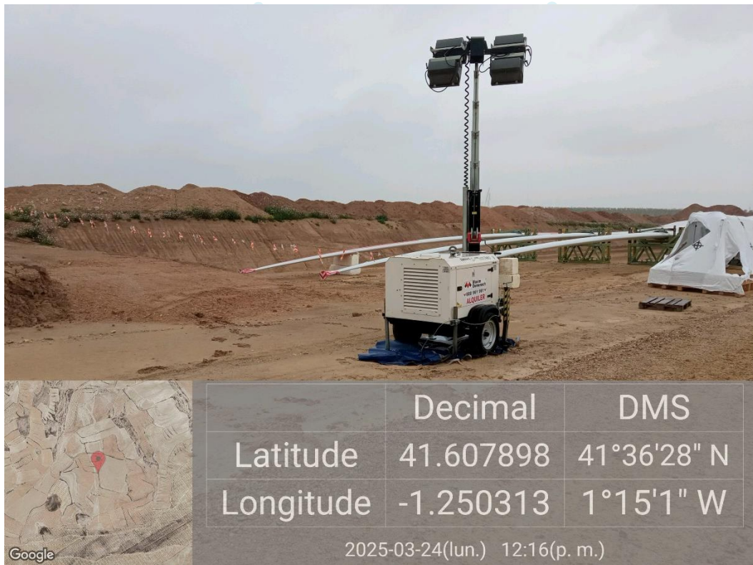
Ilustración 14. Generador acopiado correctamente sobre plástico aislante para prevenir vertidos.
