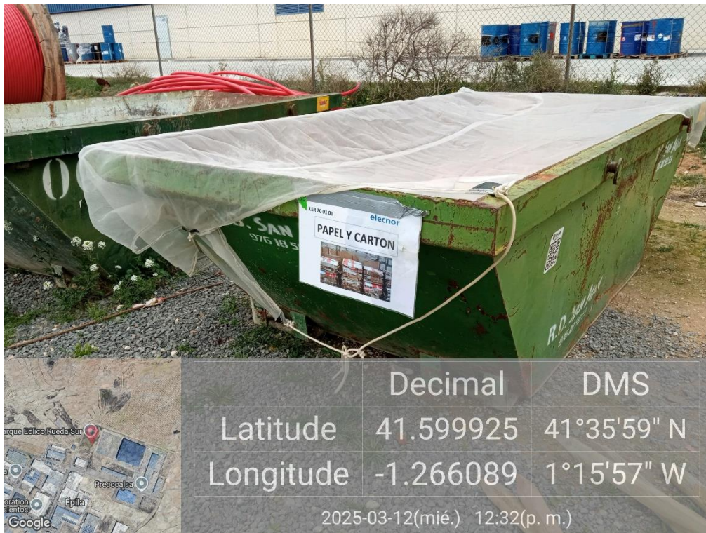
Ilustración 5. Contenedor señalizado y con medidas anti-dispersión de residuos en Campsite.
