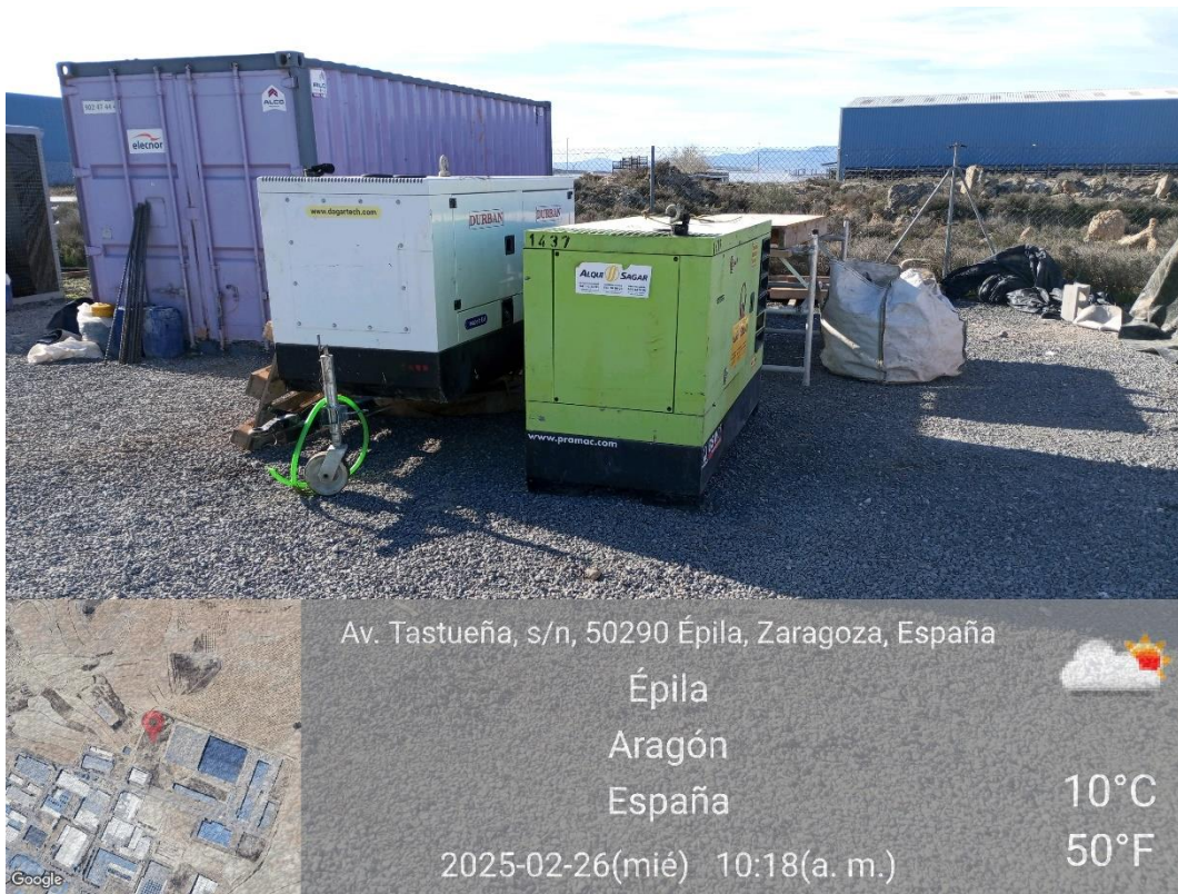
Ilustración 10. Generadores sin plástico aislante en el campsite.
