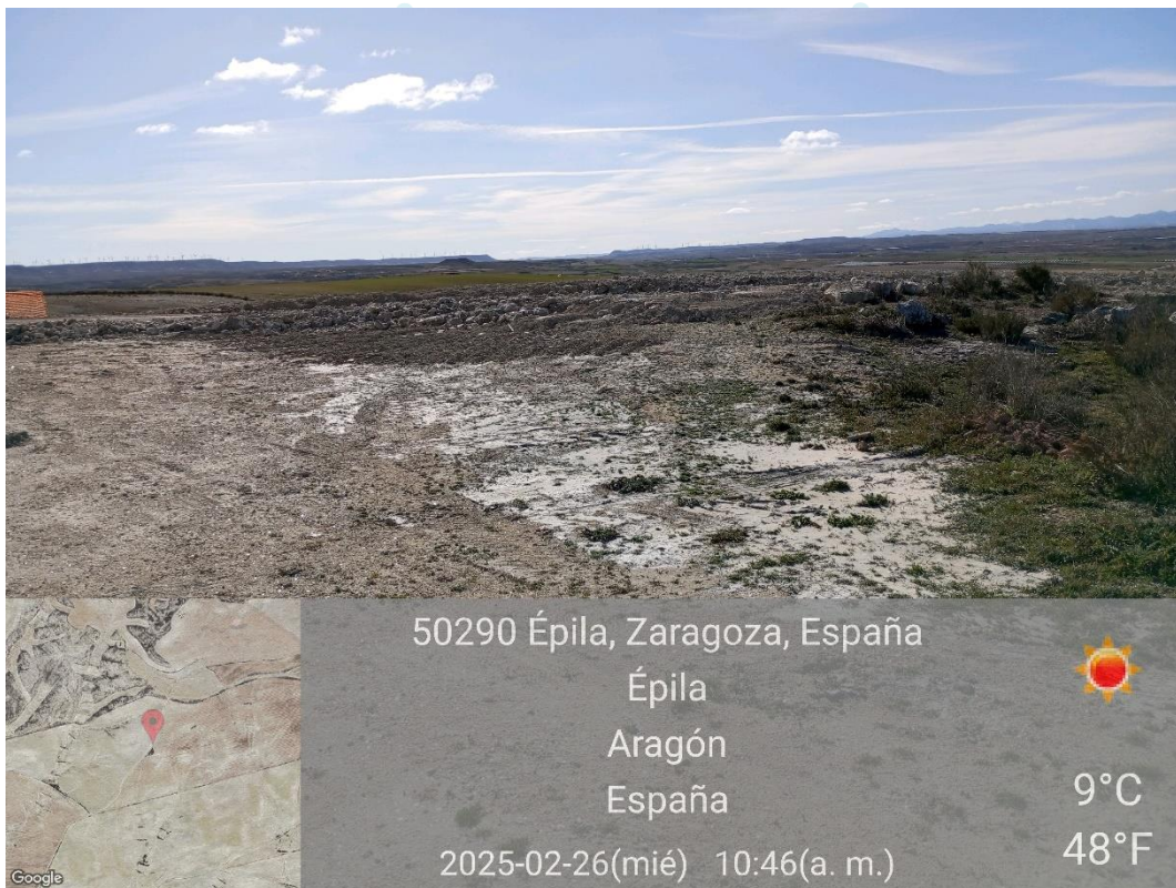
Ilustración 11. Vertido de hormigón.
