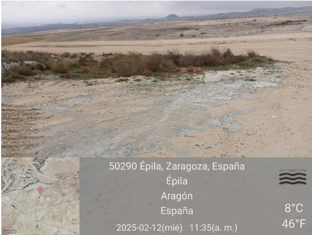
Ilustración 7. Vertido de hormigón.
