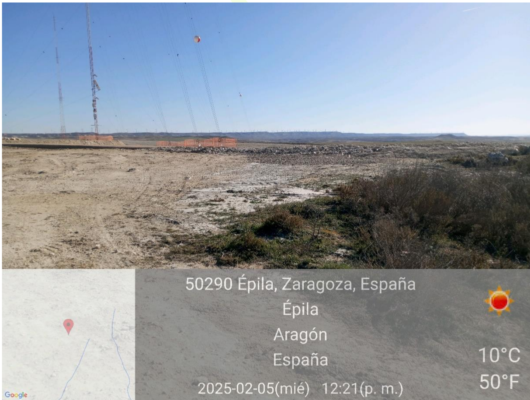
Ilustración 5. Vertido de hormigón.
