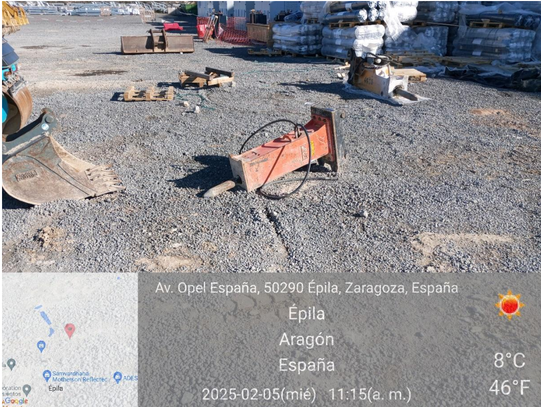
Ilustración 2. Martillo hidráulico del campsite sin material aislante antiderrame.
