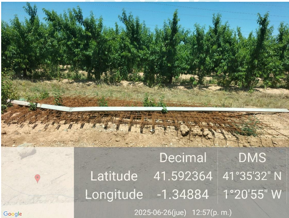
Ilustración 12. Material sobrante de drenaje sigue sin retirarse tras 2 semanas.
