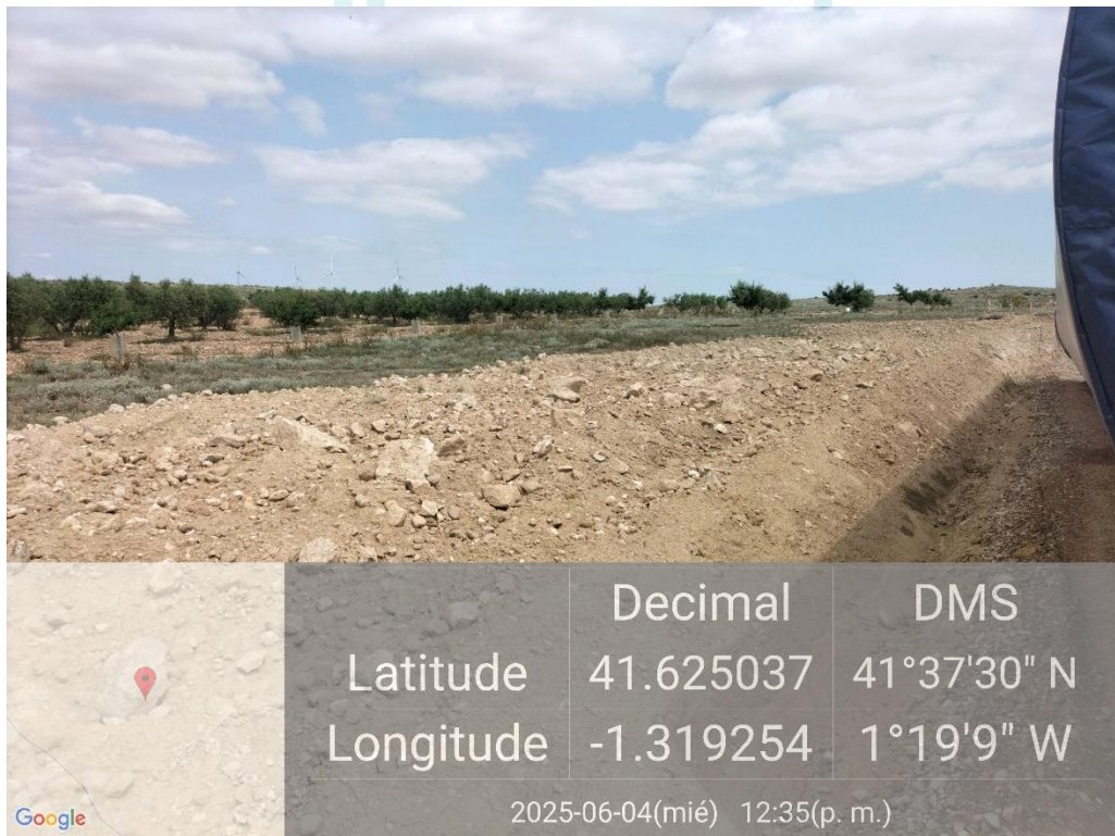
Ilustración 6. Zanja cerrada y descompactada.
