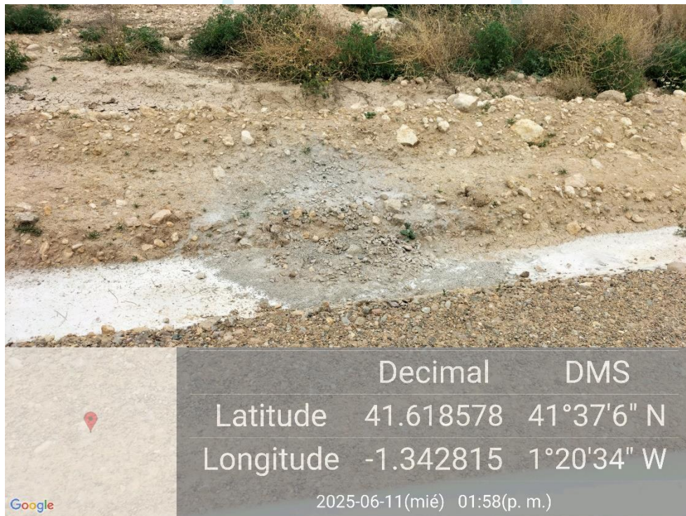
Ilustración 14. Lavado de hormigón en cuneta.
