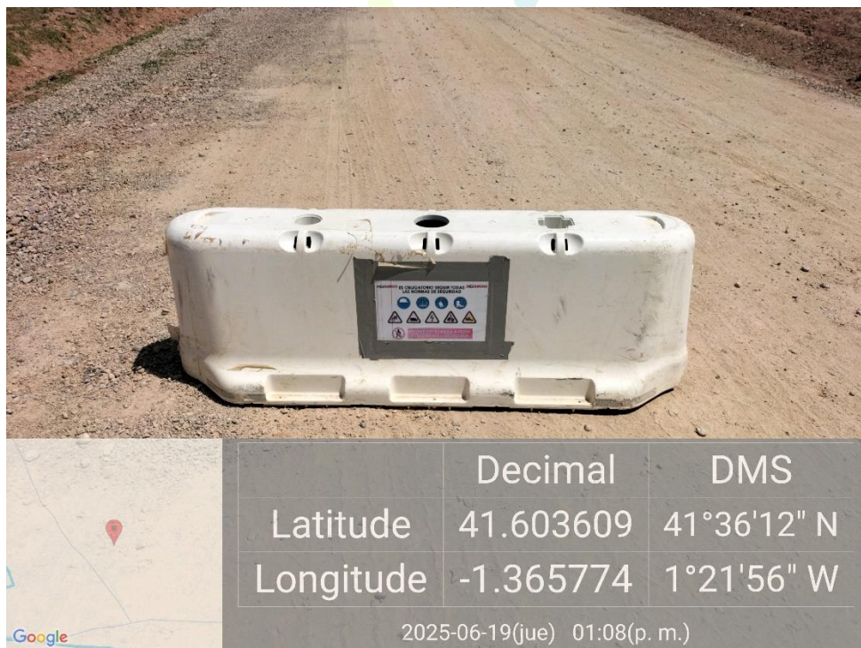
Ilustración 4. Señalización zona de obras, se cierra el acceso a la plataforma 02 por cargas suspendidas.
