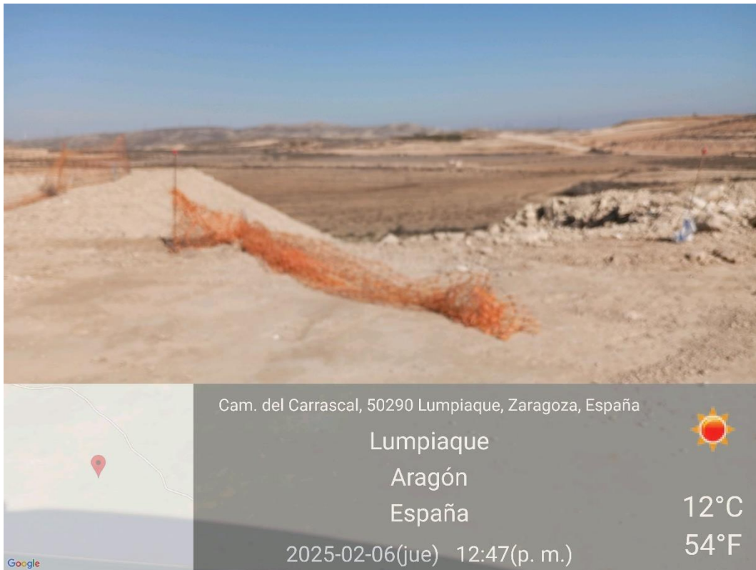
Ilustración 3. Balizamiento desprendido.
