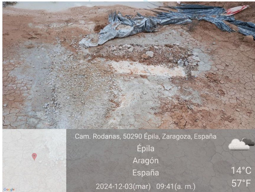
Ilustración 22. Limpieza de hormigón fuera de la balsa en plataforma 05..-
