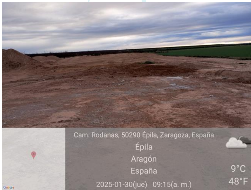
Ilustración 39. Balse de hormigón retirada en la plataforma 05.
