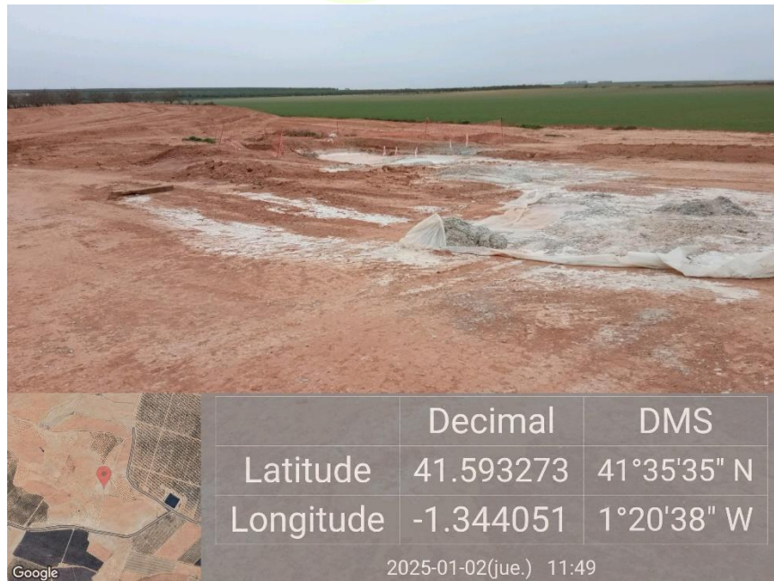
Ilustración 31. Limpieza de hormigón fuera de la balsa.
