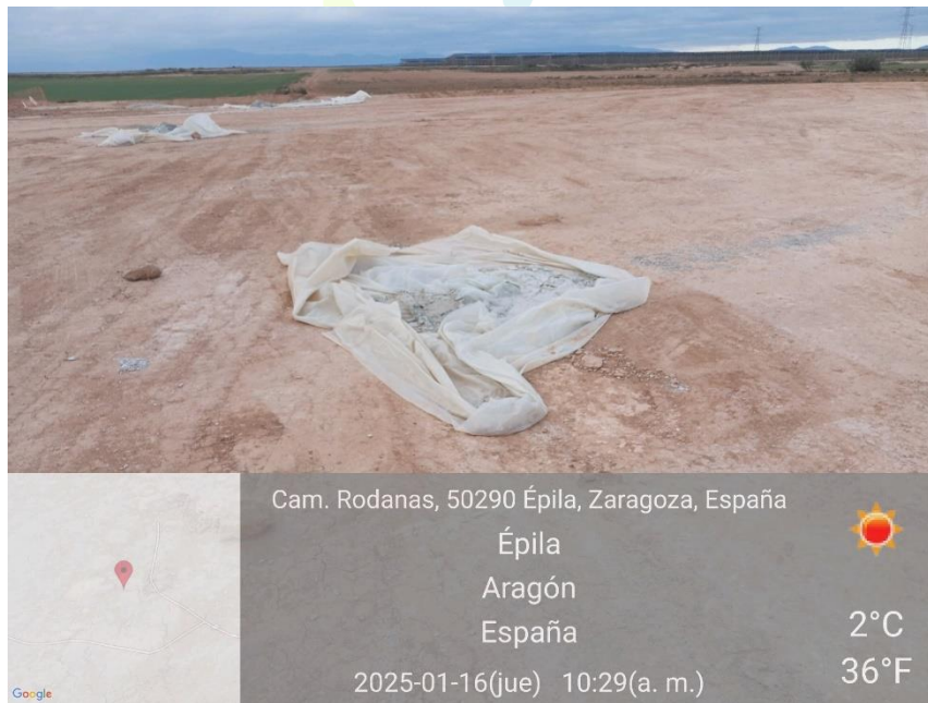
Ilustración 35. Limpieza de hormigón fuera de la balsa.
