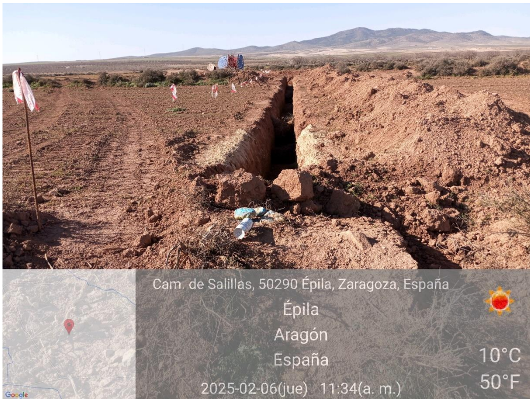
Ilustración 2. Botes de aerosoles abandonados en la zona de actuación.
