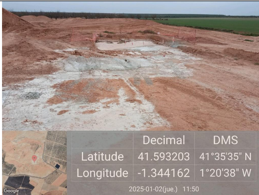
Ilustración 32. Balsa de hormigón sin material aislante.
