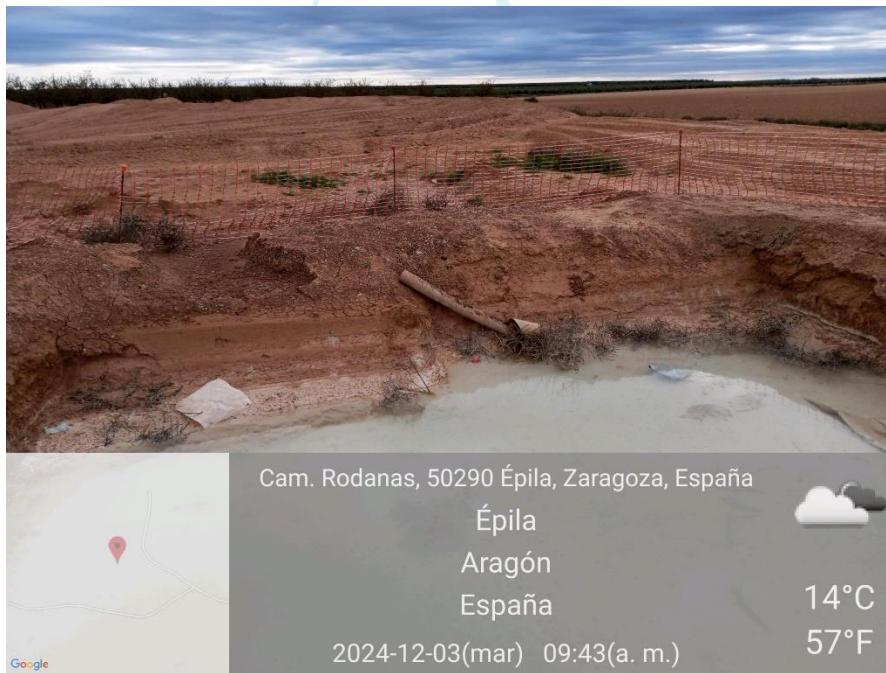
Ilustración 20. Balsa de hormigón sin material aislante en plataforma 05.
