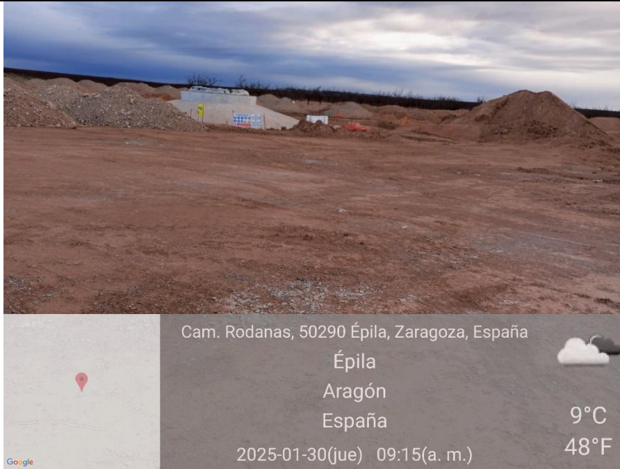
Ilustración 40. Vertido de hormigón corregido en la plataforma 05.
