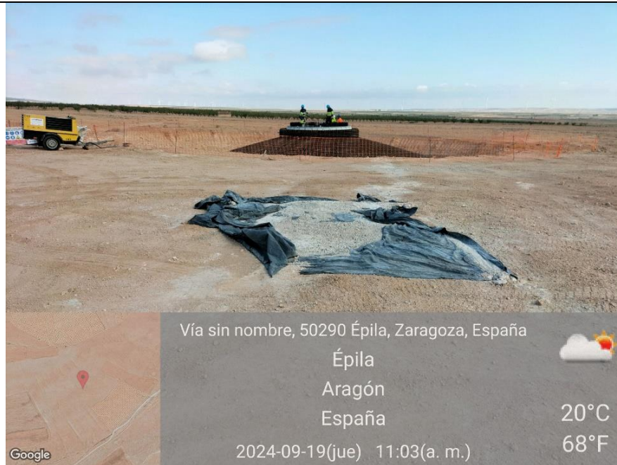
Ilustración 7. Limpieza de hormigón fuera de la balsa en la plataforma 01.
