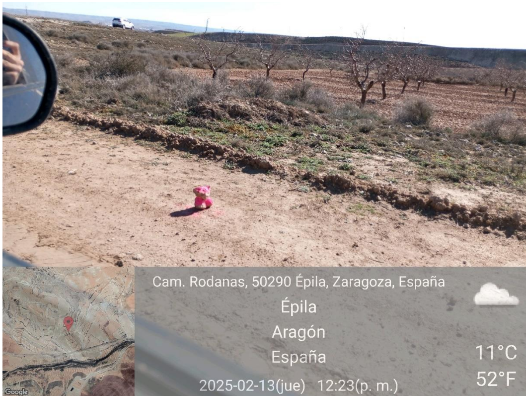
Ilustración 41. Piedra marcada con pintura (sería preferible utilizar estacas de madera).
