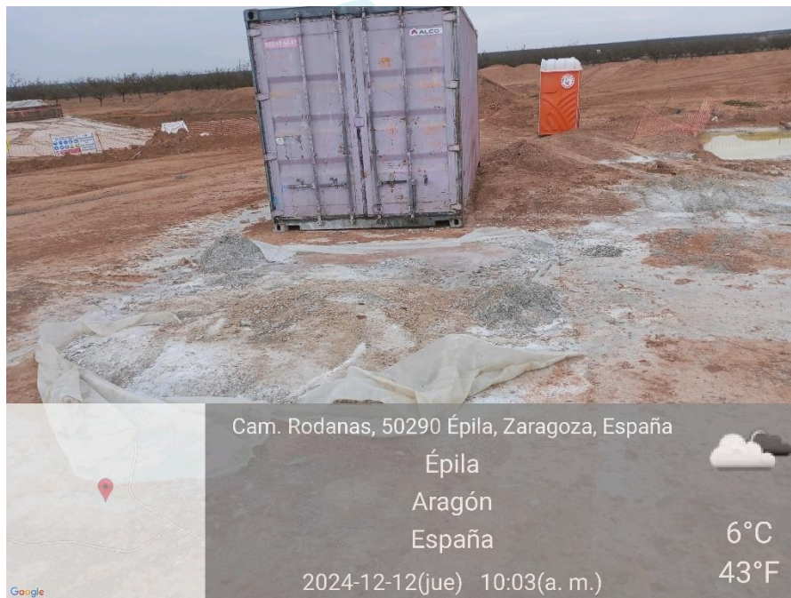
Ilustración 24. Limpiezas de hormigón fuera de la balsa en plataforma 05.
