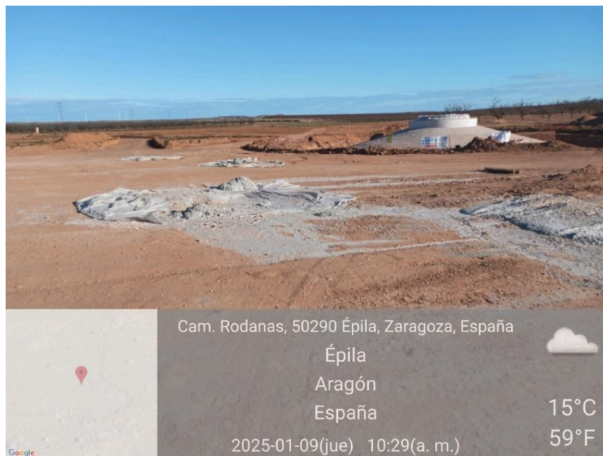
Ilustración 33. Limpieza de hormigón fuera de la balsa.
