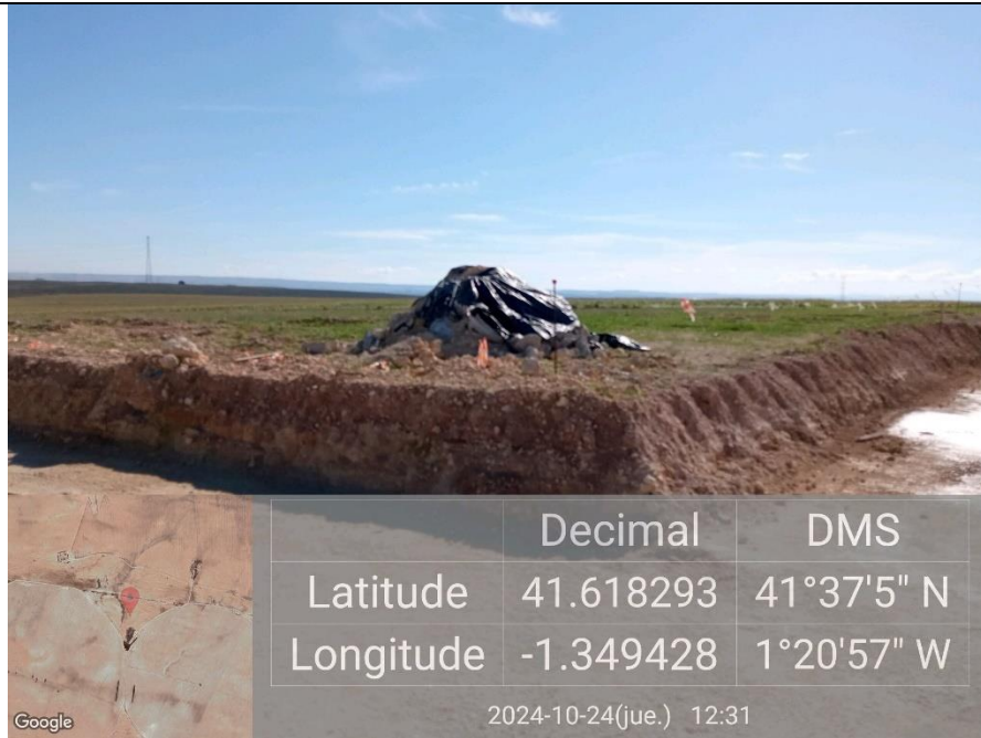
Ilustración 22. Continúa acopio de resto de balsa en plataforma 04.
