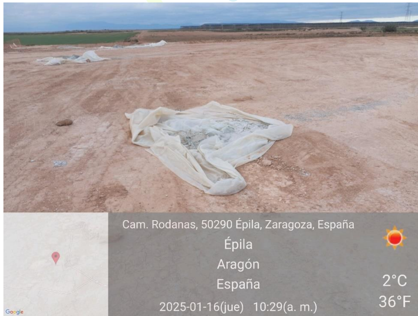
Ilustración 40. Limpieza de hormigón fuera de la balsa.
