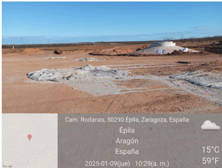
Ilustración 38. Limpieza de hormigón fuera de la balsa.
