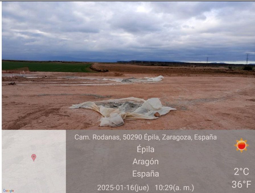
Ilustración 41. Limpieza de hormigón fuera de la balsa.
