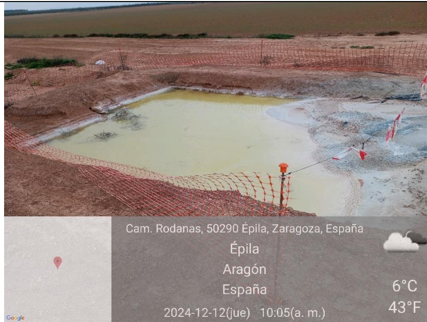
Ilustración 28. Balsa de hormigón sin material aislante en plataforma 05.
