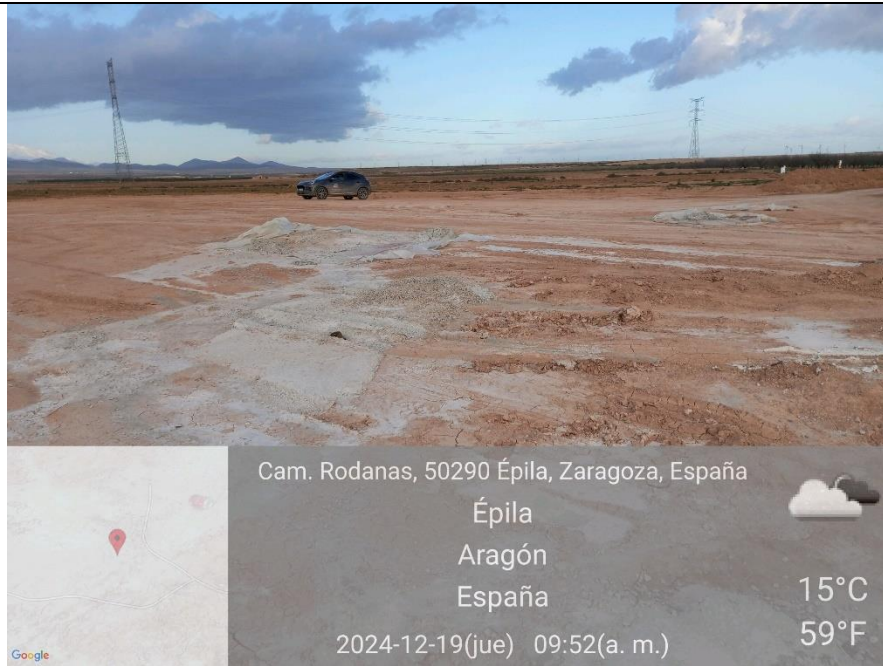
Ilustración 35. Limpiezas de hormigón fuera de la balsa.
