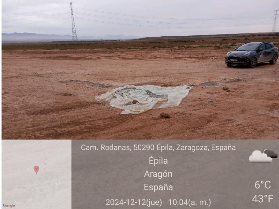
Ilustración 32. Limpiezas de hormigón fuera de la balsa en plataforma 05.
