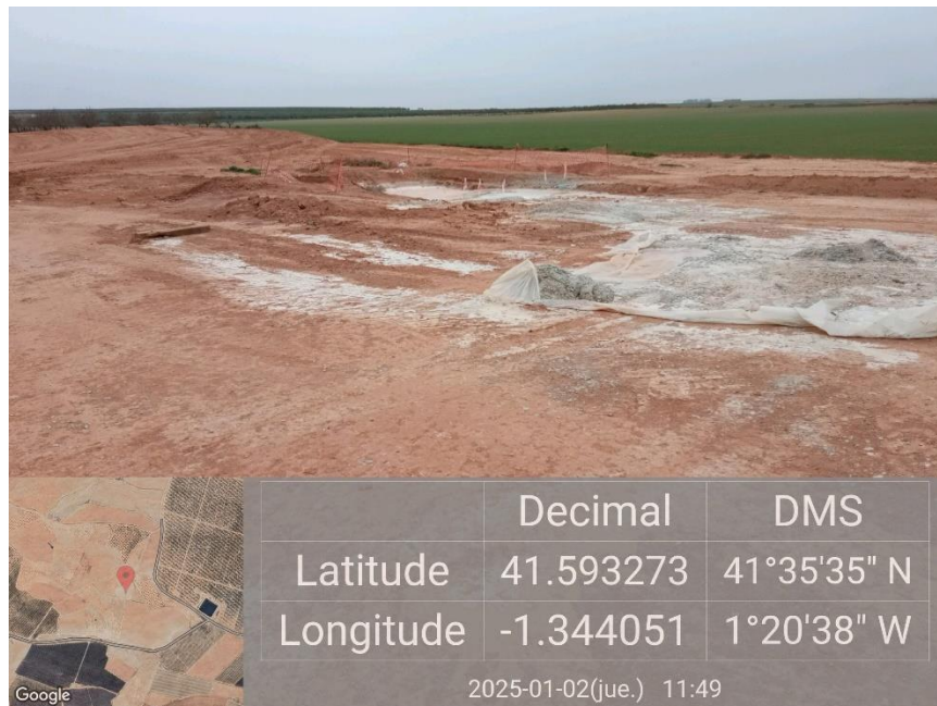
Ilustración 36. Limpieza de hormigón fuera de la balsa.
