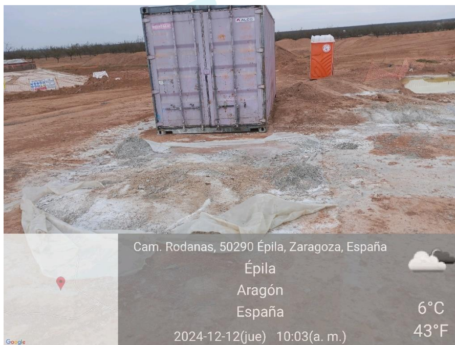
Ilustración 29. Limpiezas de hormigón fuera de la balsa en plataforma 05.
