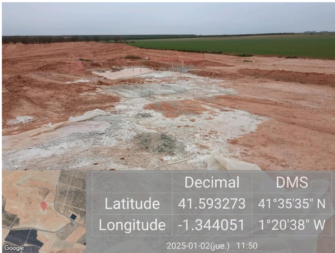
Ilustración 2. Vertidos de hormigón en plataforma 05.
