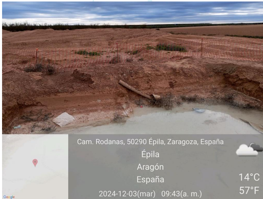
Ilustración 25. Balsa de hormigón sin material aislante en plataforma 05.
