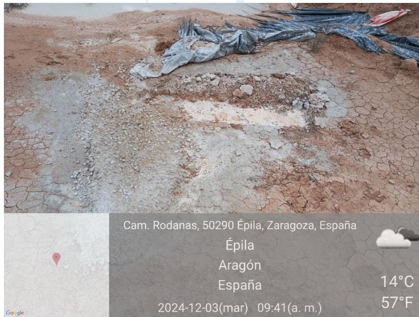
Ilustración 27. Limpieza de hormigón fuera de la balsa en plataforma 05.-
