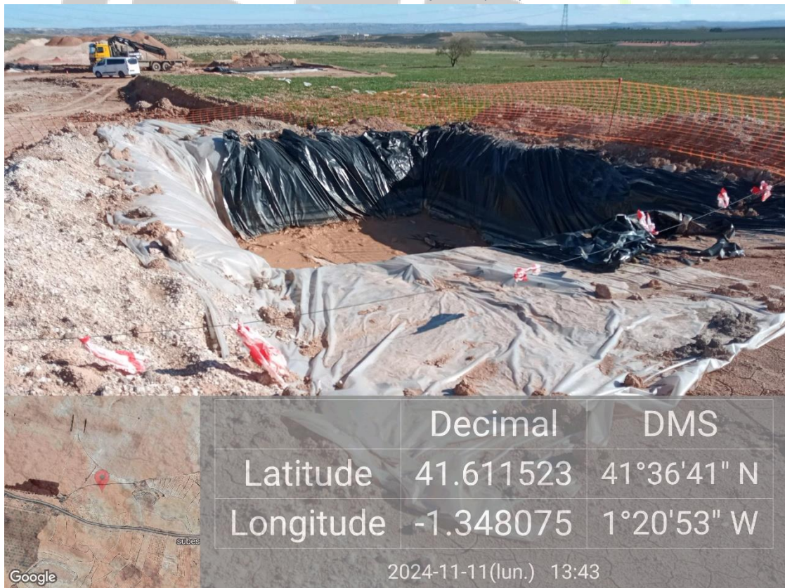
Ilustración 5. Balsa de hormigón de la plataforma 03 en correcto estado.
