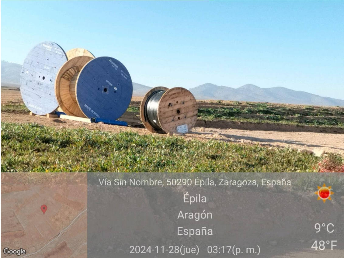
Ilustración 10. Acopio de material fuera de zonas de vegetación natural.
