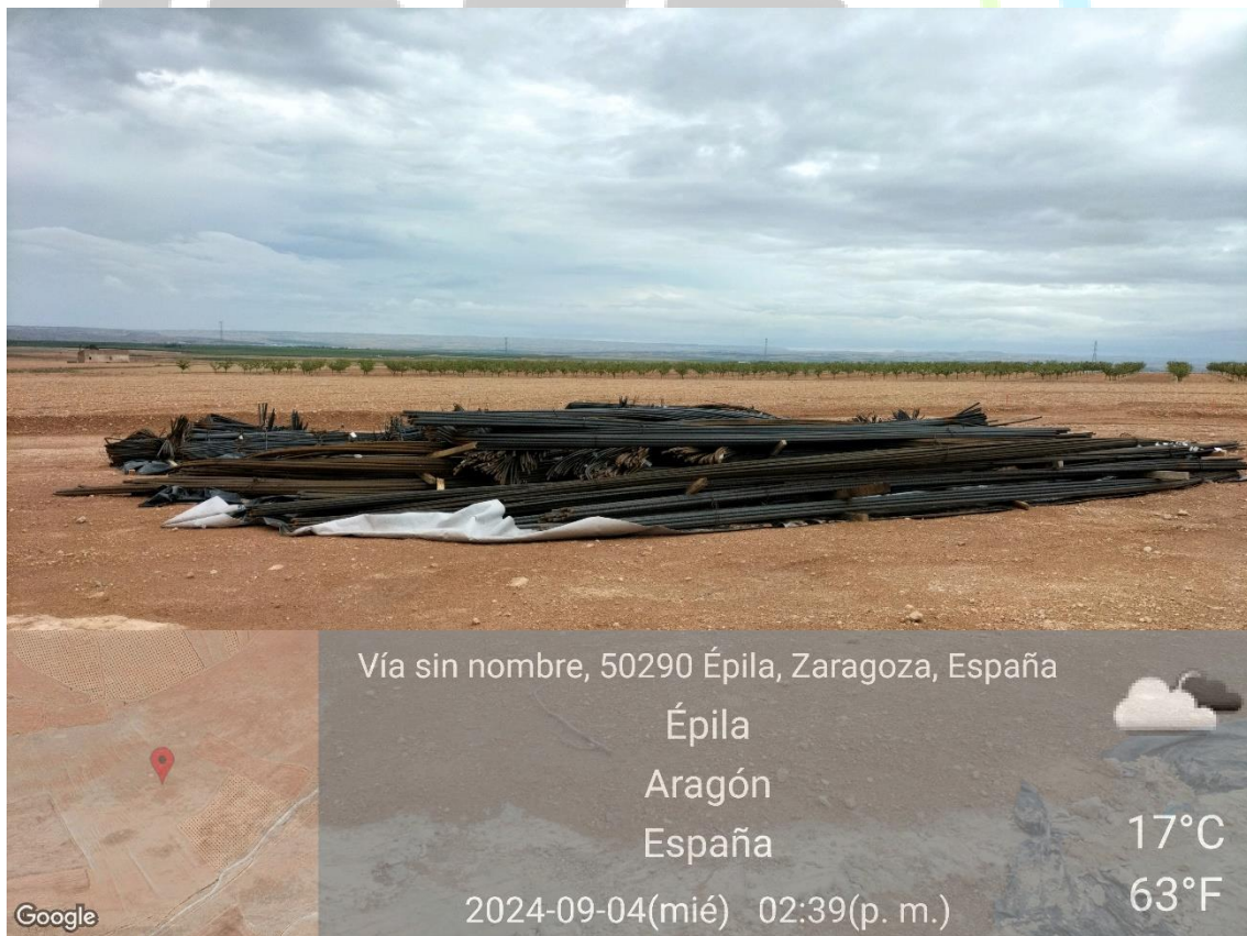
Ilustración 3. Acopio de material de ingeniería de la plataforma 01.
