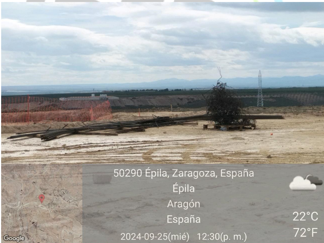
Ilustración 9. Acopio de ferralla de la plataforma 06.
