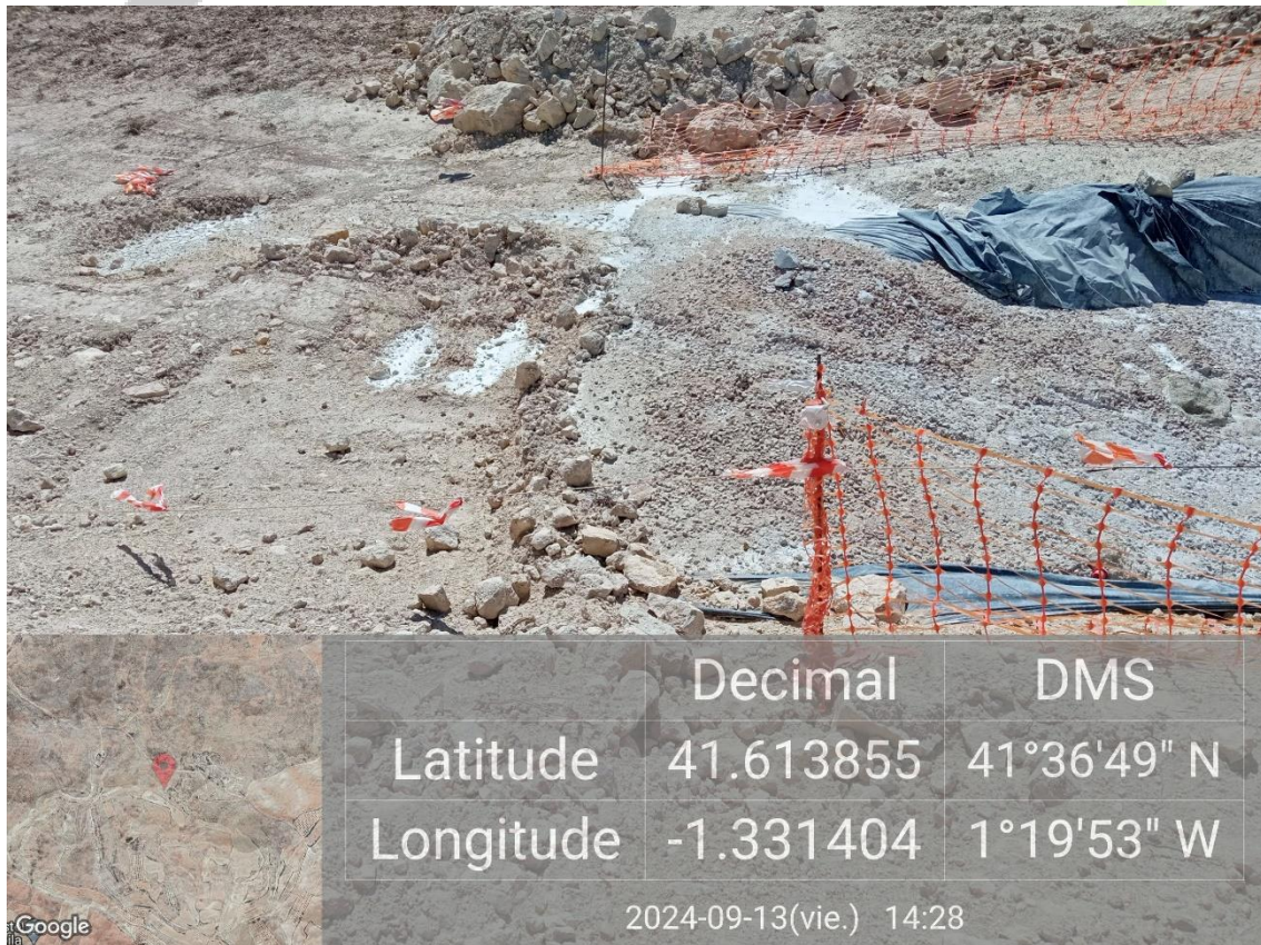
Ilustración 4. Balsa para la limpieza de hormigón de la plataforma 06 con restos de hormigón fuera.
