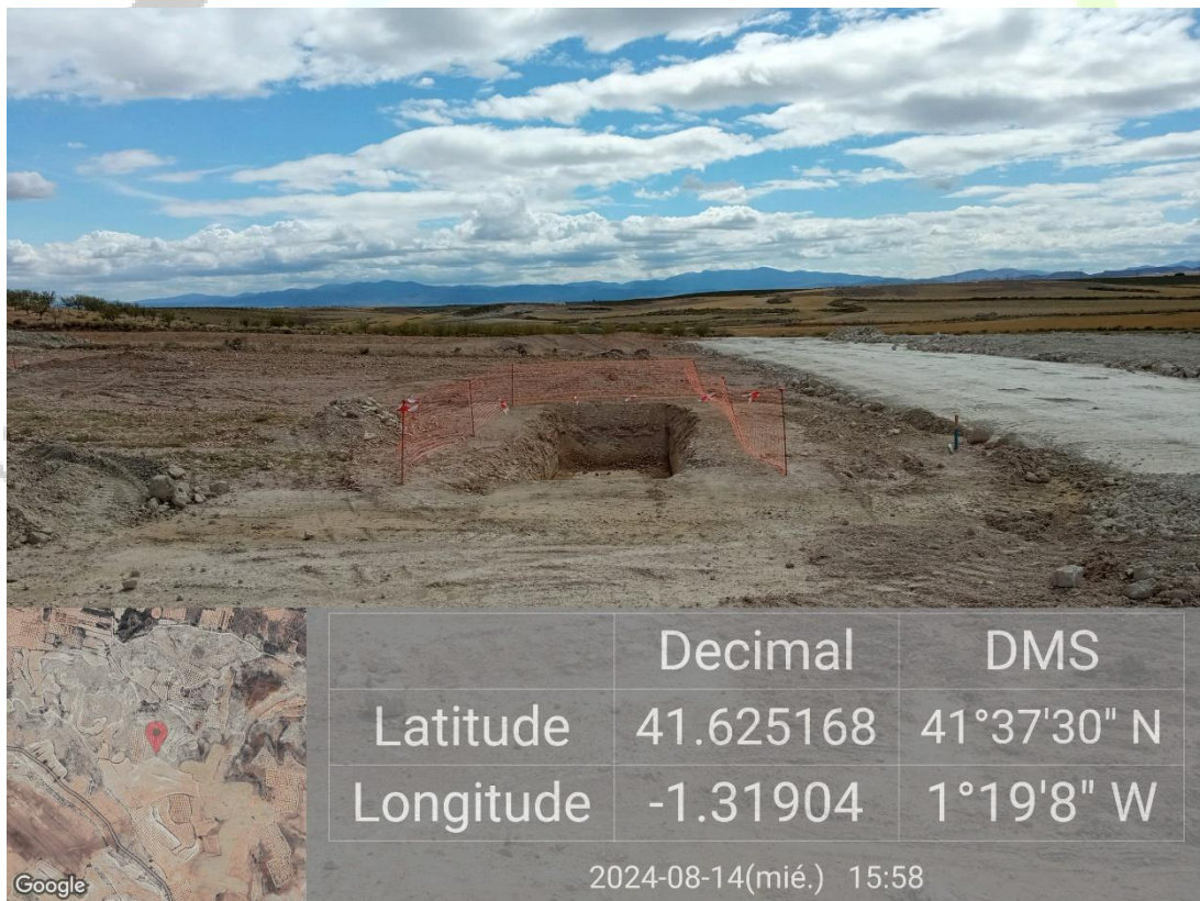
Ilustración 6. Excavado de la balsa para la limpieza de hormigón de la plataforma 08.
