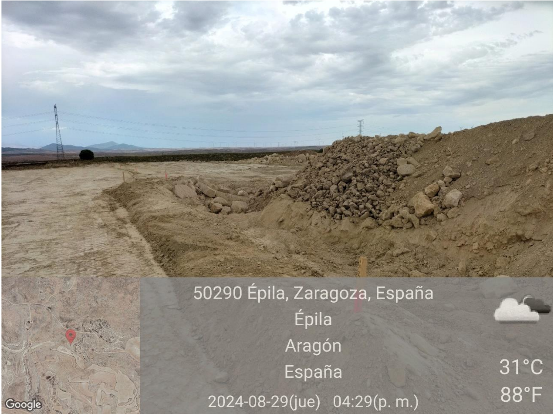
Ilustración 10. Acopio de sobrantes de excavación correctamente acopiados en la plataforma 06.
