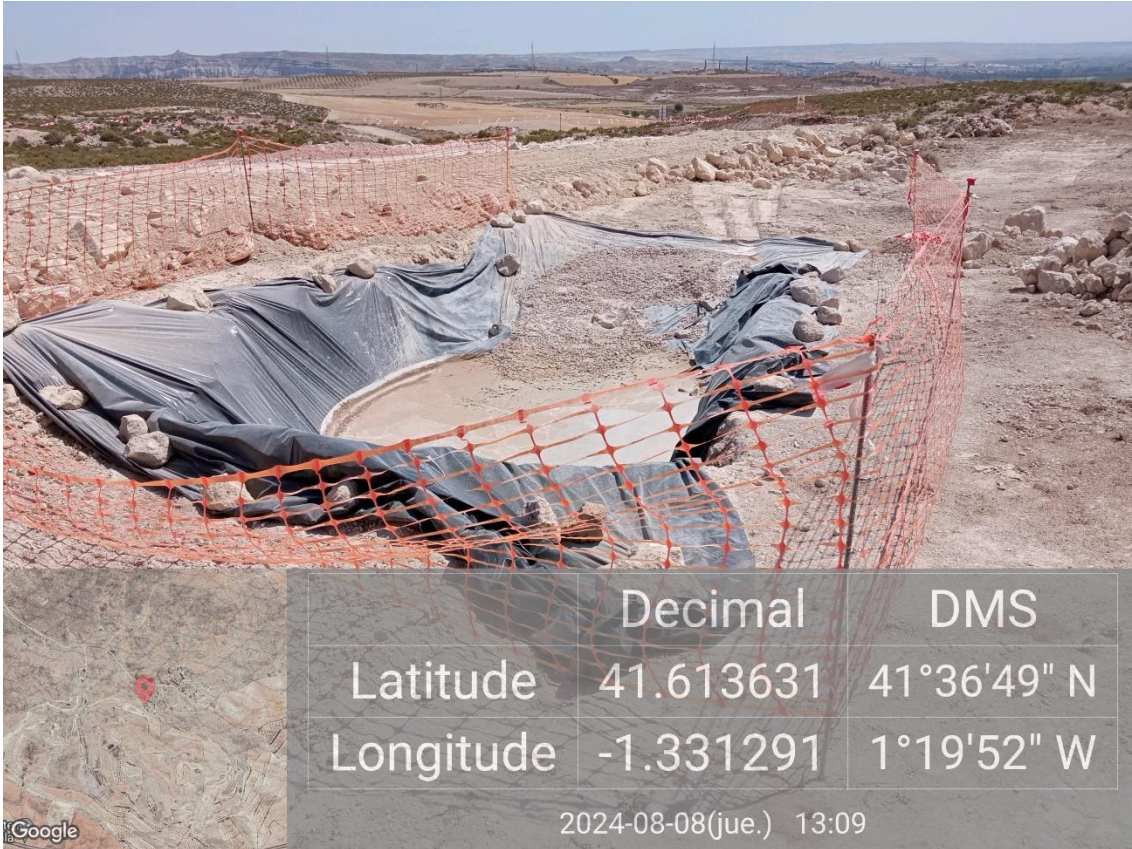
Ilustración 5. Balsa para la limpieza de hormigón de la plataforma 06.
