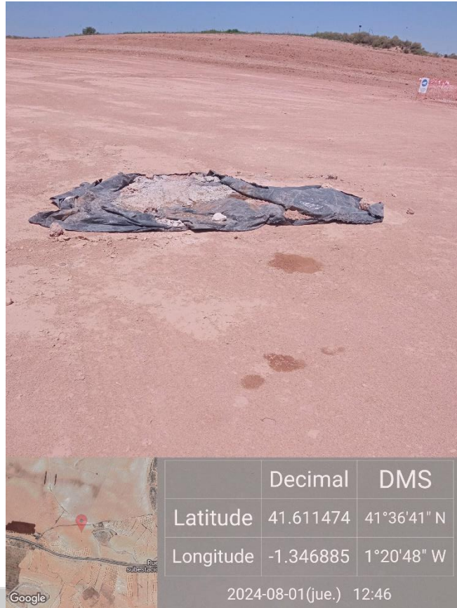
Ilustración 2. Vertido fuera de plástico protector en plataforma 06.
