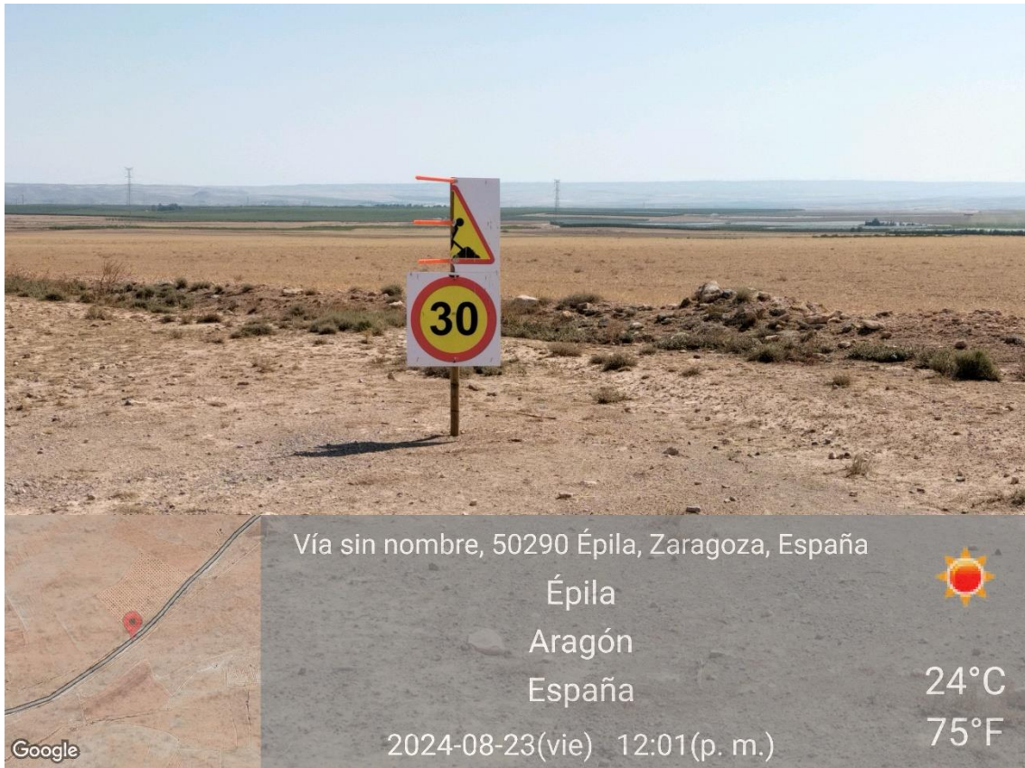
Ilustración 8. Señalización de limitación de velocidad rota.
