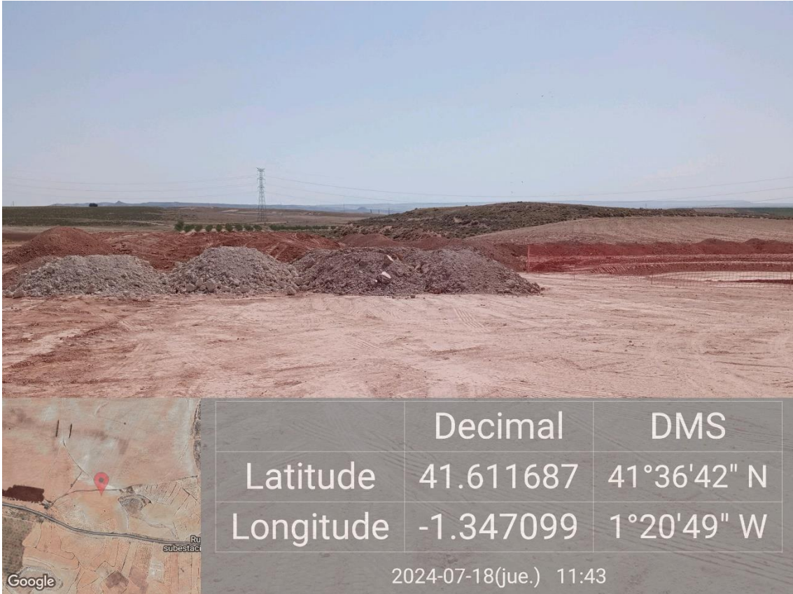
Ilustración 6. Acopio de sobrantes de excavación sin mezclar con la tierra vegetal.
