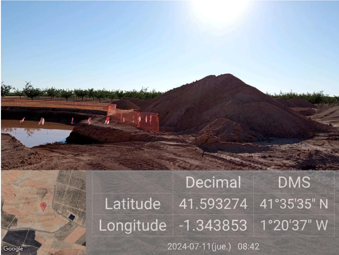
Ilustración 4. Acopio de sobrantes de excavación sin mezclar con la tierra vegetal.
