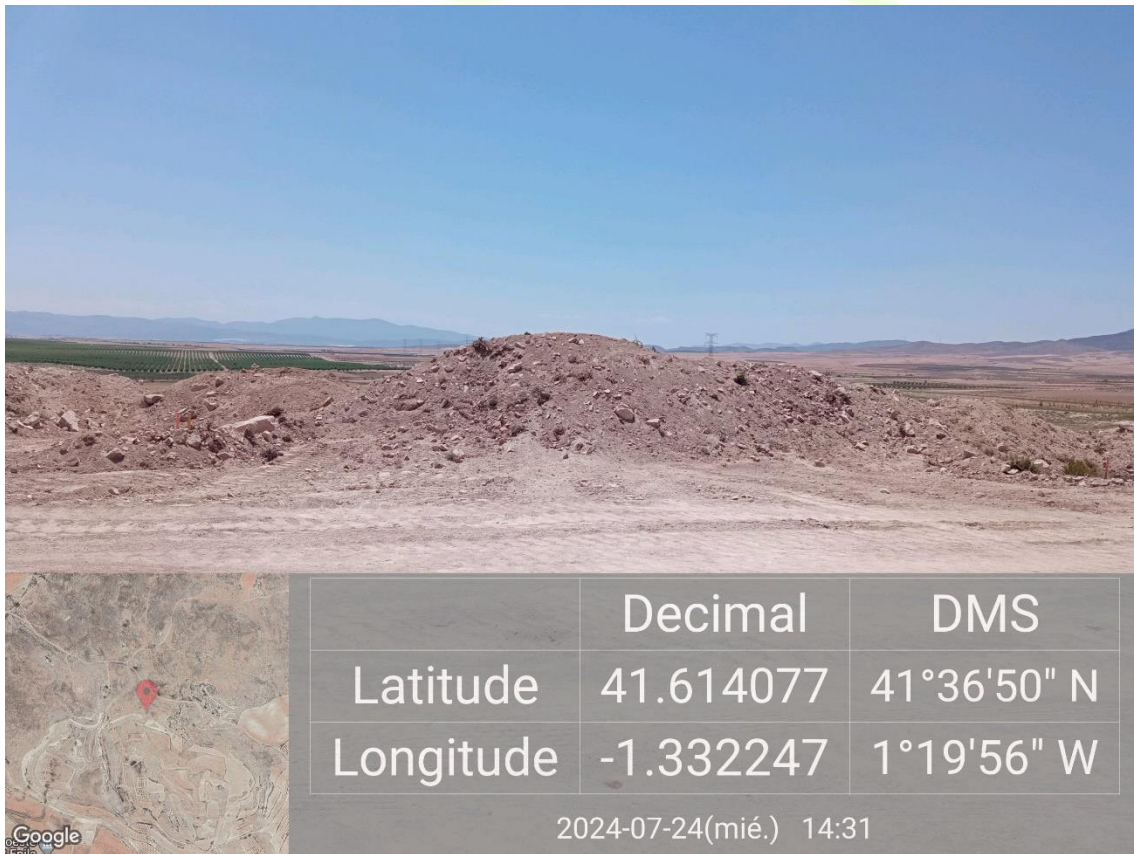
Ilustración 8. Acopio de sobrantes de excavación sin mezclar con la tierra vegetal.
