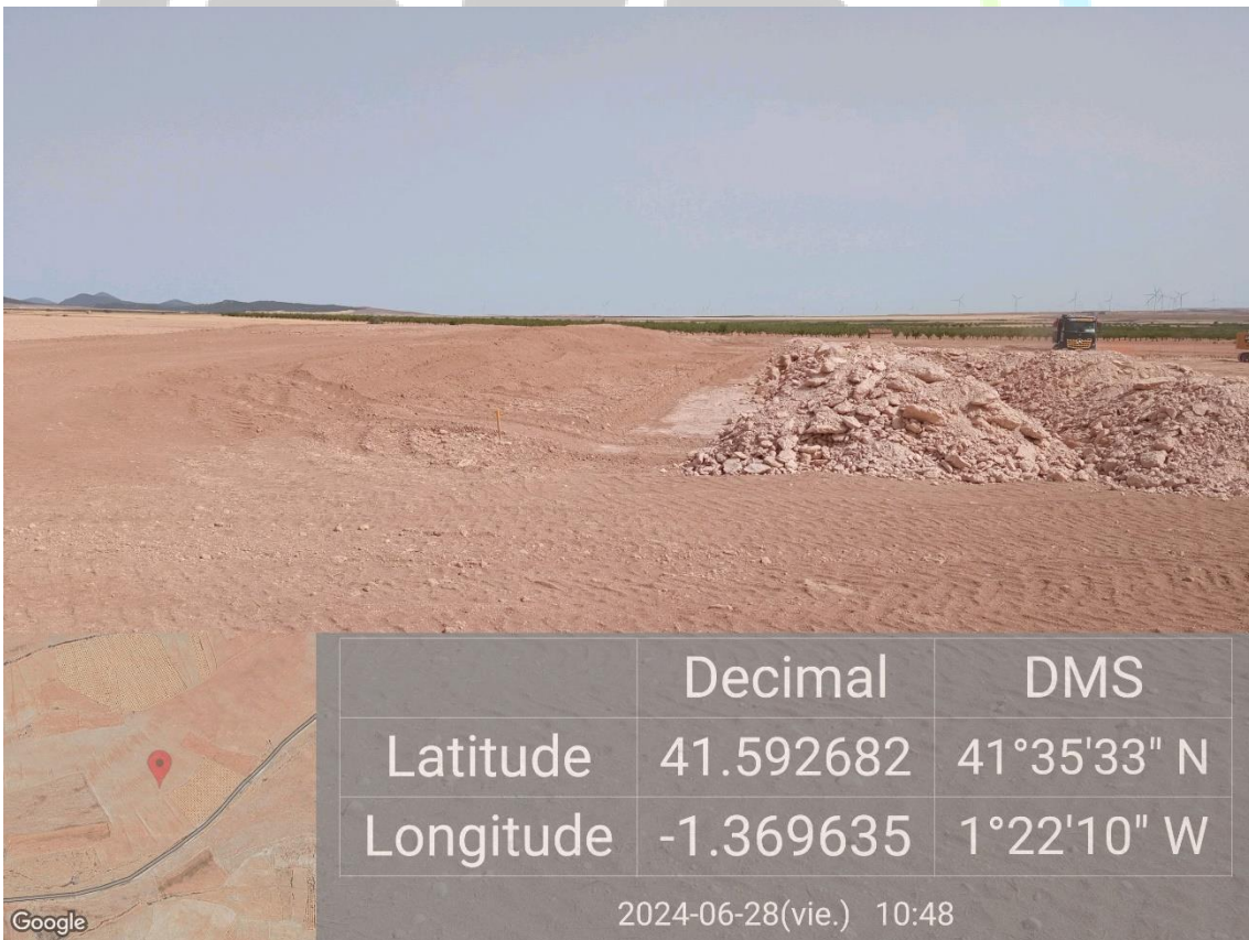
Ilustración 5. Retirada de tierra vegetal en la plataforma 1.
