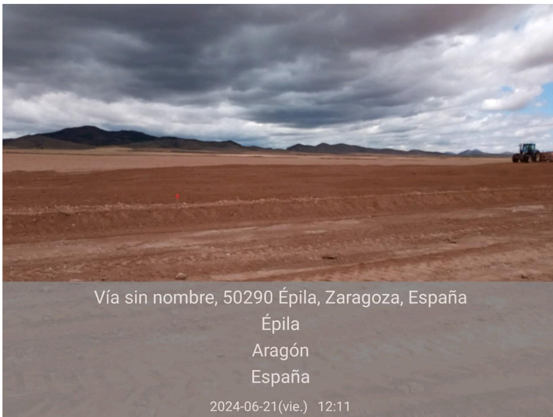
Ilustración 3. Retirada y acopio de tierra vegetal 1.
