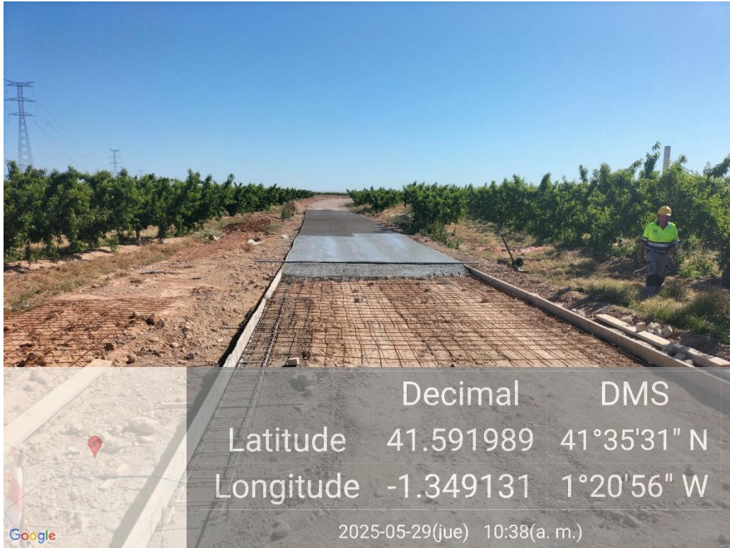
Ilustración 3. Construcción de drenaje en el vial de plataforma 01.
