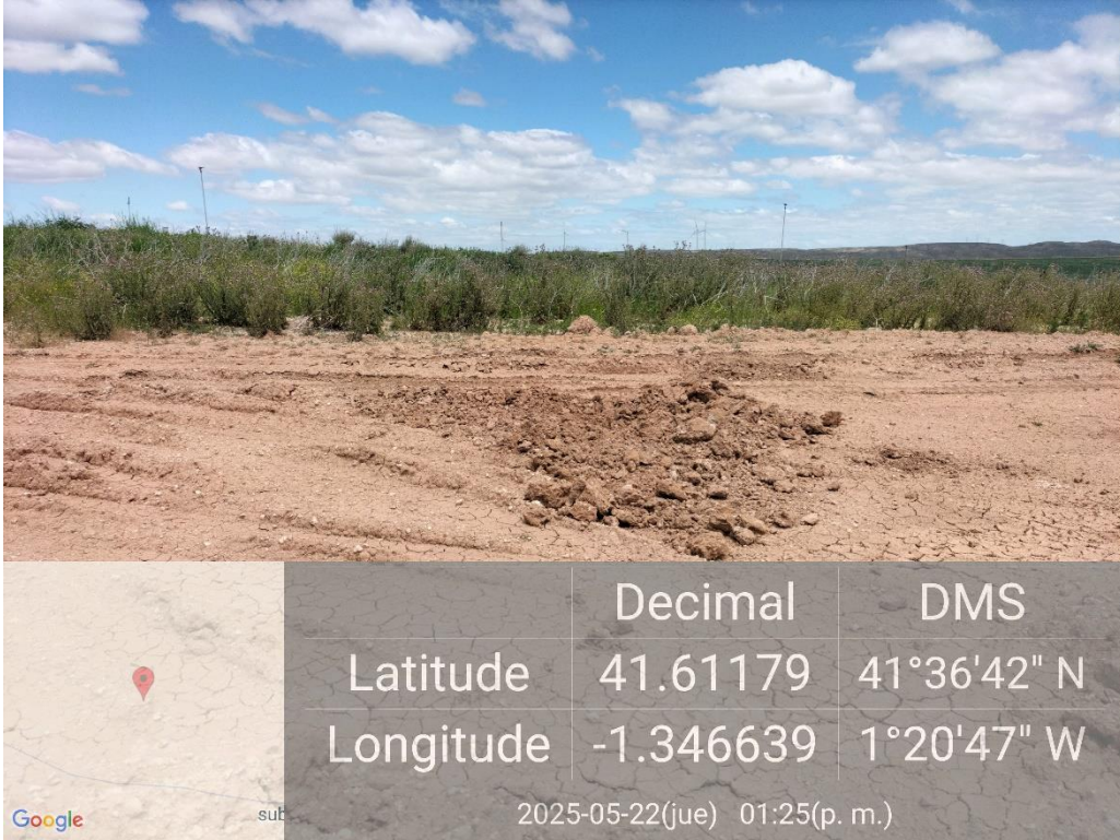
Ilustración 6. Se retiran los residuos plásticos enterrados de la plataforma 03 con fecha 22/05/2025.
