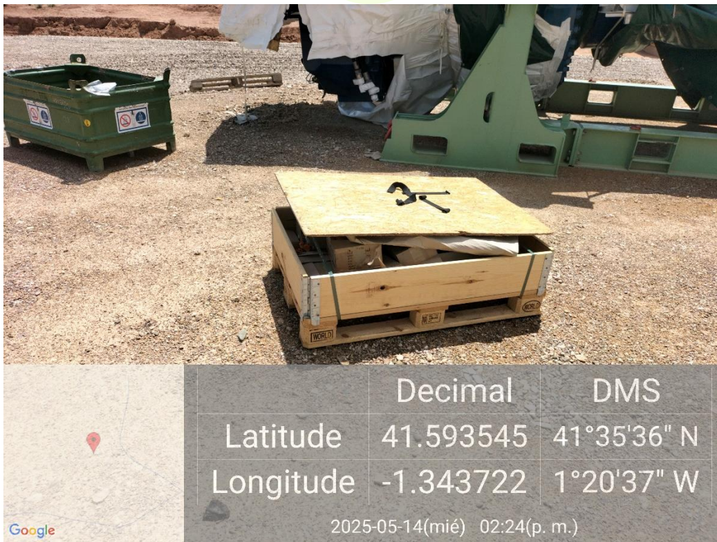
Ilustración 4. Residuos de embalaje acopiados en plataforma para facilitar su retirada y evitar su dispersión
