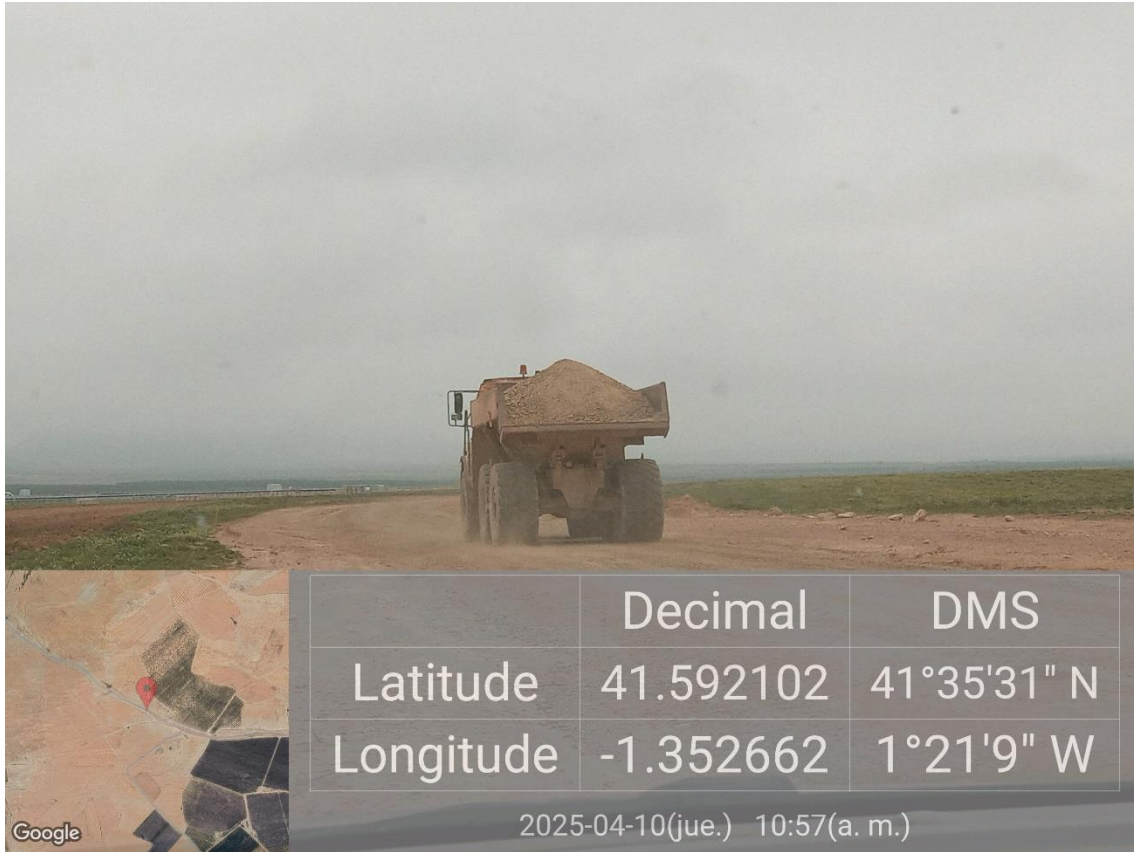
Ilustración 6. Camión transportando materiales susceptibles de generar polvo sin lona protectora.
