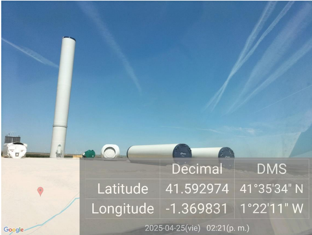
Ilustración 12. Acopio de infraestructuras sin afectar al drenaje ni a la vegetación natural
