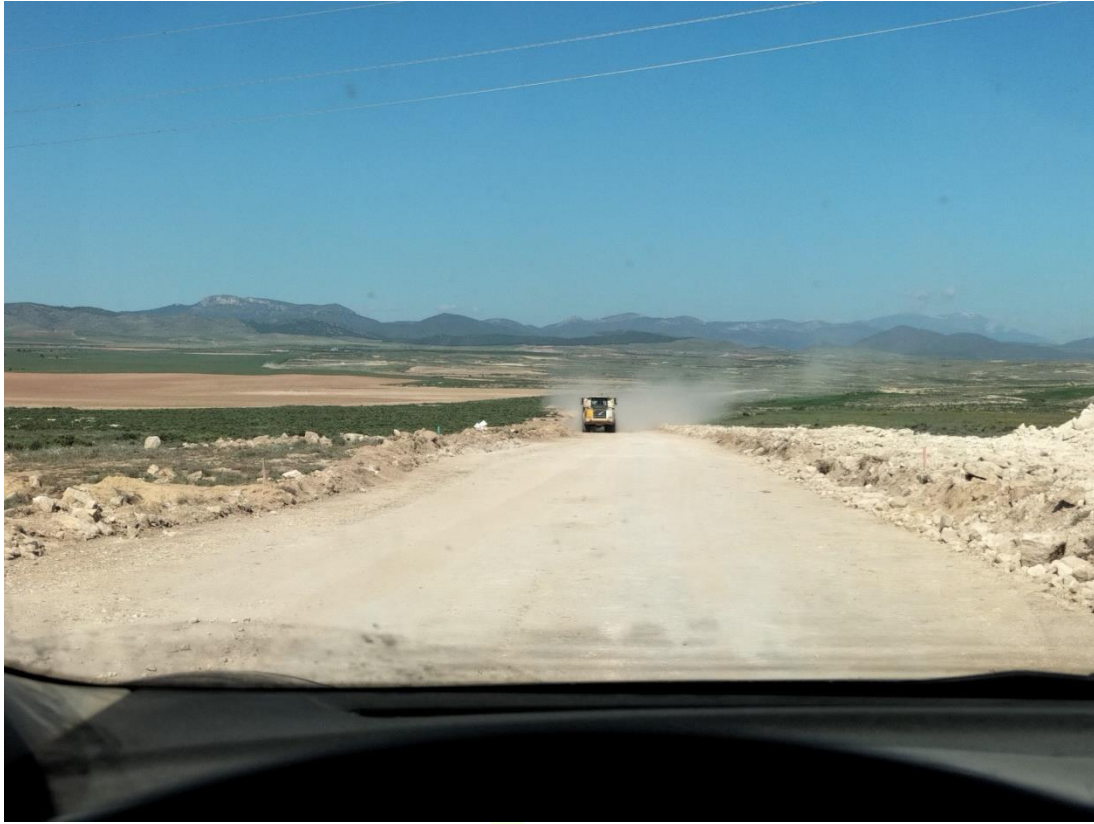
Ilustración 20. Camión levantando polvo al circular excediendo la velocidad y sin lona protectora.
