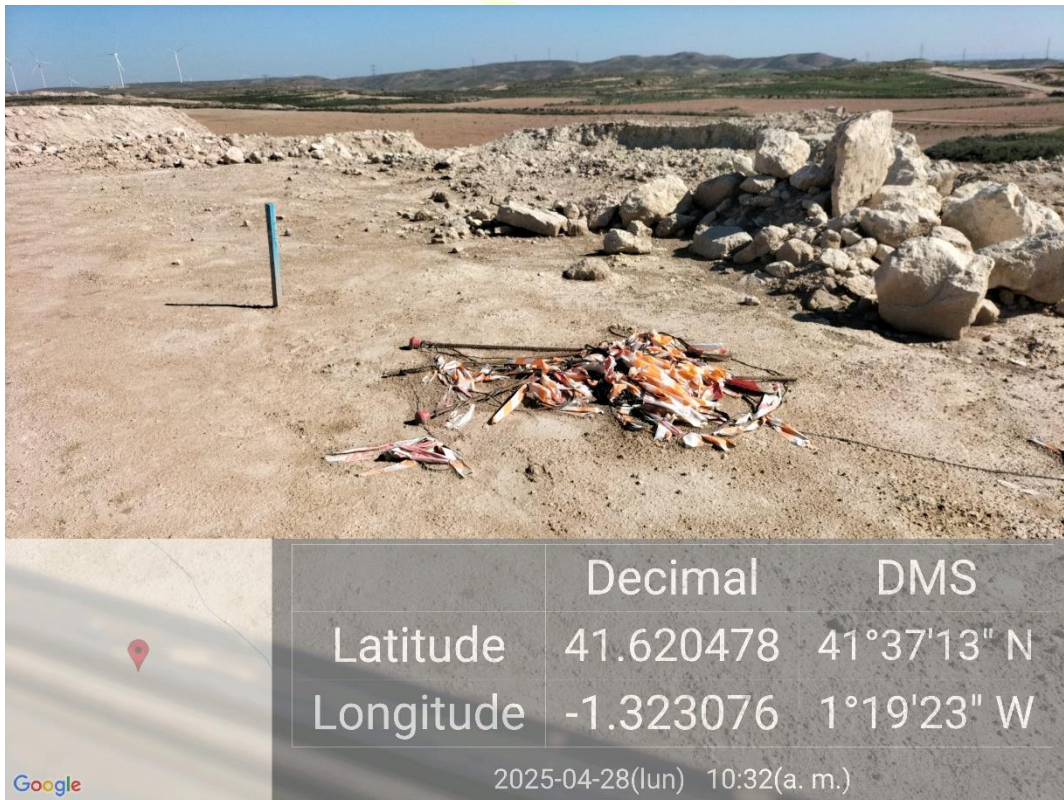
Ilustración 19. Balizado caído pendiente de retirada.
