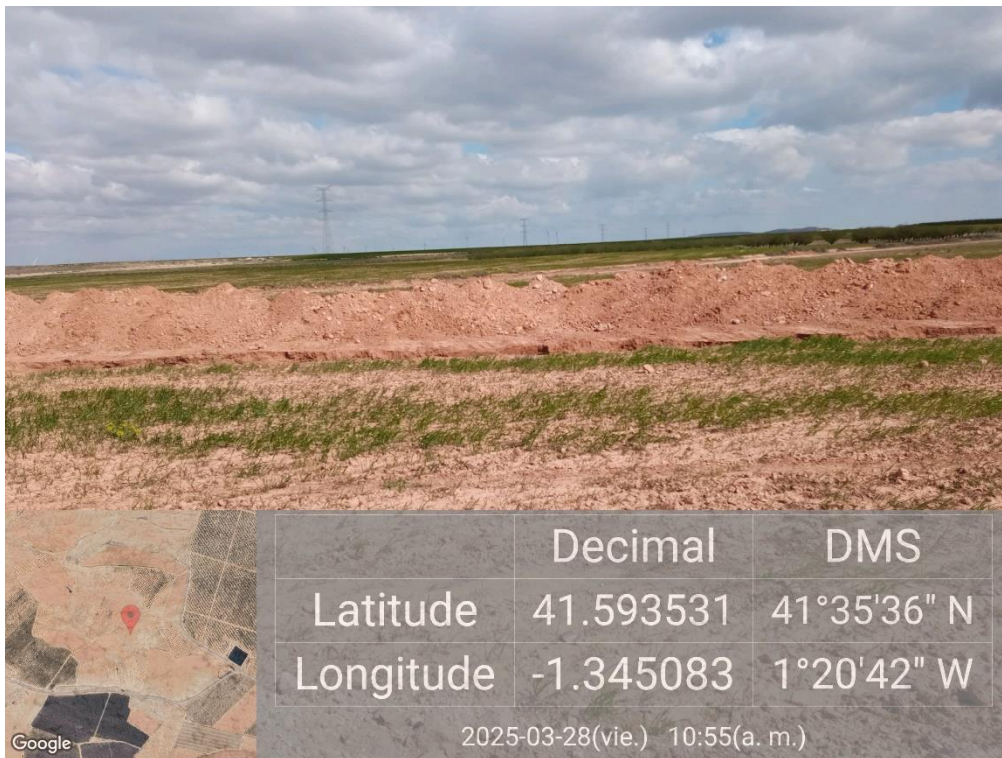
Ilustración 13. Sobrantes de excavación en zanja abierta para su posterior cierre.
