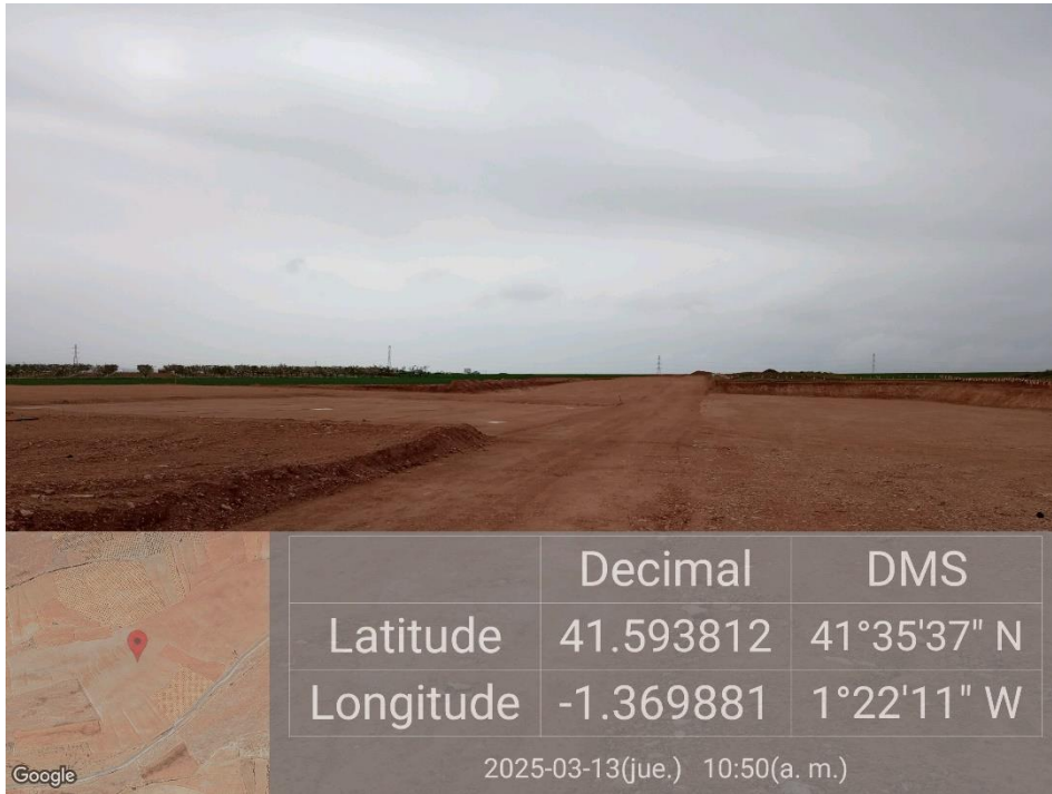
Ilustración 4. Plataforma limpia y libre de residuos
