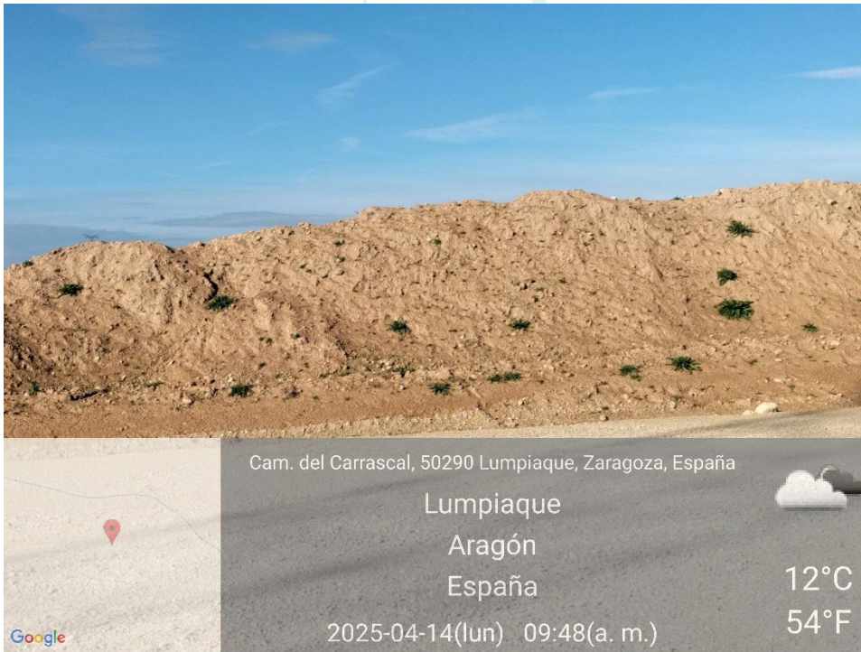
Ilustración 10. Tierra vegetal separada de materiales inertes dispuesta para su posterior gestión.
