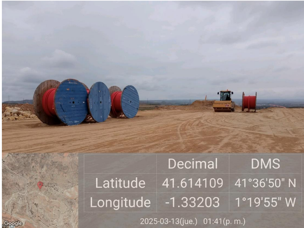
Ilustración 8. Material acopiado correctamente sin afectar a la vegetación natural
