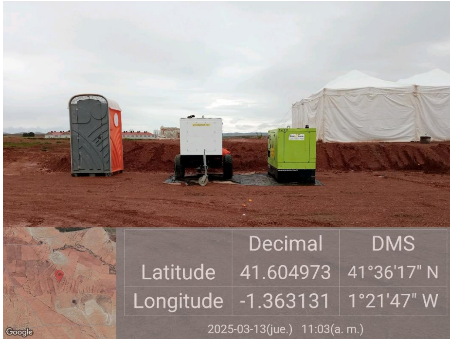
Ilustración 6. Generadores sobre lona impermeable para prevenir infiltraciones por vertidos
