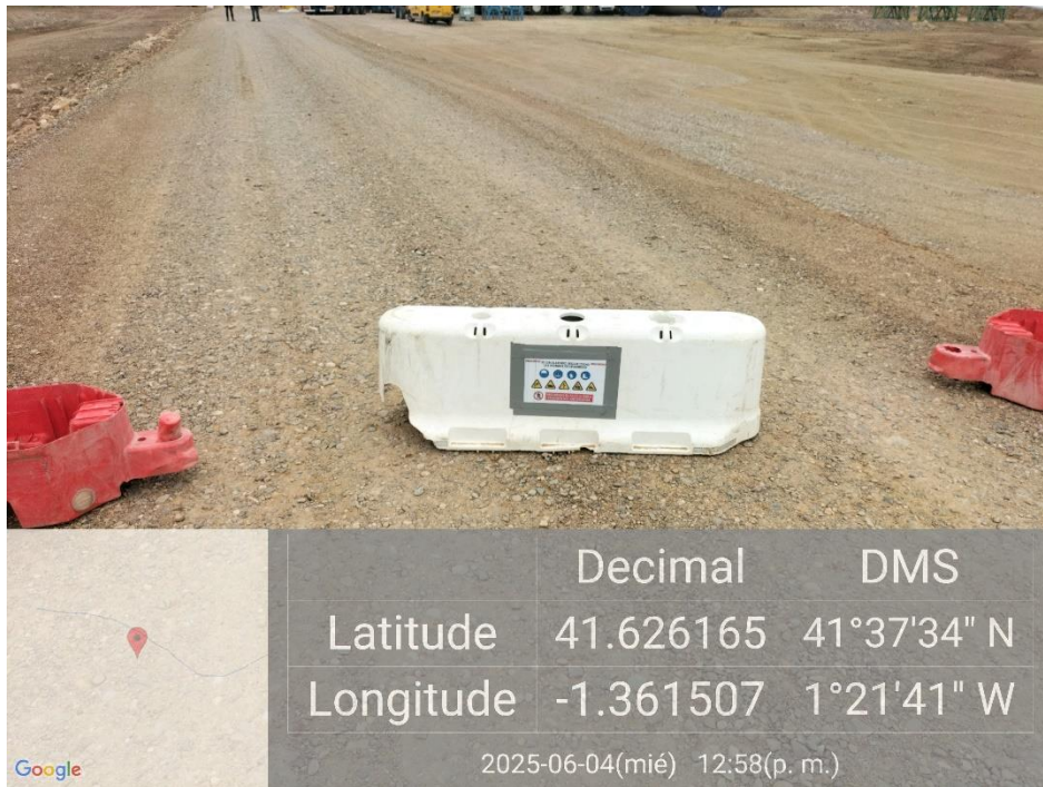
Ilustración 5. Vial cerrado por movimientos de grúas y cargas suspendidas en plataforma.
