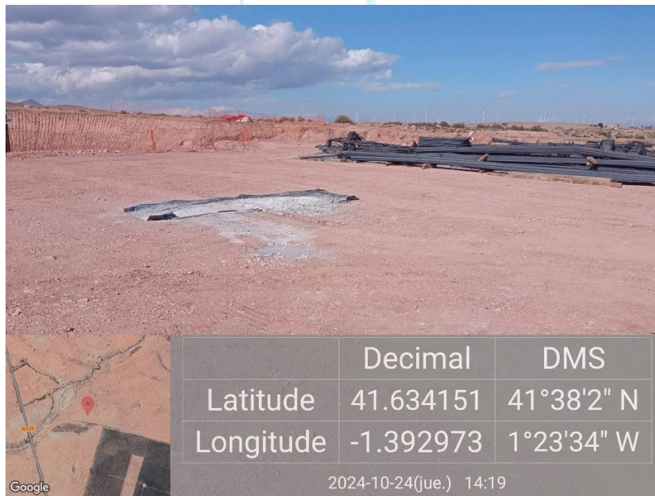
Ilustración 20. Limpieza de cuba hecha fuera de plástico aislante en la plataforma 01.
