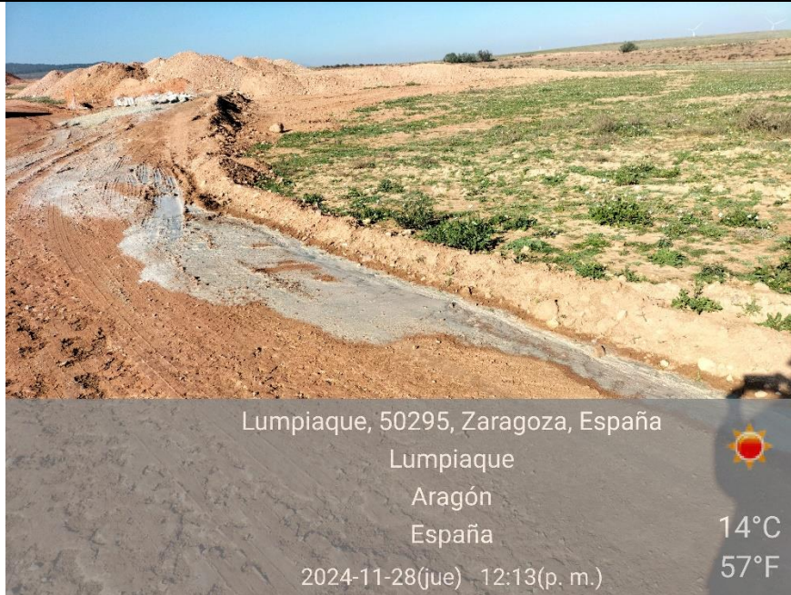
Ilustración 31. Vertido de agua de limpieza de cuba derivado de la limpieza anteriormente comentada.
