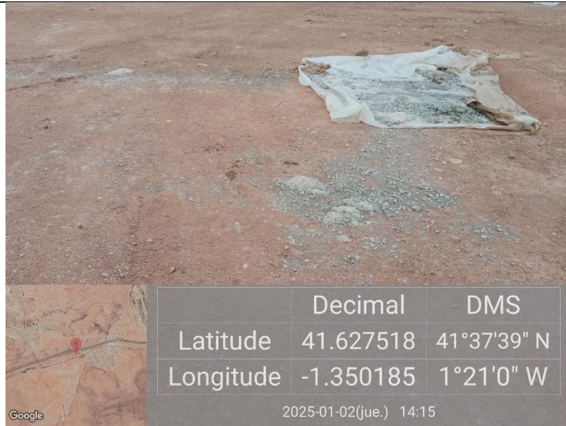
Ilustración 39. Limpieza de hormigón fuera de la balsa en la plataforma
