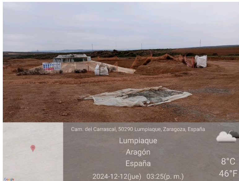
Ilustración 38. Limpieza de hormigón fuera de la balsa.
