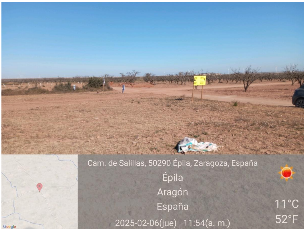
Ilustración 2. Sacos de hormigón vacíos y desperdigados por el suelo.
