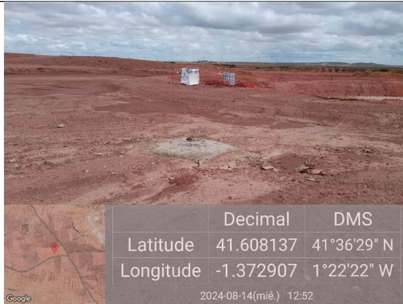
Ilustración 7. Limpieza de cuba sin plástico protector en medio de plataforma 04.
