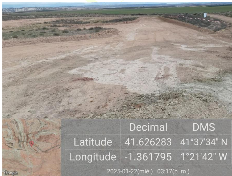
Ilustración 48. Vertido de hormigón al lado de la balsa en la plataforma 06.
