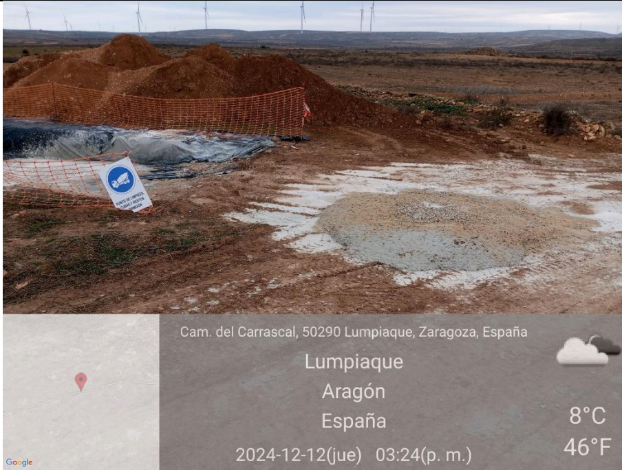
Ilustración 35. Limpieza de hormigón fuera de la balsa.
