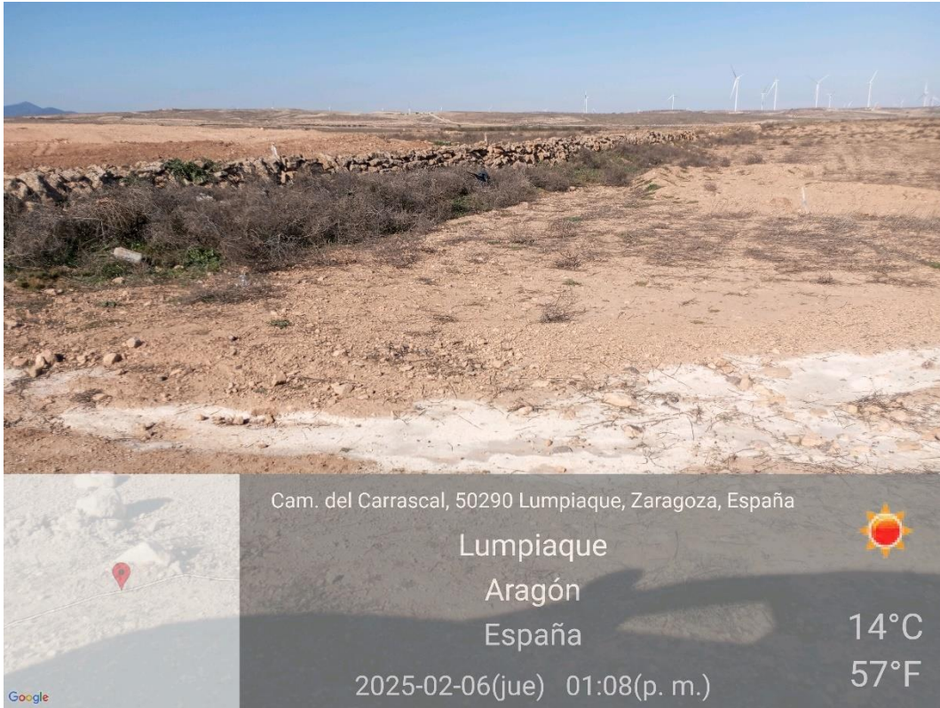
Ilustración 3. Vertido de hormigón.
