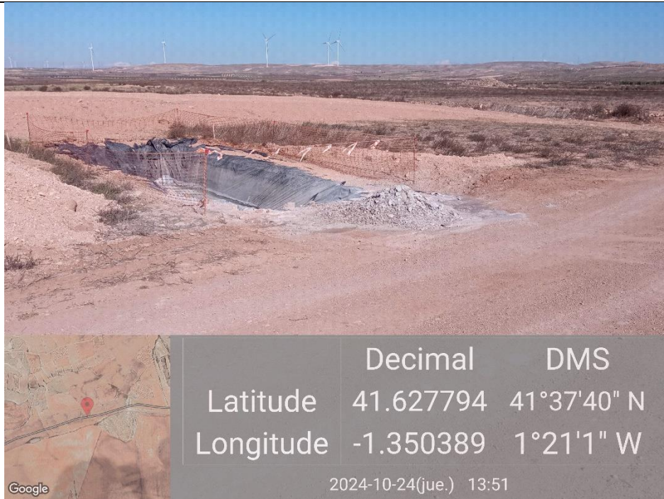
Ilustración 19. Limpieza de cuba hecha fuera de la balsa en la plataforma 08.
