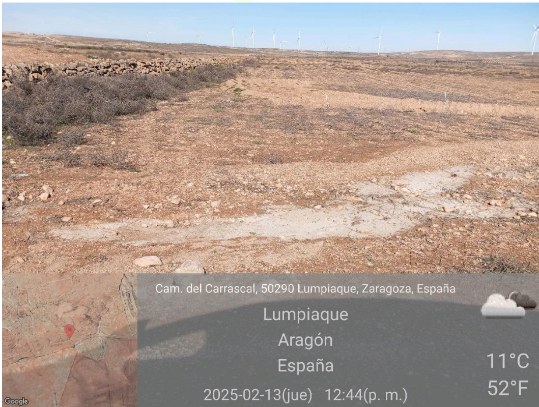
Ilustración 54. Vertido de hormigón.
