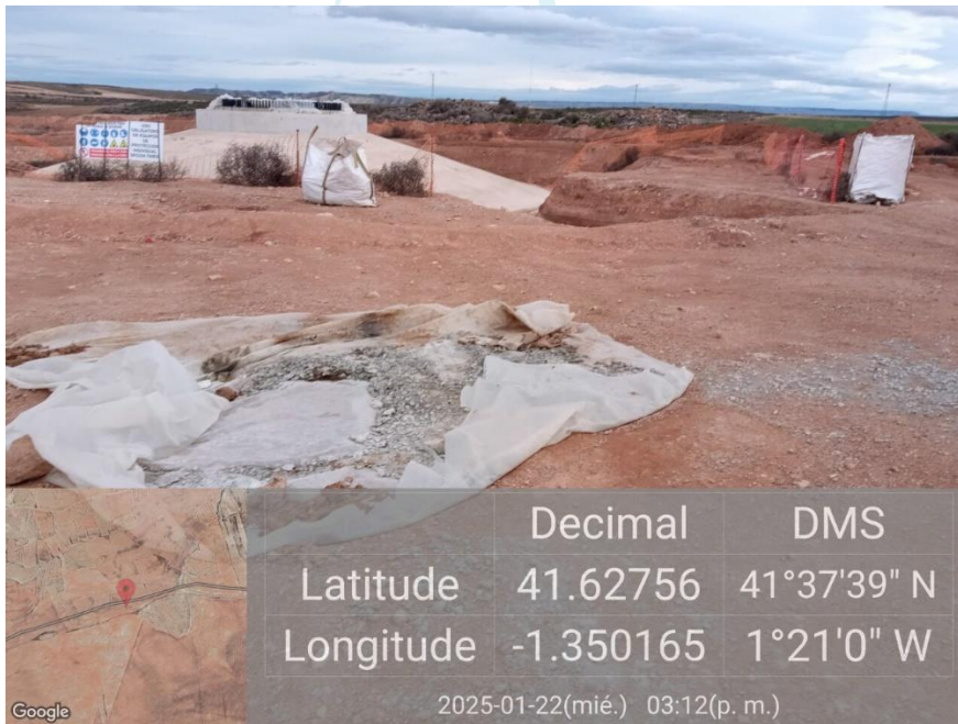
Ilustración 50. Limpiezas de hormigón fuera de la balsa en la plataforma 08.
