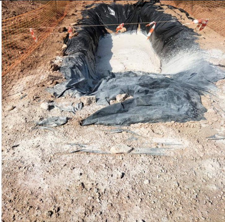
Ilustración 11. limpieza de hormigón parcialmente fuera de la balsa de la plataforma 08.
