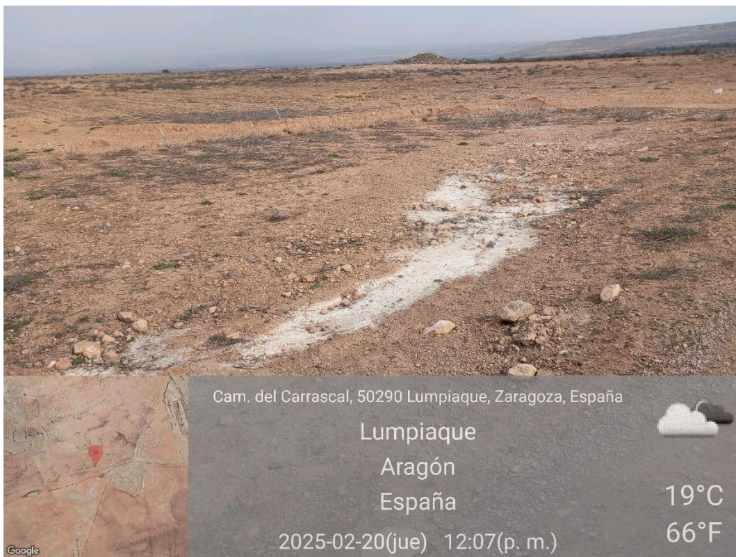
Ilustración 55. Vertido de hormigón.
