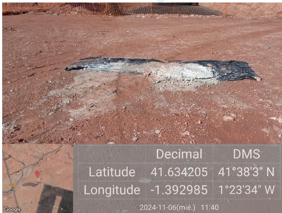
Ilustración 22. Continúa limpieza fuera de plástico aislante sin corregir en la plataforma 01.
