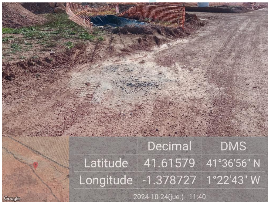
Ilustración 18. Limpieza de hormigón hecha fuera de la balsa en la plataforma 05 todavía sin corregir.
