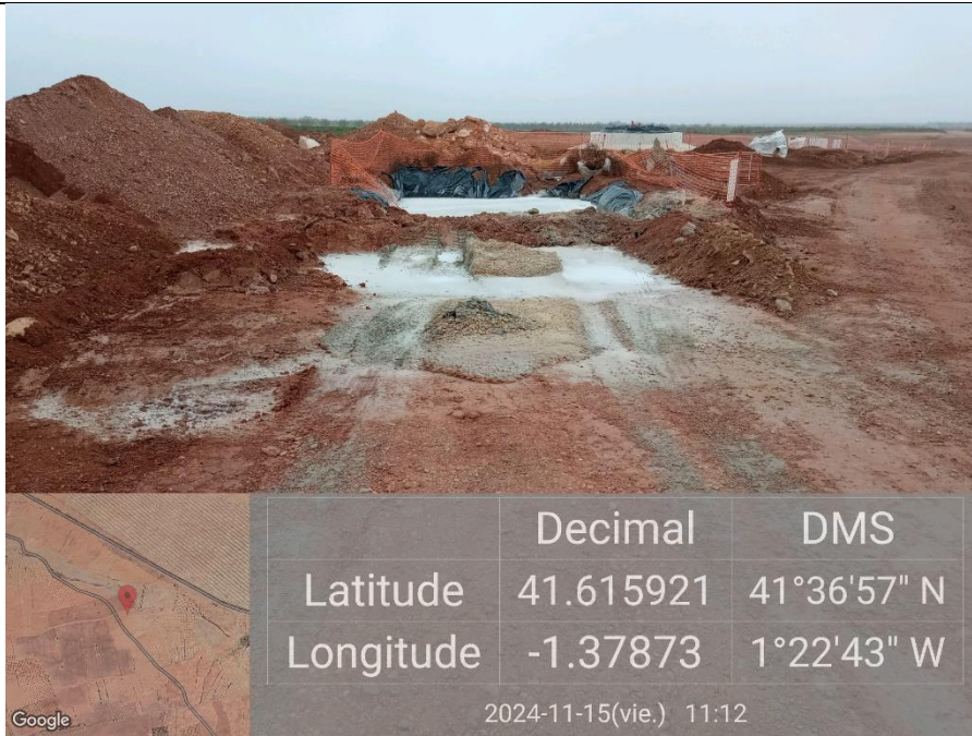
Ilustración 25. Limpieza de hormigón realizada totalmente fuera de la balsa de la plataforma 05.
