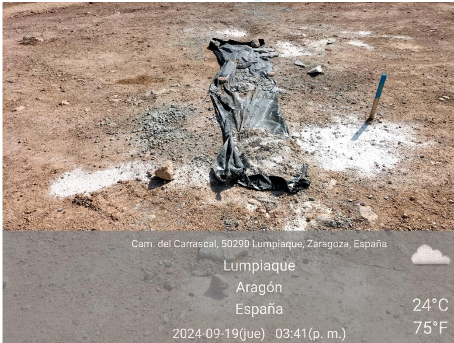
Ilustración 12. Limpieza de hormigón fuera de plástico protector en plataforma 08.
