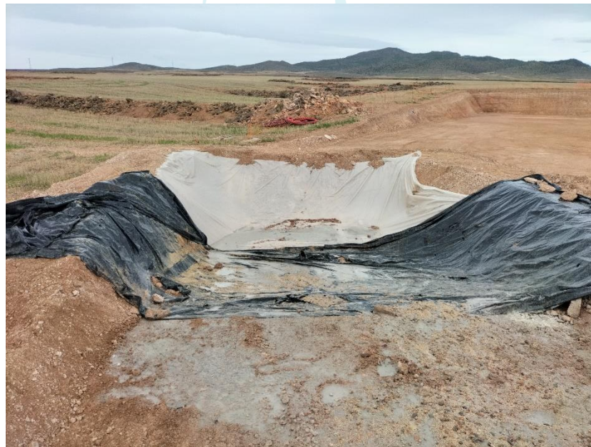
Ilustración 14. Limpieza de cuba de hormigón hecha fuera de la zona aislada de la balsa de la plataforma 03.
