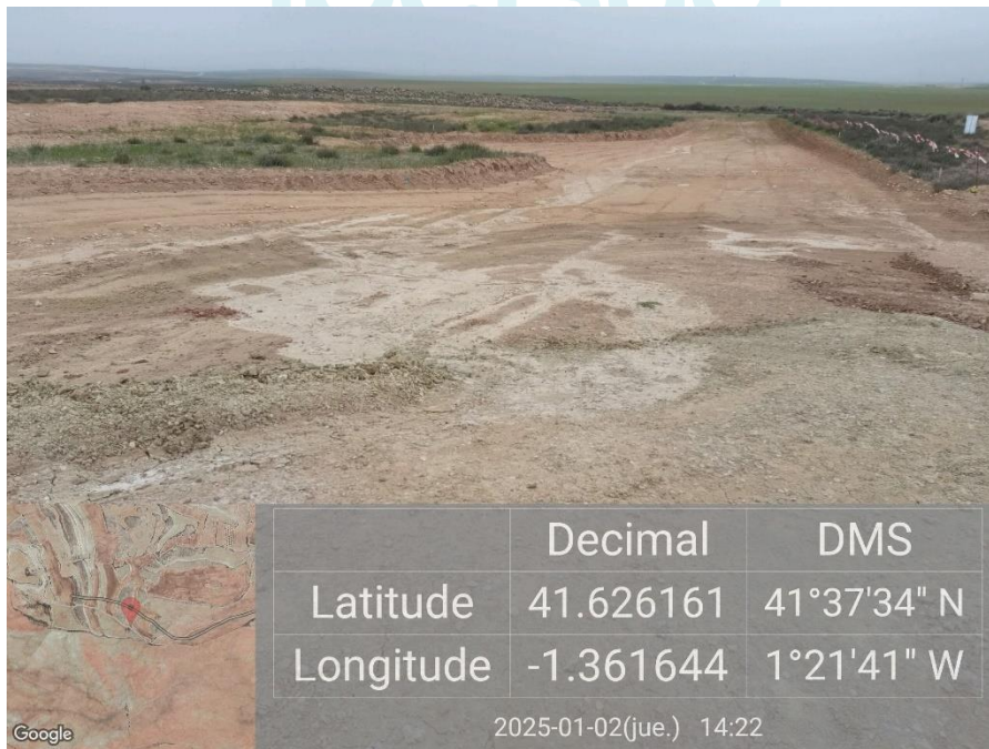
Ilustración 2. Vertido de hormigón en la plataforma 06.
