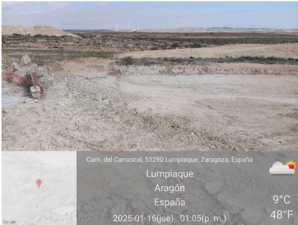
Ilustración 12. Vertido de hormigón en la plataforma 06.
