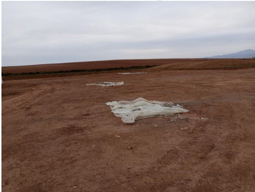
Ilustración 46. Limpiezas de hormigón fuera de las balsas.
