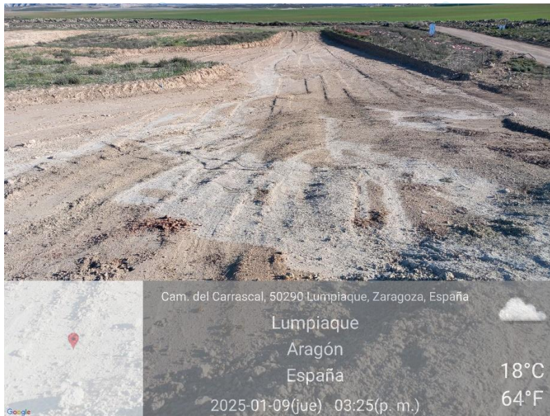
Ilustración 5. Vertido de hormigón en la plataforma 06.
