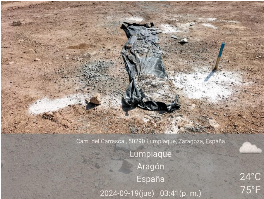
Ilustración 22. Limpieza de hormigón fuera de plástico protector en plataforma 08.
