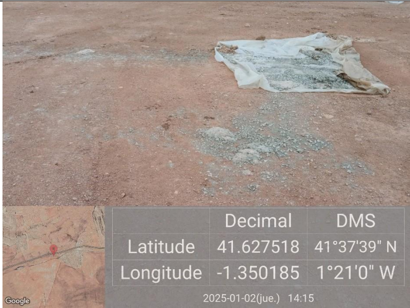
Ilustración 49. Limpieza de hormigón fuera de la balsa en la plataforma 08.
