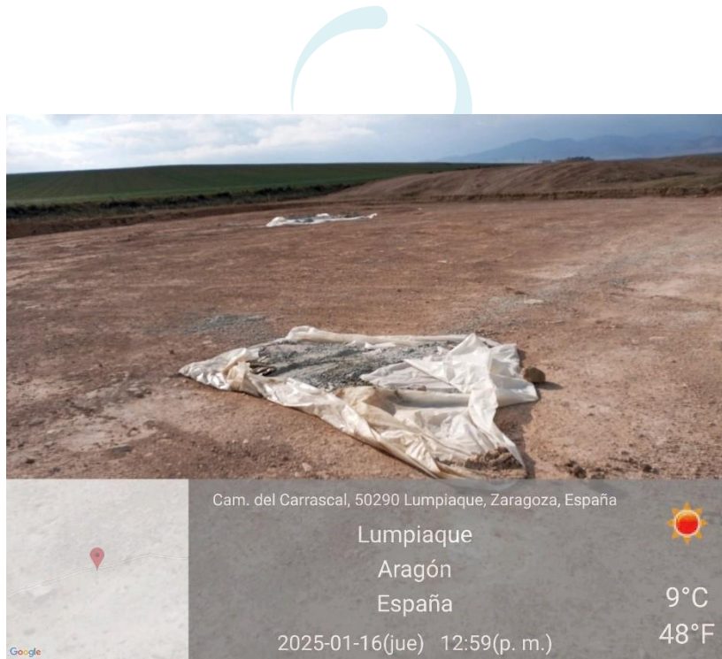
Ilustración 56. Limpiezas de hormigón fuera de la balsa.
