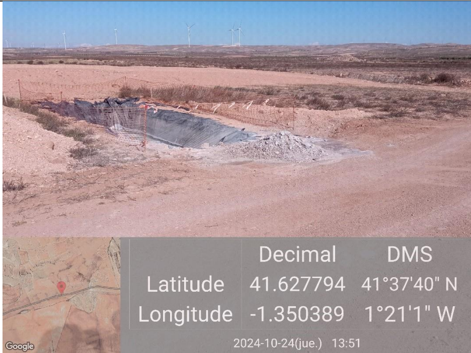
Ilustración 29. Limpieza de cuba hecha fuera de la balsa en la plataforma 08.
