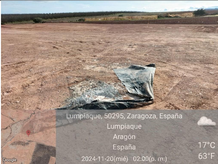
Ilustración 39. Nuevamente limpieza hecha fuera de plástico sin corregir.
