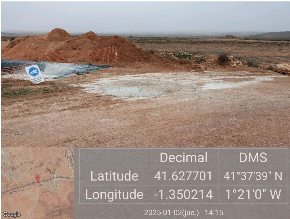
Ilustración 3. Vertido de hormigón en la plataforma 08.
