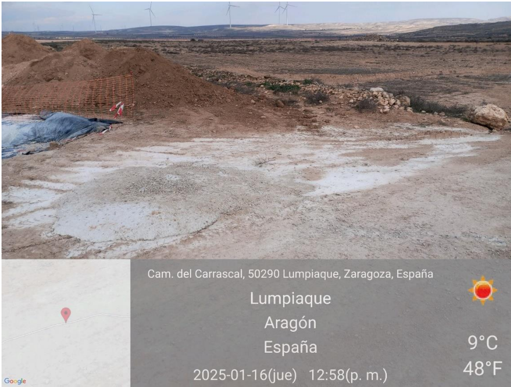
Ilustración 11. Vertido de hormigón en la plataforma 08.
