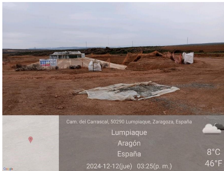
Ilustración 48. Limpieza de hormigón fuera de la balsa.
