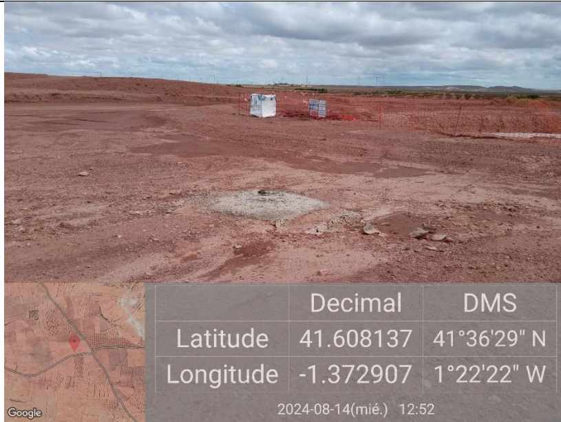
Ilustración 17. Limpieza de cuba sin plástico protector en medio de plataforma 04.
