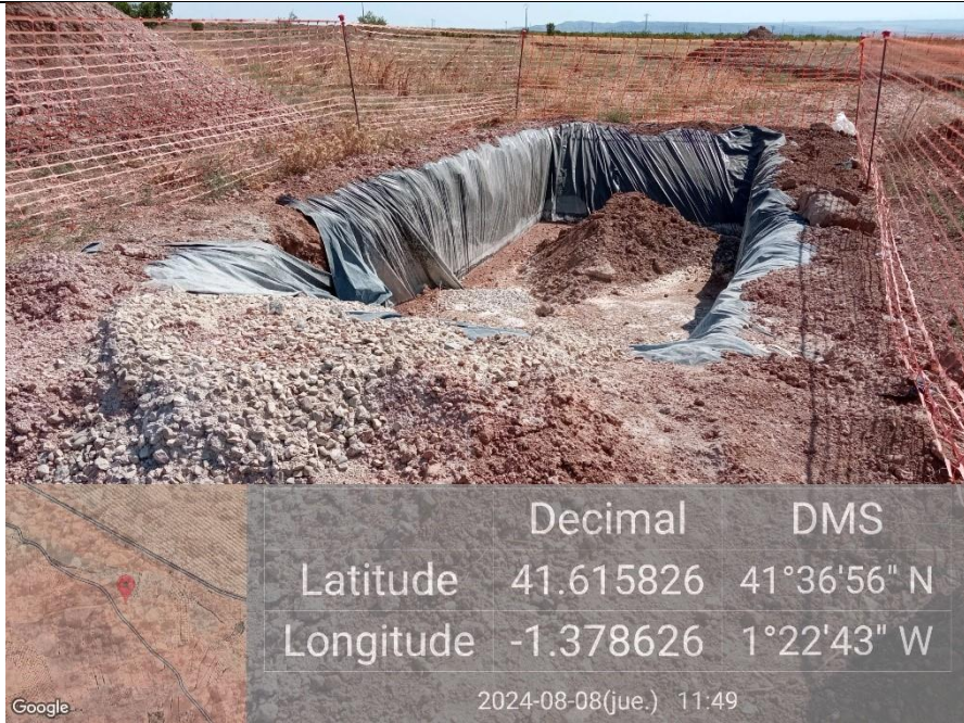
Ilustración 15. Limpieza de cubas parcialmente fuera de la balsa en la plataforma 05.
