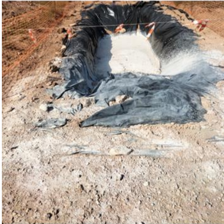
Ilustración 21. limpieza de hormigón parcialmente fuera de la balsa de la plataforma 08.
