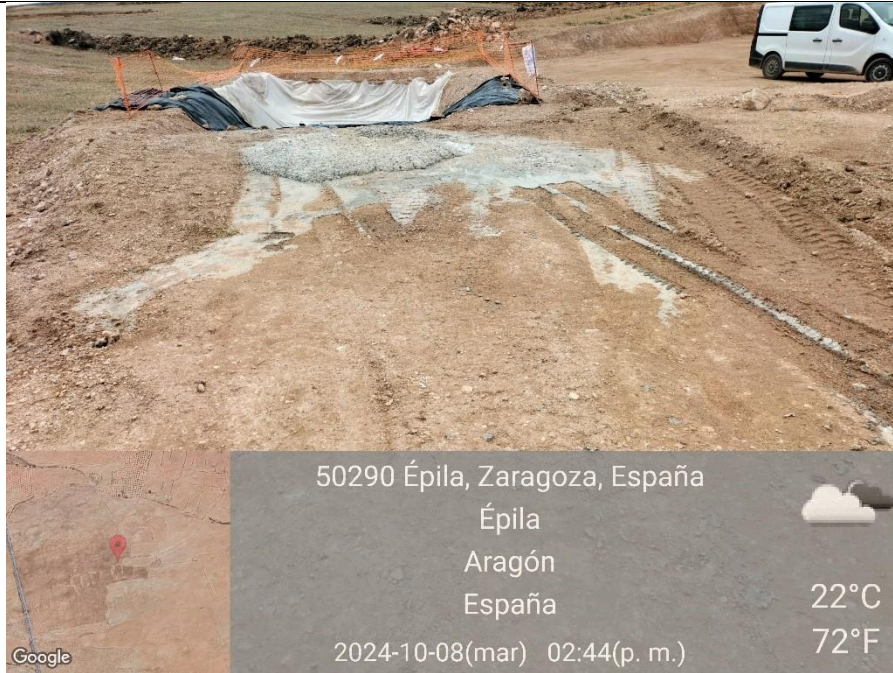
Ilustración 25. Nuevamente limpieza de cuba hecha fuera de la balsa de la plataforma 03.
