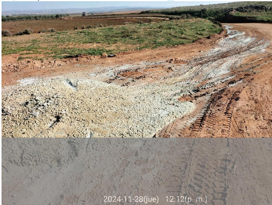
Ilustración 40. Limpieza de hormigón realizada fuera de la balsa de la plataforma 01.
