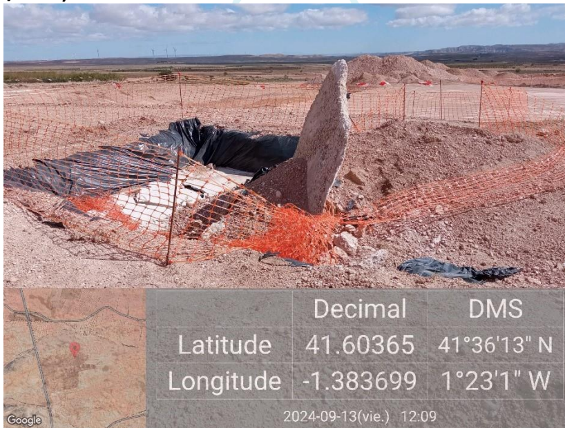
Ilustración 18. Balsa de plataforma 03 en mal estado.
