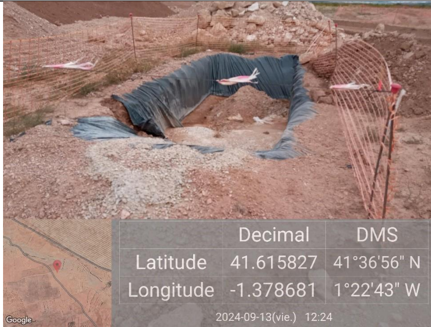
Ilustración 19. Balsa de la plataforma 05 sin ser corregida.
