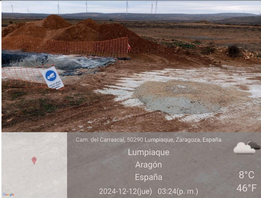
Ilustración 45. Limpieza de hormigón fuera de la balsa.
