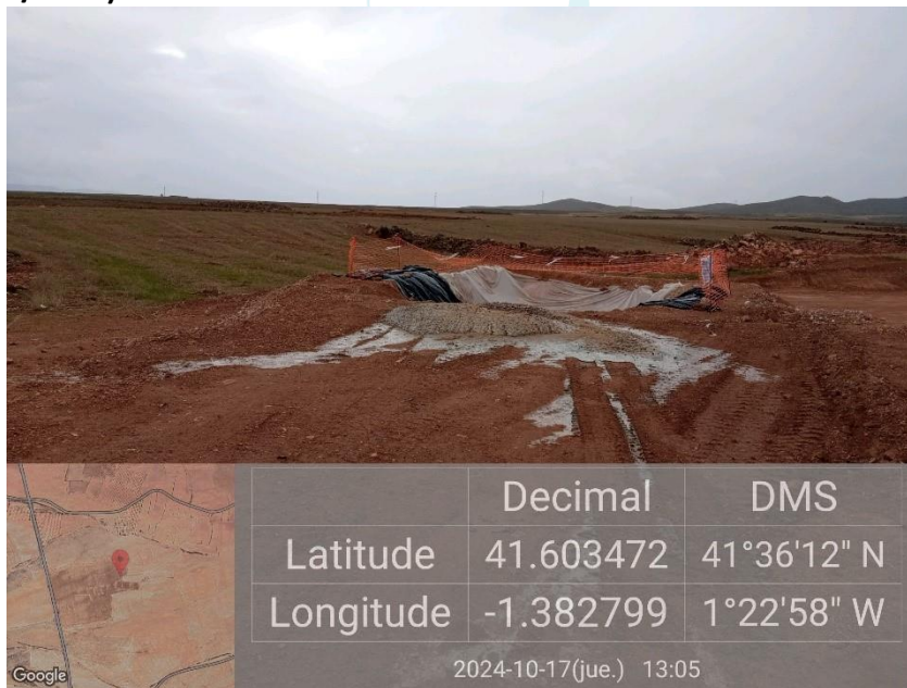
Ilustración 26. Continúa sin gestionar los restos de la limpieza de cuba hecha fuera de la balsa de la plataforma 03 realizada en las visitas anteriores.
