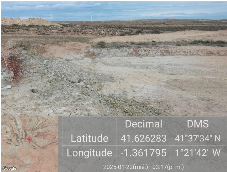
Ilustración 61. Vertido de hormigón en la plataforma 06.
