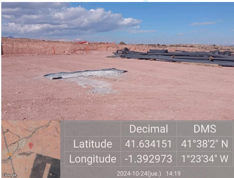
Ilustración 30. Limpieza de cuba hecha fuera de plástico aislante en la plataforma 01.
