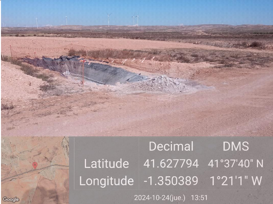
Ilustración 26. Limpieza de cuba hecha fuera de la balsa en la plataforma 08.
