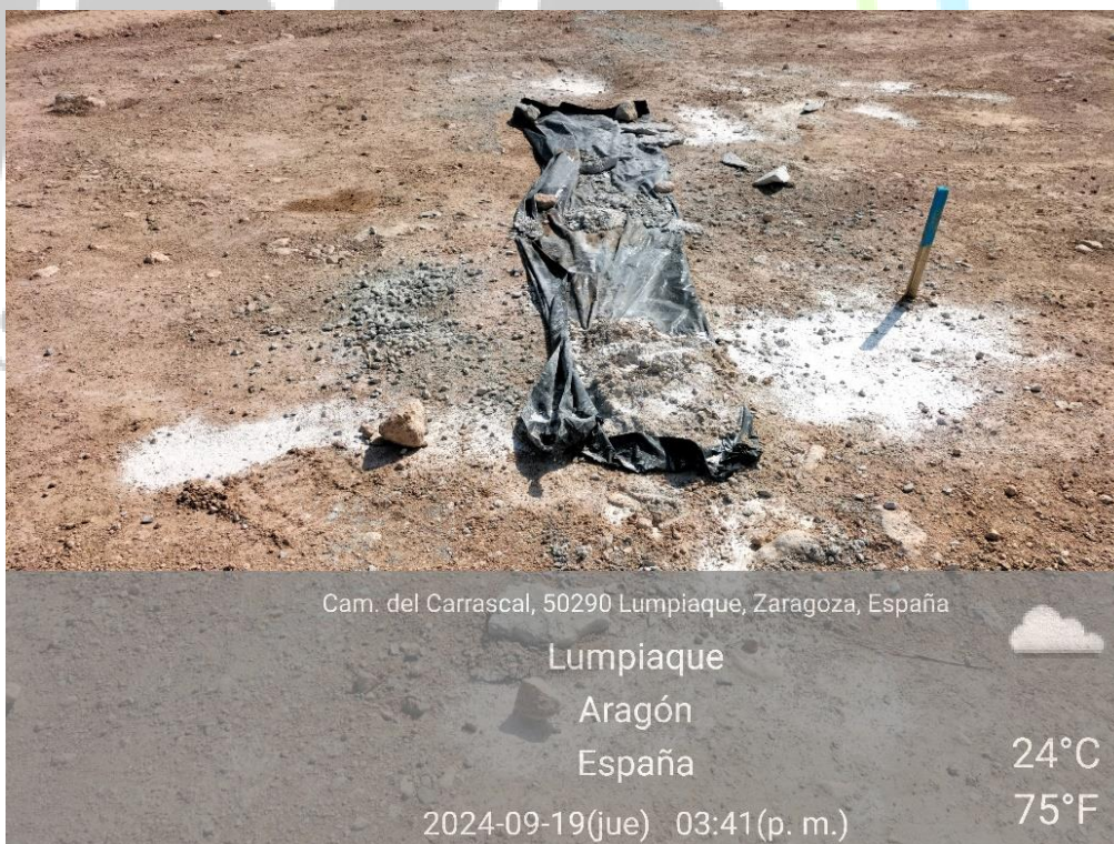
Ilustración 19. Limpieza de hormigón fuera de plástico protector en plataforma 08.
