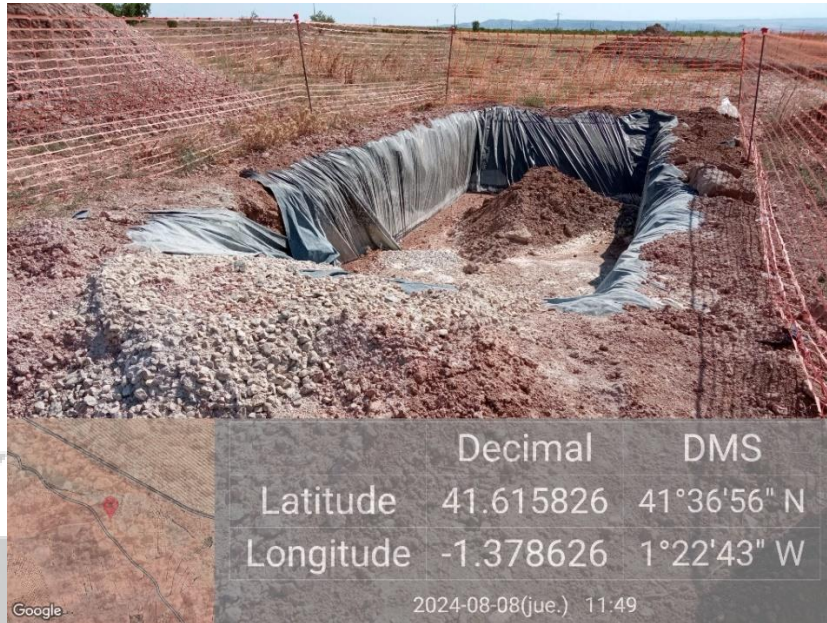
Ilustración 12. Limpieza de cubas parcialmente fuera de la balsa en la plataforma 05.
