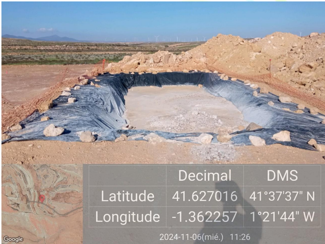
Ilustración 2. Balsa de hormigón de la plataforma 06.
