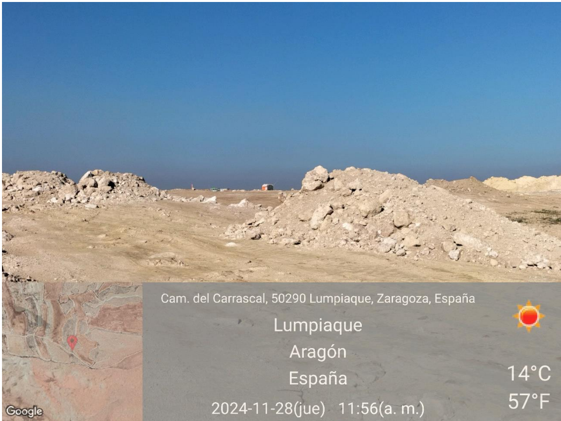
Ilustración 11. Acopio de tierras sobrantes en la plataforma 06.
