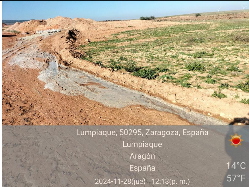
Ilustración 38. Vertido de agua de limpieza de cuba derivado de la limpieza anteriormente comentada.
