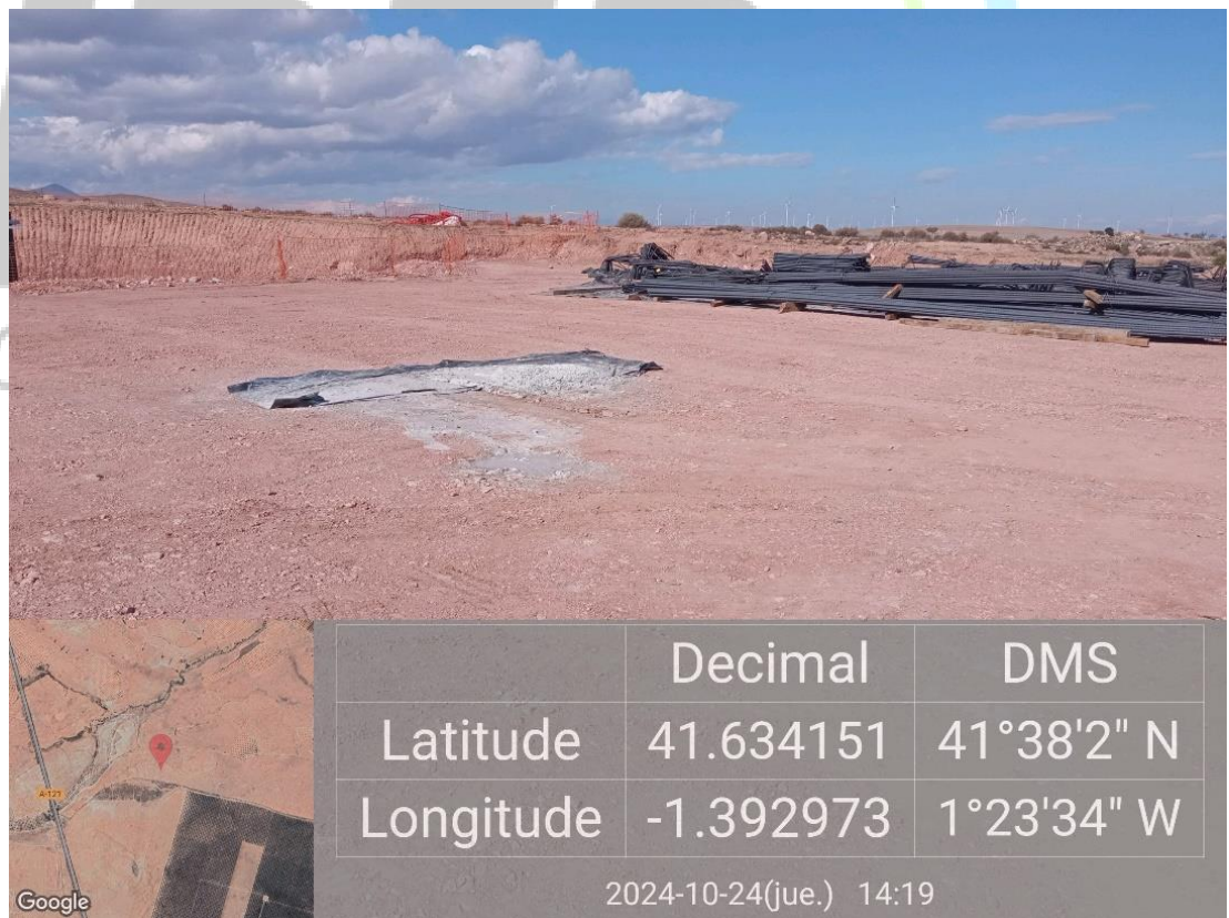
Ilustración 27. Limpieza de cuba hecha fuera de plástico aislante en la plataforma 01.
