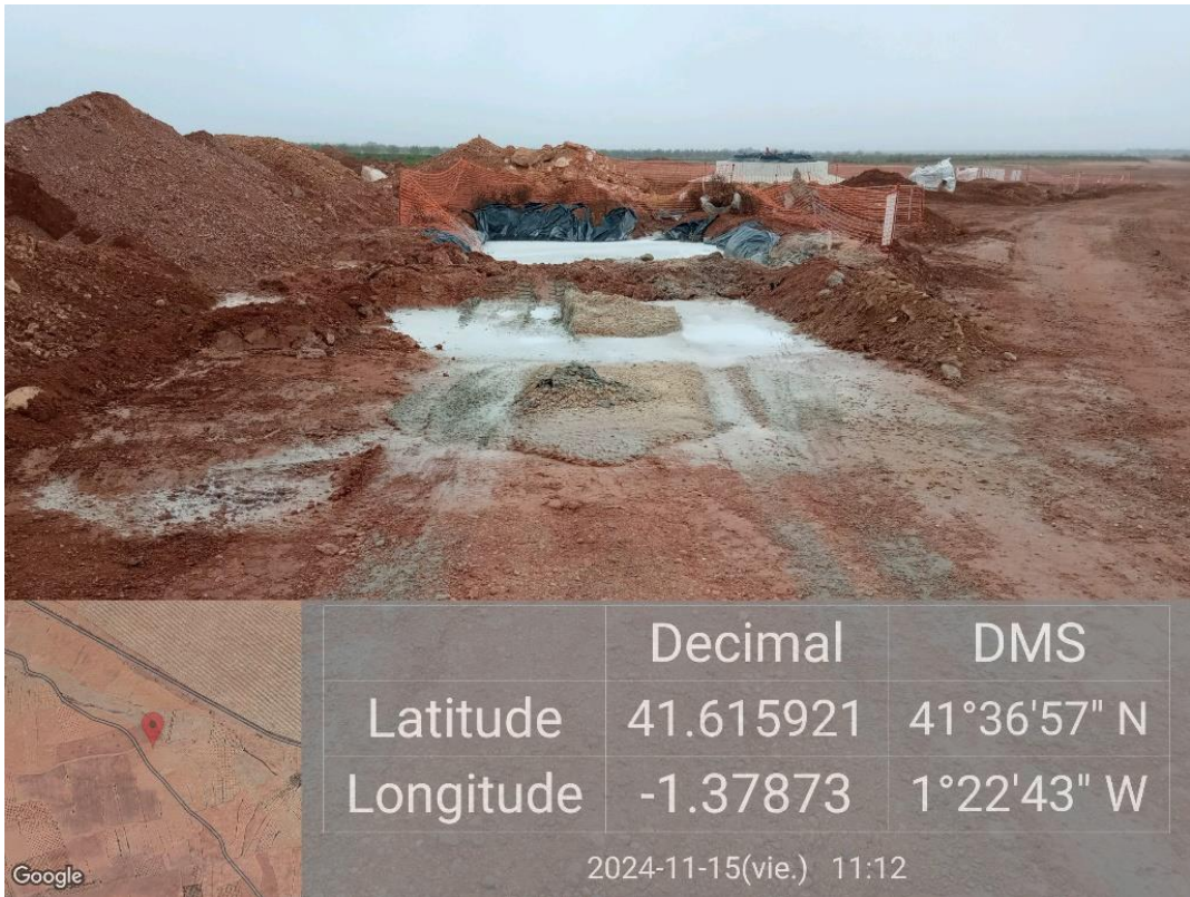
Ilustración 32. Limpieza de hormigón realizada totalmente fuera de la balsa de la plataforma 05.
