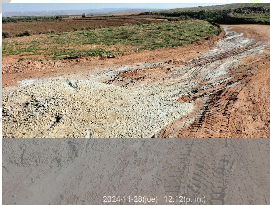
Ilustración 37. Limpieza de hormigón realizada fuera de la balsa de la plataforma 01.
