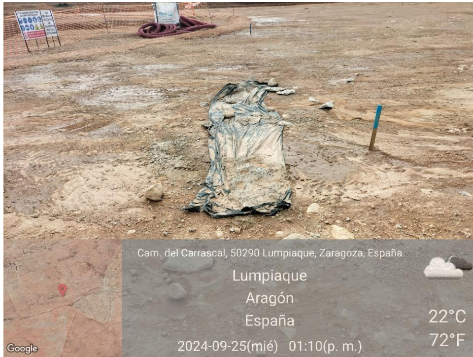
Ilustración 20. Limpieza de hormigón fuera de plástico protector en plataforma 08 de la visita anterior sin recoger.
