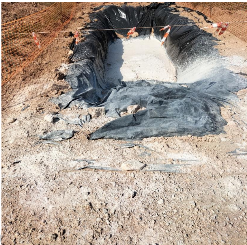
Ilustración 18. limpieza de hormigón parcialmente fuera de la balsa de la plataforma 08.
