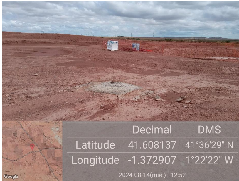
Ilustración 14. Limpieza de cuba sin plástico protector en medio de plataforma 04.
