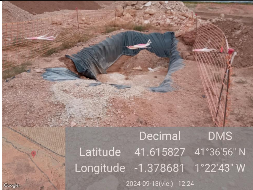
Ilustración 16. Balsa de la plataforma 05 sin ser corregida
