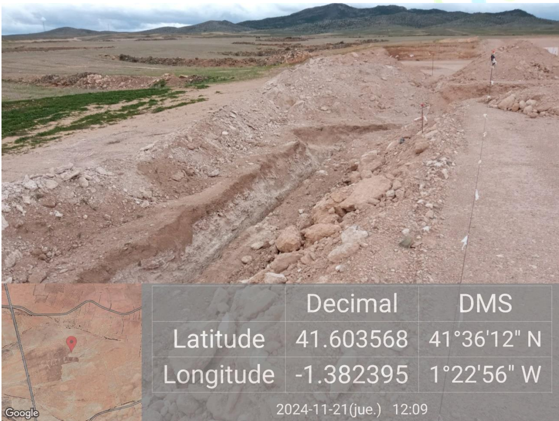
Ilustración 9. Apertura de zanja en la plataforma 03.
