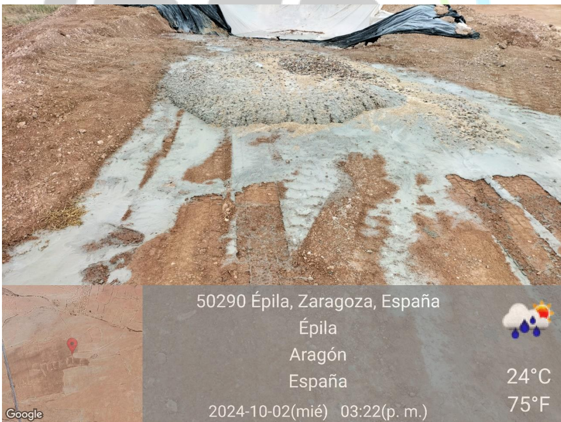
Ilustración 3. Balsa de hormigón con restos fuera de la plataforma 03.
