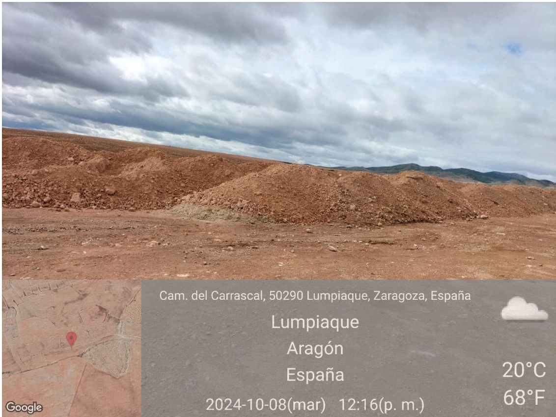
Ilustración 5. Acopio de sobrantes de excavación de la plataforma 08.
