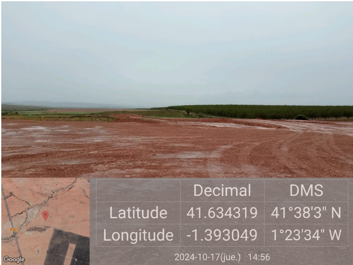
Ilustración 7. Compensación de tierras para la plataforma 01.
