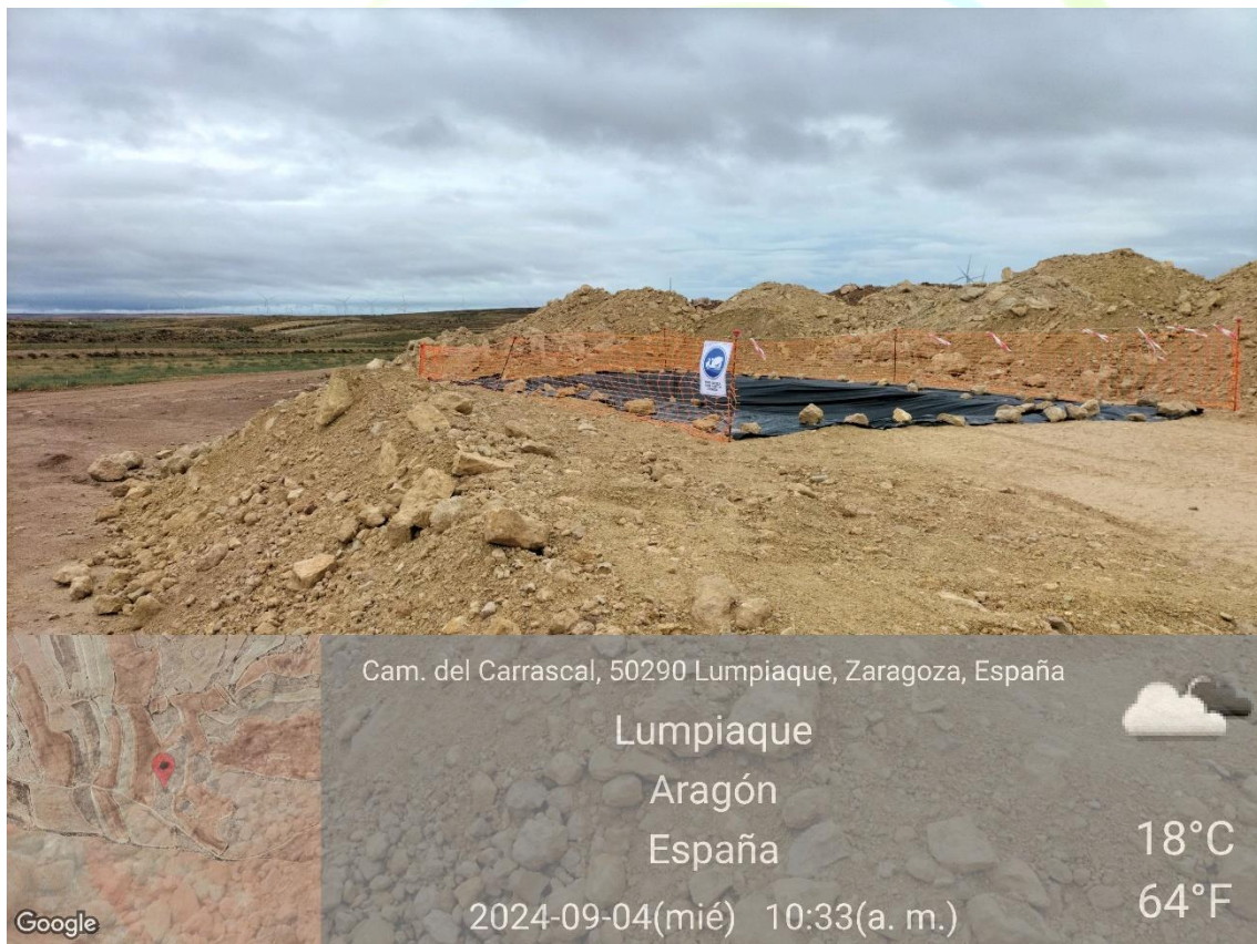
Ilustración 2. Balsa para la limpieza de hormigón de la plataforma 06.
