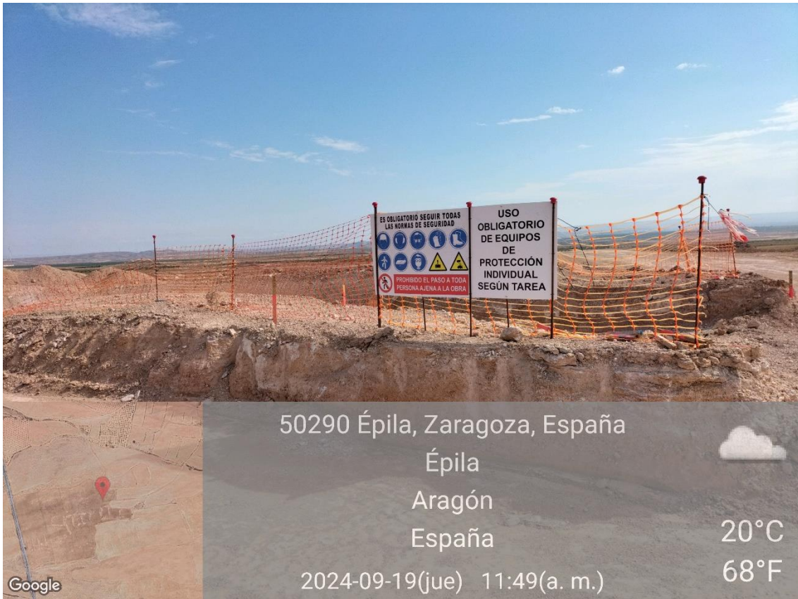
Ilustración 7. Correcta señalización de obras en la plataforma 03.
