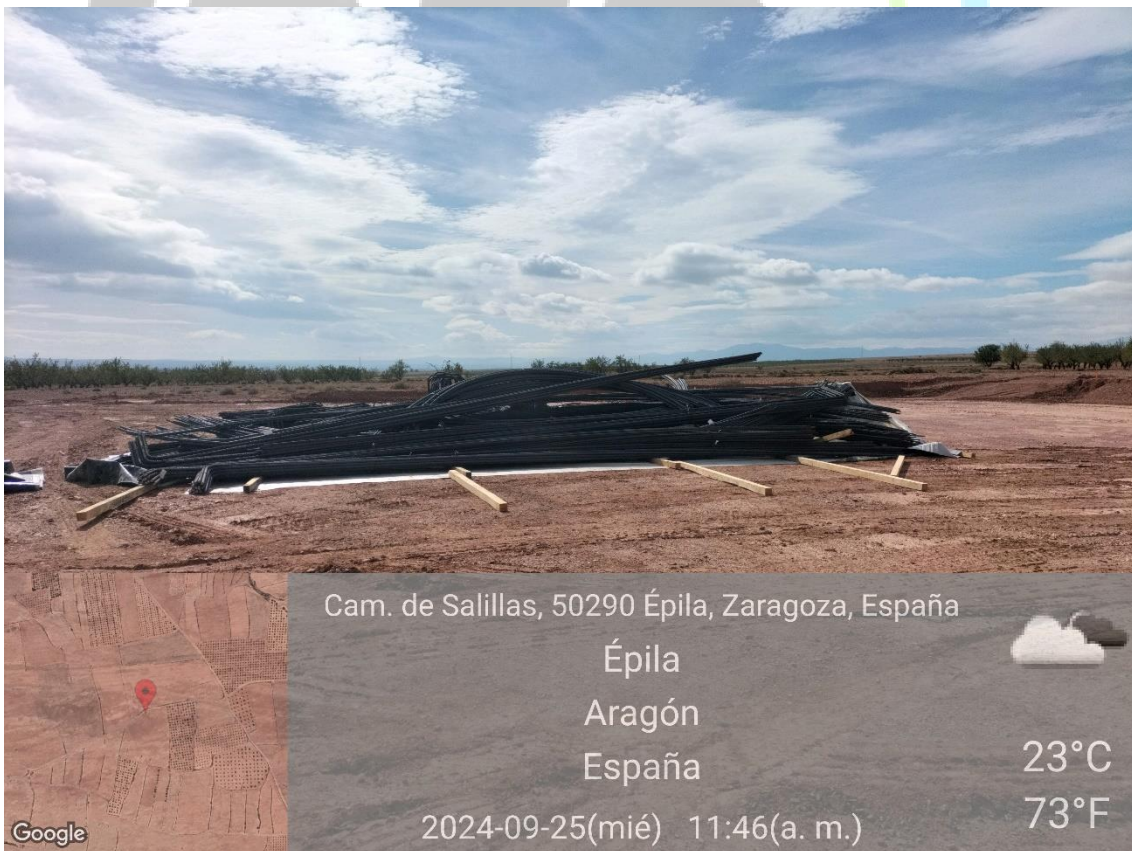
Ilustración 9. Material de ingeniería acopiado correctamente en la plataforma 04.
