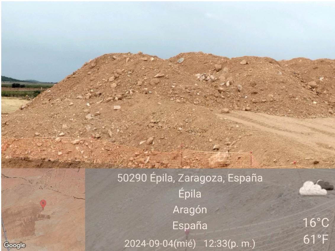
Ilustración 3. Sobrantes de excavación acopiados correctamente en la plataforma 03.
