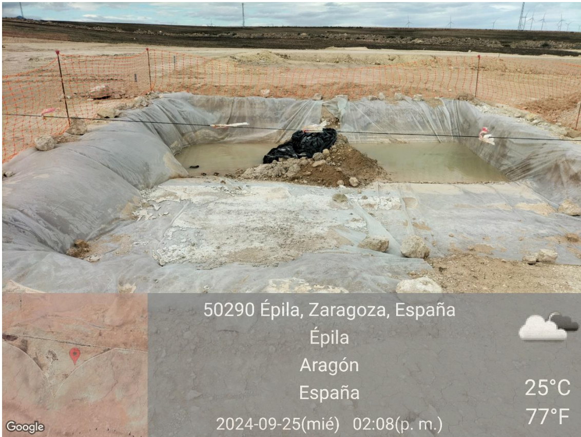
Ilustración 8. Balsa con todos los restos de hormigón correctamente en la plataforma 07, irregularidad corregida.
