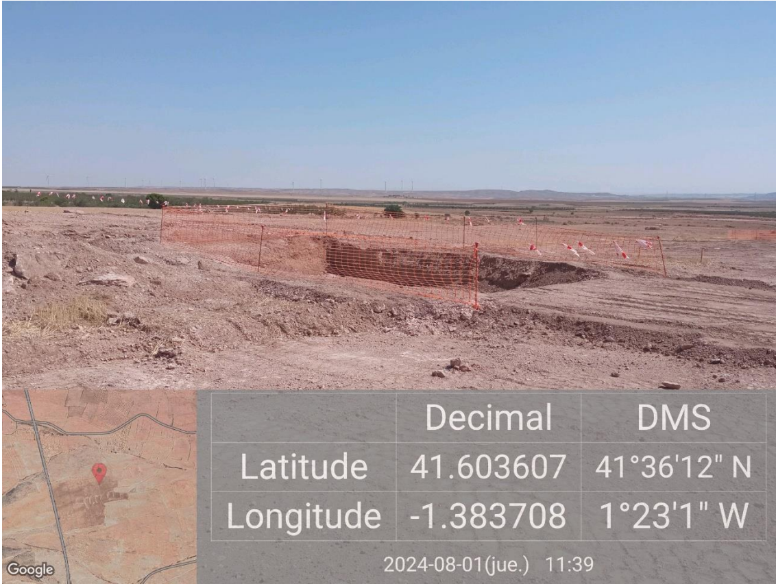
Ilustración 3. Balsa de limpiar hormigonado en plataforma 01
