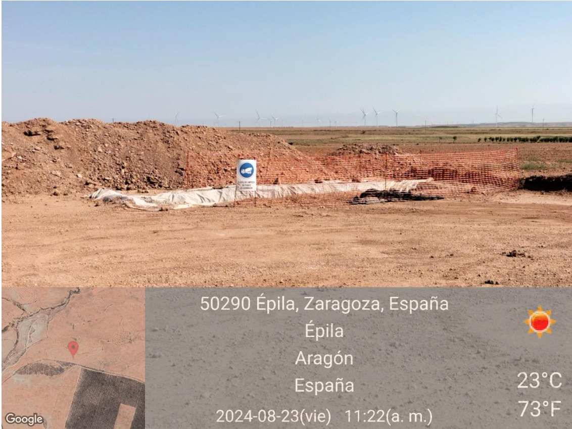
Ilustración 9. Balsa de hormigón de la plataforma 02.
