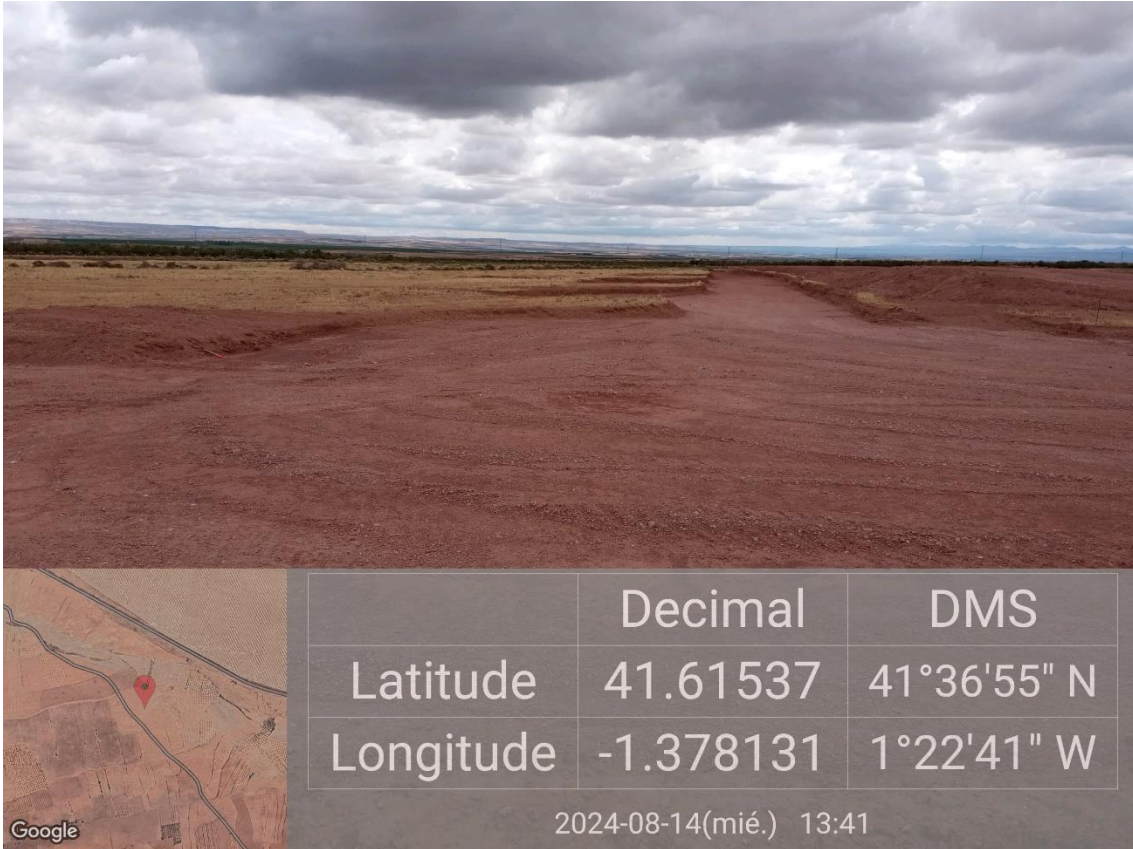
Ilustración 6. Desbroce dentro de lo establecido.
