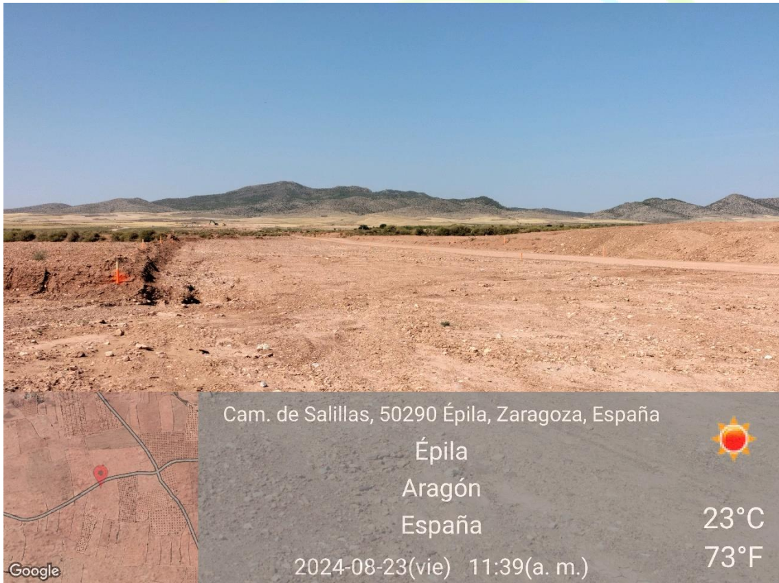
Ilustración 8. Balizado previo. Plataforma 0.
