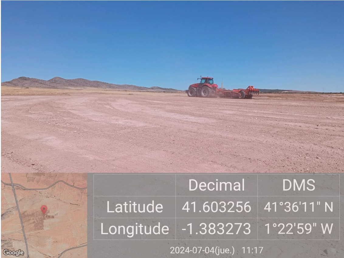
Ilustración 3. Retirada de tierra vegetal en la plataforma del aerogenerador 03.
