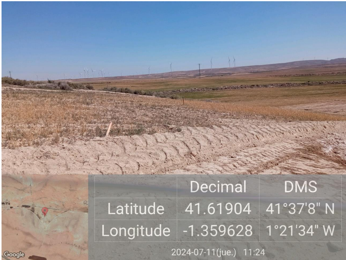
Ilustración 5. Balizado previo a movimientos de tierra de la plataforma 07.
