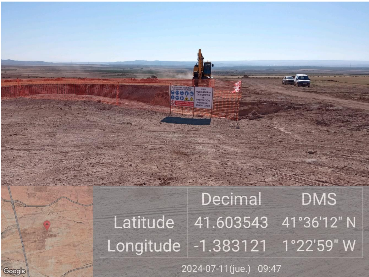
Ilustración 4. Señalizado de las obras en la plataforma del aerogenerador 03.
