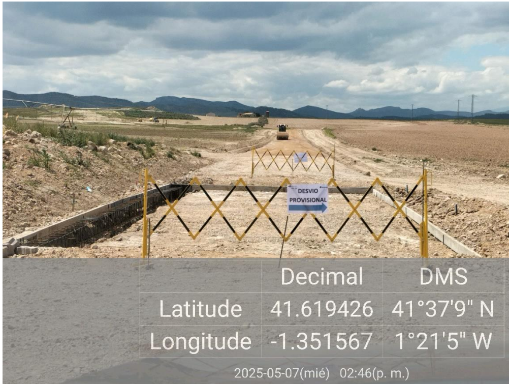
Ilustración 2. Desvío provisional por construcción de drenaje en la Visita 43
