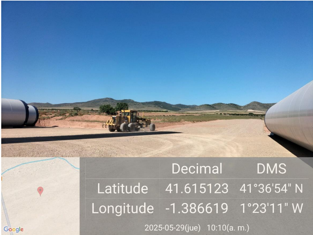
Ilustración 9. Máquina compactando el suelo para adecuarlo para el uso de la grúa, visita 46.
